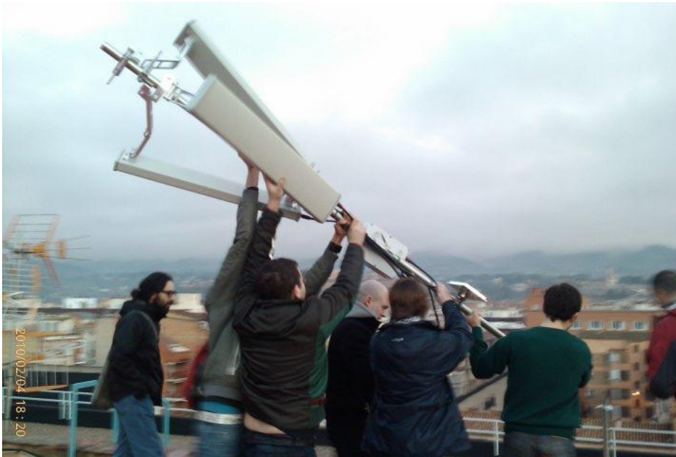
Momento del montaje de un nodo. Todos los enlaces son siempre en el exterior. El nodo de la imagen está compuesto por tres antenas sectoriales y una antena directiva.
