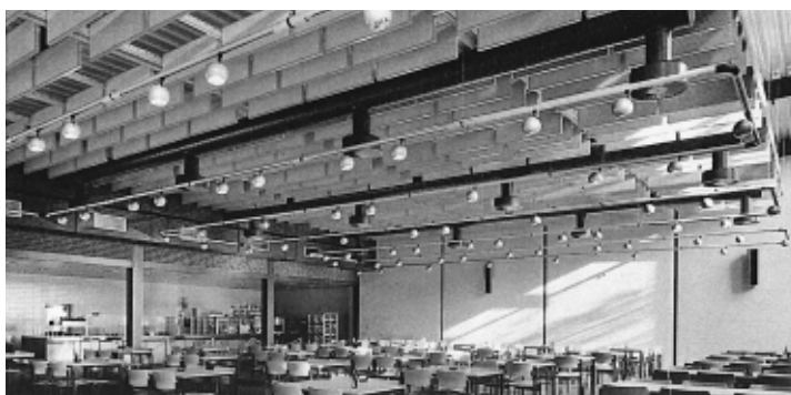
Fig. 2.18 Ejemplo de tratamiento acústico de un techo a base de baffles rectangulares absorbentes de lana mineral comprimida (Eurobaffles de Eurocoustic, Cristalería Española, S.A.)
