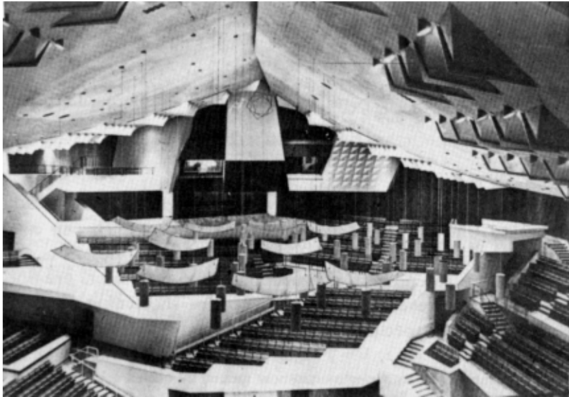
Fig. 2.39 Vista del techo de la Berlin Philharmonie (Alemania) con los resonadores simples de cavidad (Helmholtz) incorporados
