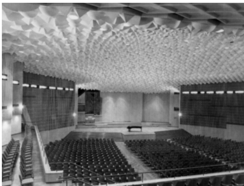
Fig. 5.37 Beethovenhalle, Bonn, Alemania (techo cubierto con una densa combinación de semiesferas, pirámides y cilindros truncados, y paredes laterales cubiertas con cilindros verticales)
