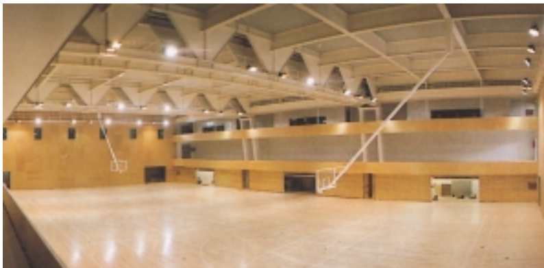
Fig. 3.9 Polideportivo del Campus Norte de la Universidad Politécnica de Cataluña, Barcelona (España)
