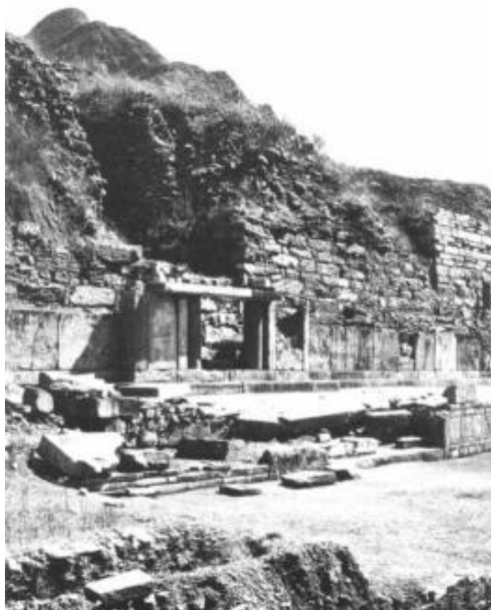
Fachada este del Nuevo Templo de Chavín de Huantar, Perú.
