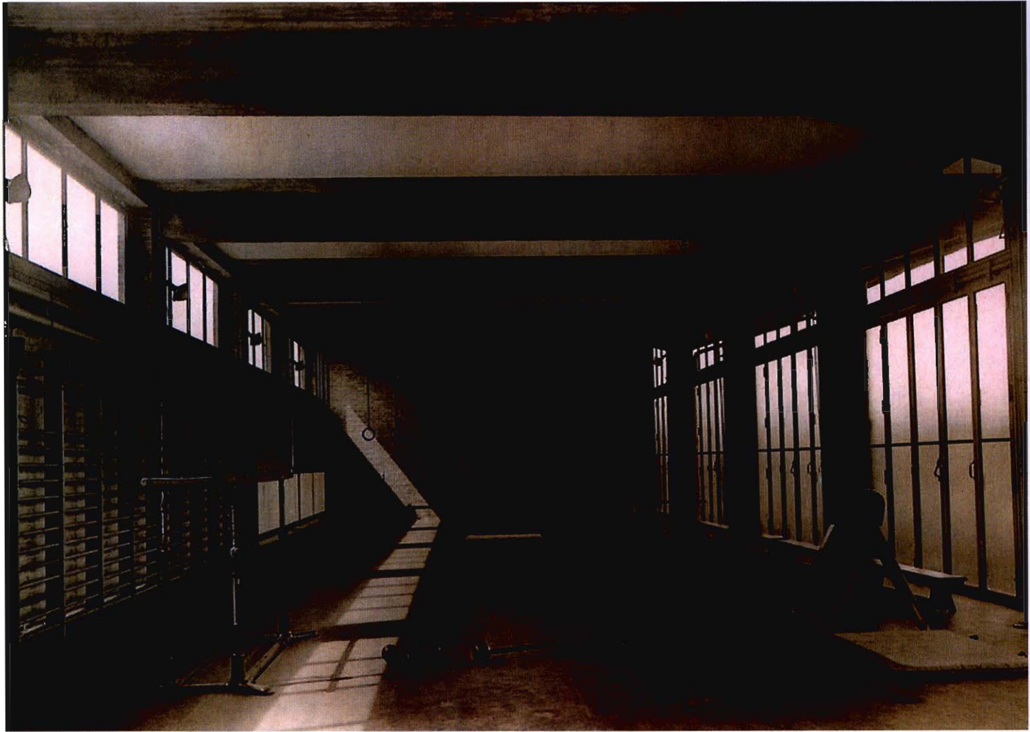
El gimnasio, cuyos amplios ventanales se abren a la naturaleza. Sobre el gimnasio hay aulas.
