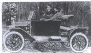
(arriba) El Modelo T Cabriolet de 1914 tan solo disponía de una capota de lona sin paneles laterales.
