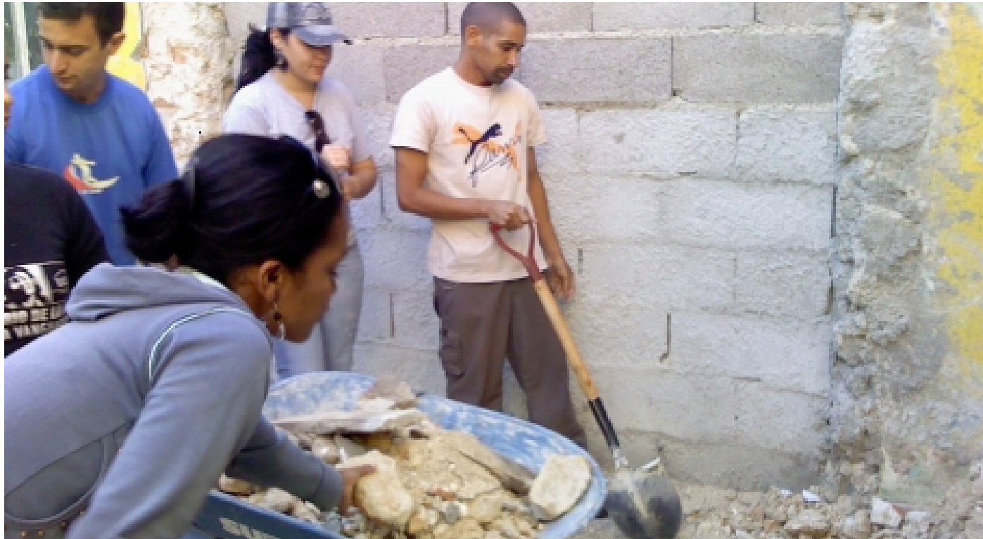
Reduciendo daños en las instalaciones.
