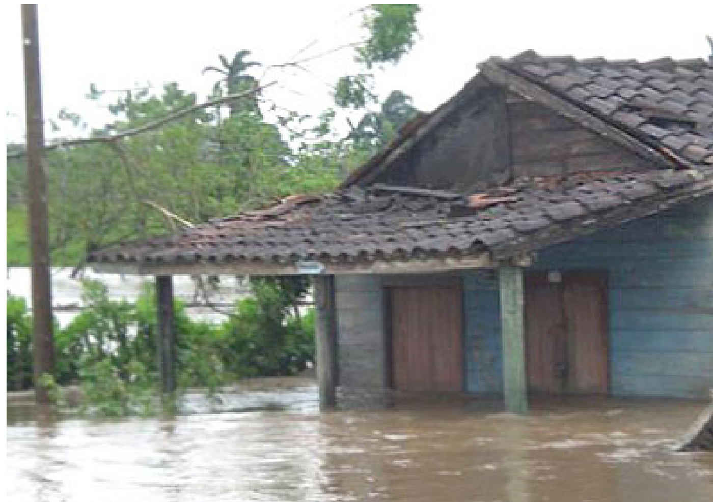
Inundaciones provocadas por intensas lluvias
