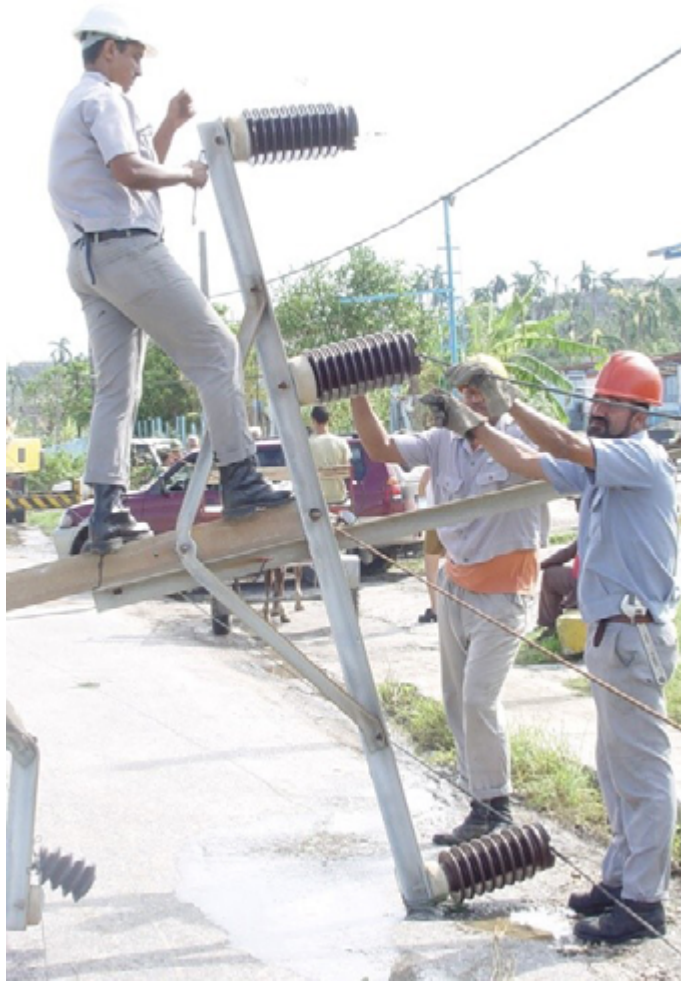
Rehabilitando el servicio eléctrico.
