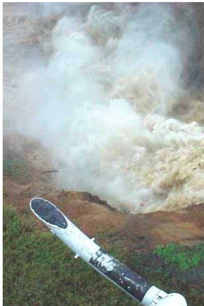
Vista aérea de la ruptura de una presa
