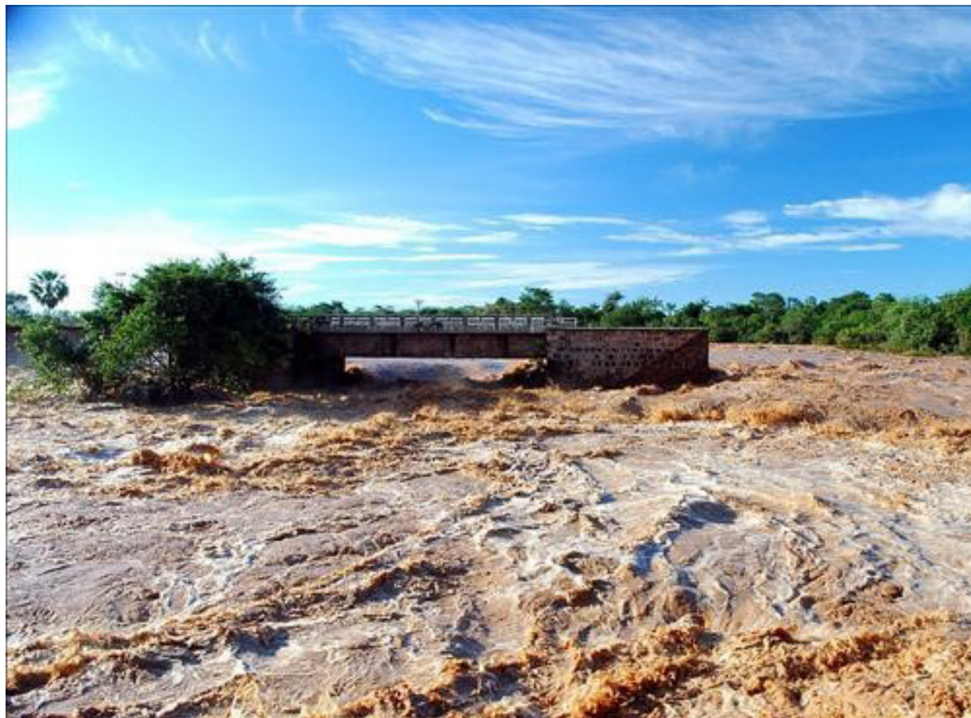
Aguas abajo de la presa
