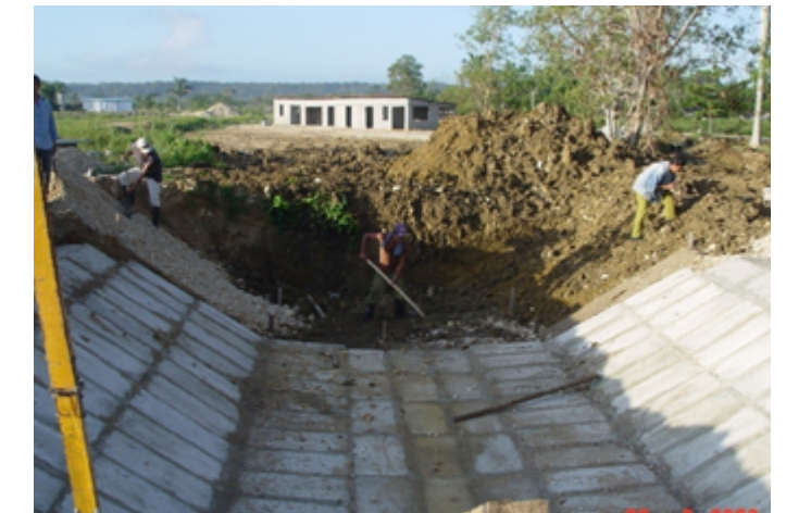
Preparación de desagües, zanjas y canales.
