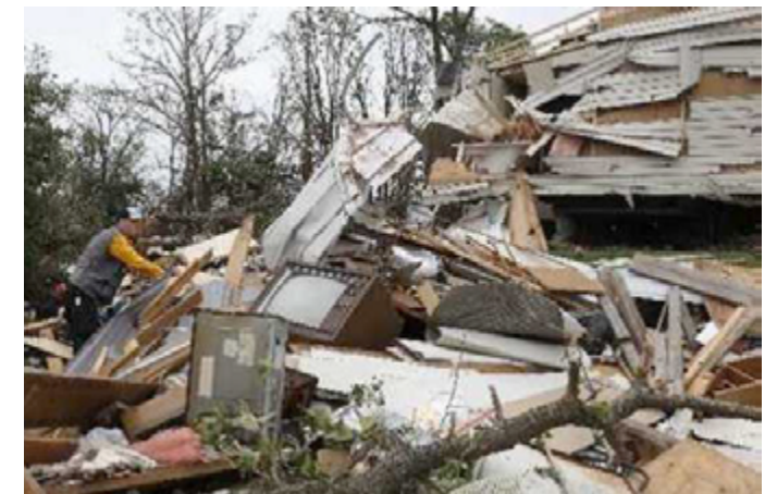
Daños provocados por un Tornado en Campechuela, Granma.
