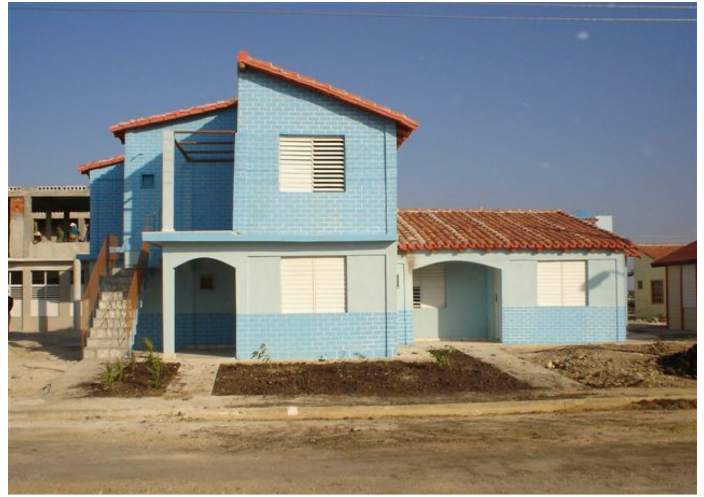
Construcción de viviendas para los damnificados.
