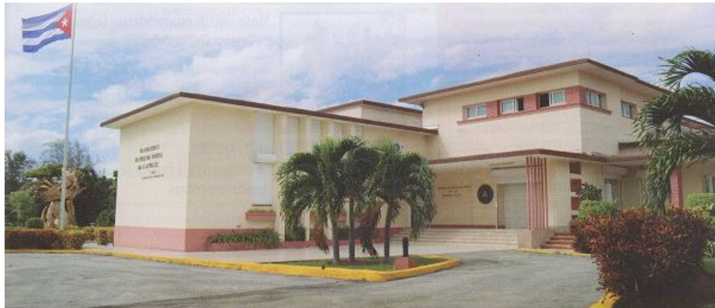
Edificio del EMNDC
