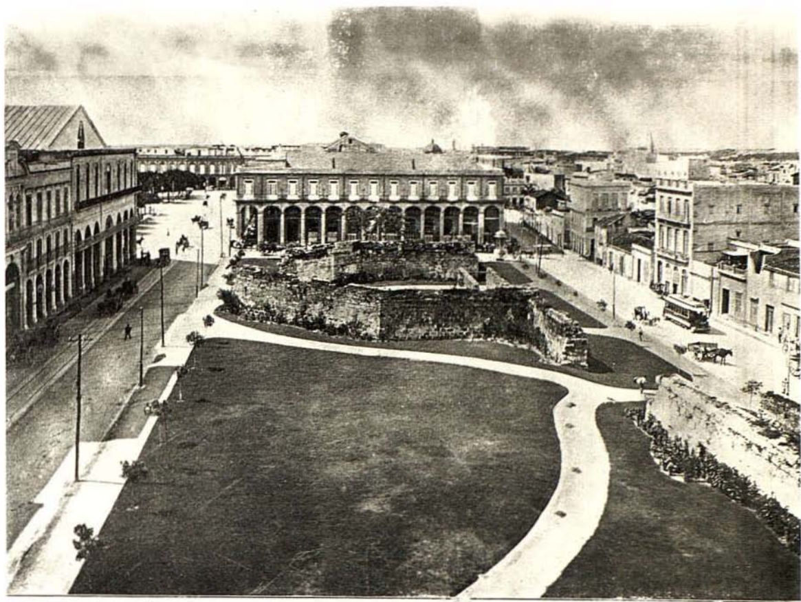
SECRETARÍA DE OBRAS PÚBLICAS. 1945. DEPARTAMENTO DE CONSTRUCCIONES CIVILES Y MILITARES.- RESTO DE LAS ANTIGUAS MU- RALLAS DE LA HABANA.
