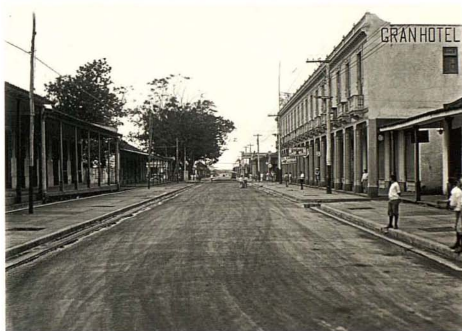
Calle de Manicaragua en 1947 (arriba). La Carretera Central por Placetas en 1930.
