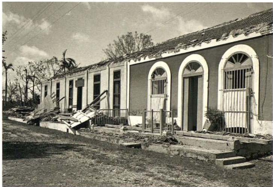
Ceiba Mocha: 1930, calle Matanzas (arriba). Daños causados en Cidra por el ciclón de 1948.
