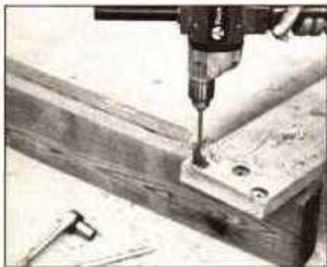
7. Quite los largueros y perforo agujeros de guía en los extremos para los espárragos que sujetan cabrios dobles en los extremos. Abocarde agujeros para que quepa la llave de cubo
