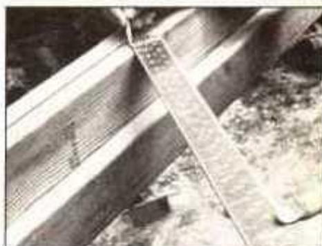
12. Para mantener los cabrios que estén perfectamente alineados, utilice una escuadra con la cual transferir la posición de los cabrios de las secciones centrales a las secciones inclinadas
