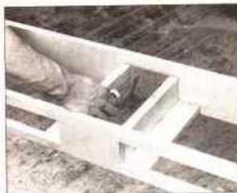
12 Las gavetas se sostienen con sencillas correderas de madera. Fije las correderas armadas de antemano de las gavetas a los faldones delantero y trasero con tornillos de 1.91 cm (3/4")
