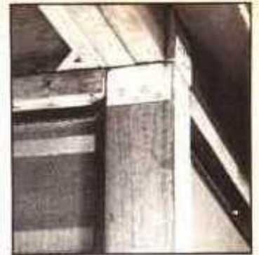
El detalle izquierdo muestra dos rieles superiores unidos a un poste con remate. El detalle de arriba muestra un conector de metal entre un poste y una viga. Note la esquina del suspensor de la viga (arriba, izquierda).
