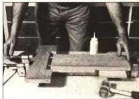
3 Con una guía espigadora haga agujeros de 0.95 cm (3/8") para los pasadores de espiga en el respaldar y el riel superior y encoile estas piezas
