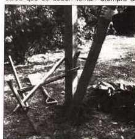
3 Rellene primero el hueco del poste y apisona el suelo con un riel sobrante de 2 x 4. A continuación siga añadiendo tierra y apisonela hasta que quede perfectamente a nivel con el suelo
