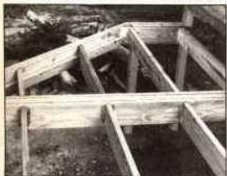
13. Instale los colgadores, corte los cabrios para que se ajusten bien y clávelos en sus sitios. Amueque los extremos de los cabrios en donde se unen a los largueros angulares
