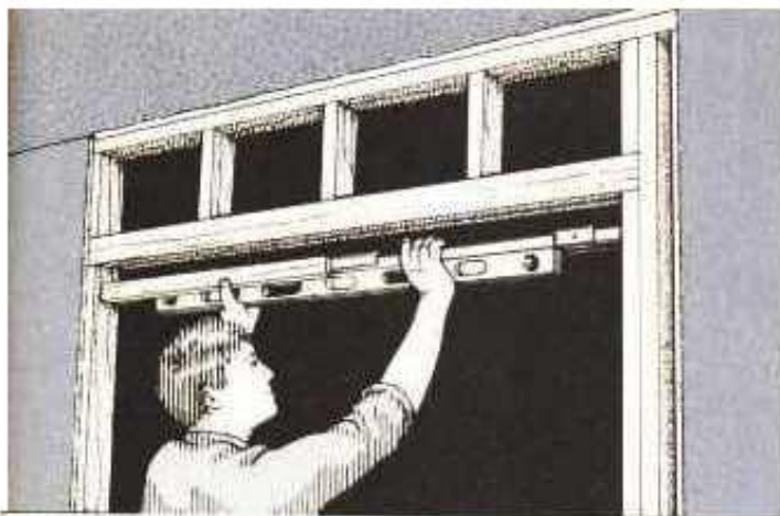
4 Una vez hecha la abertura general, introduzca clavos comunes 8d en los dos postes cortos, a la altura debida. Suspnda provisionalmente el carril de la tabla con clavos, y luego compruebe si el carril se encuentra a nivel
