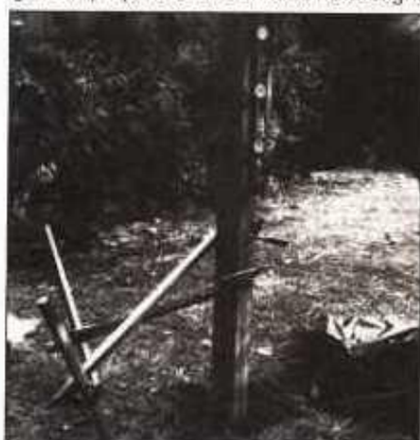
2 Sostenga el poste dentro del hueco con dos refuerzos diagonales asegurados a estacas introducidas en el suelo con anterioridad. Luego utilice un nivel para disponer el poste a plomada
