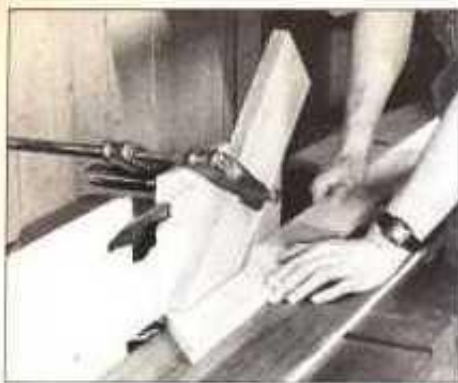
1 Forme ranuras en los bordes interiores de las piezas del bastidor. Las ranuras que tienen una medida de 0.63 cm (1/4") de ancho por 1.27 cm (1/2") dan cabida al panel del tablero de la mesa
