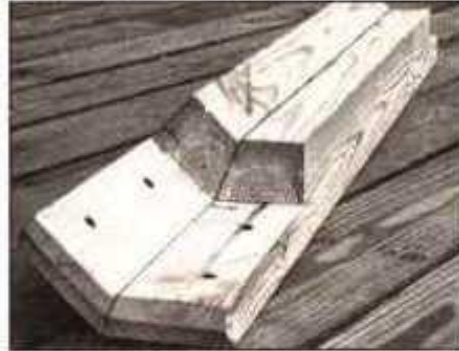
20. Una entre sí ambos lados del poste angular con tornillos de cabeza plana No. 12 de 8.89 cm (3 1/2"). Más tarde perforé agujeros de guía, abocárdelos y tapone las cabezas de los tornillos
