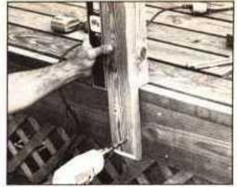
18. Coloque el poste amuecado en su sitio y nivélelo con una plomada. Luego perforé agujeros de guía para los espárragos. Finalmente instale estos últimos y apriételes firmemente
