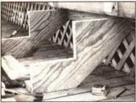
22. Clave listones de 2 x 4 a la viga de la terraza superior y a las tablas del piso de la terraza inferior. Corte los largueros de la escalera a su forma correspondiente y clávelos a los listones
