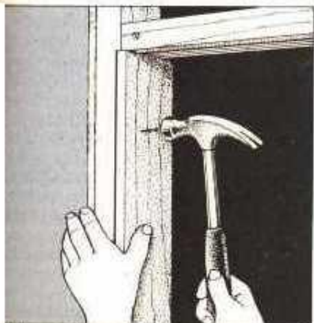
8 Clave la jamba debajo del carril al poste corto contra el cual se cerrar la puerta. Mantenga los bordes de la jamba al ras con la cara de la pared
