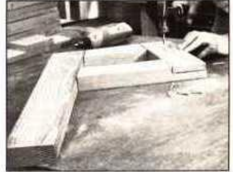
21. Corte las piezas de soporte de los bancos a tamaño correcto y corte todas las juntas de 1/2 traslapo que se requieren. Una las piezas con cola de resina plástica y clavos galvanizados
