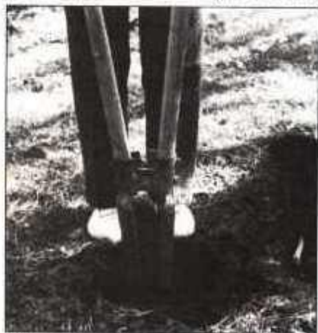
1 Primero cave todos los huecos para los postes a una profundidad de aproximadamente 76.2 cm (30") con una cavadora correspondiente. Esta herramienta manual es fácil de alquilar
