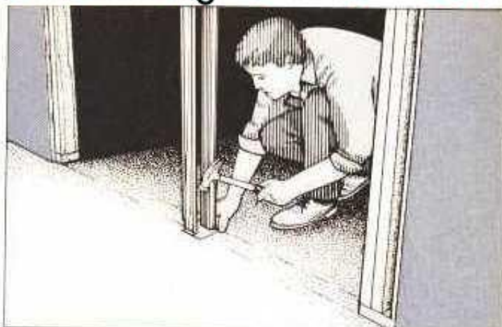
5 Con un cordn de entizar trace una lnea entre los extremos de las soleras inferiores y deslice la parte superior de la jamba dividida sobre el carril. Luego, centre el fondo de la jamba dividida entre las lneas de tiza
