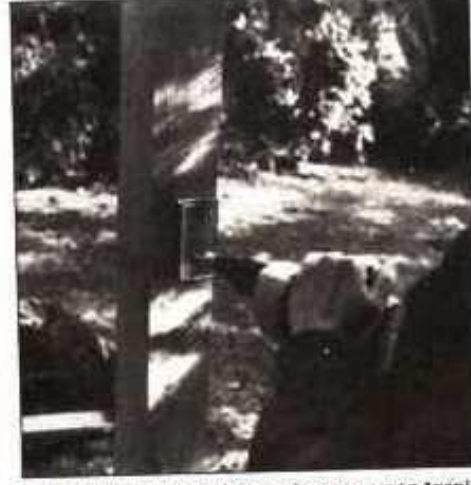
5 Fije los soportes a los postes con unos tornillos galvanizados de 3.17 cm (1 1/4") de largo. Recuerdese que la forma más fácil para introducir los tornillos es usando una pistola eléctrica
