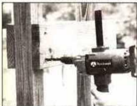
10. Fije con tachuelas los largueros para la terraza inferior a ambos lados de los postes. A continuación, perforo los agujeros de paso a través de las piezas para pernos de carrocería
