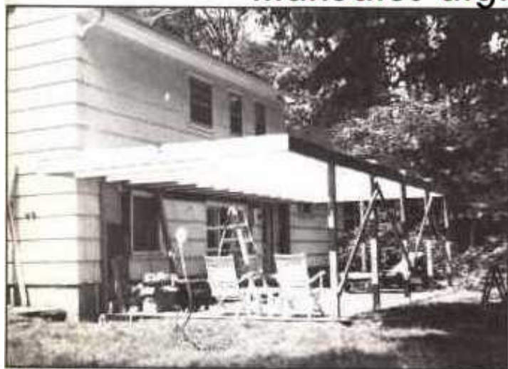
En esta vista se han instalado las vigas y los postes de soporte. Note los refuerzos diagonales en los postes durante la construcción de la armazón
