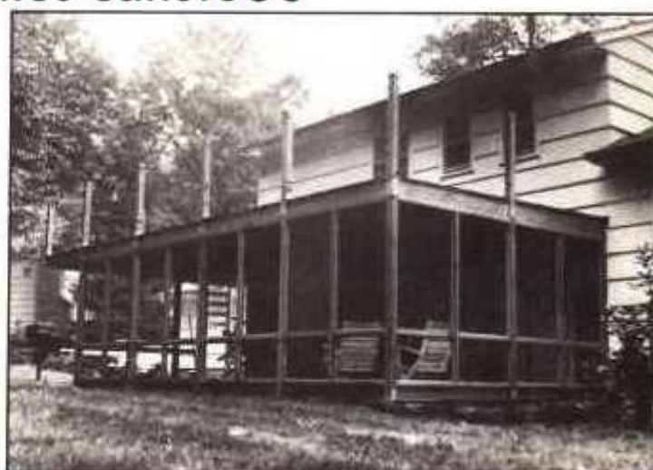
Ya terminada la armazón de la terraza inferior. Los postes de la barandilla en la cubierta superior están colocados e instalado el material de techo
