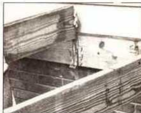
9. Fije los colgadores de los cabrios a los largueros con los clavos que se proporcionan. Corte los cabrios a su largo correcto, colóquelos en los colgadores y clávelos en sus sitios
