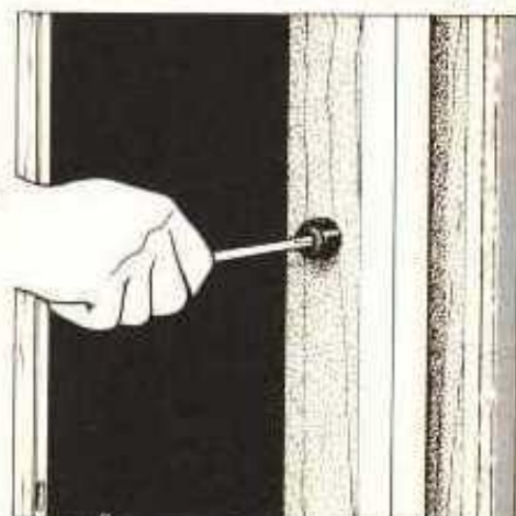
7 Fije una defensa de caucho al poste corto opuesto a la jamba ya terminada. Coloque las calzas requeridas para que la puerta cierre al ras
