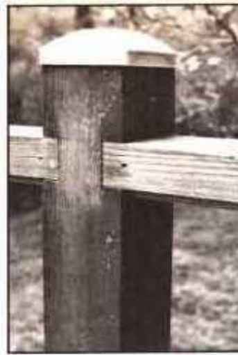
El detalle izquierdo muestra dos rieles superiores unidos a un poste con remate. El detalle de arriba muestra un conector de metal entre un poste y una viga. Note la esquina del suspensor de la viga (arriba, izquierda).
