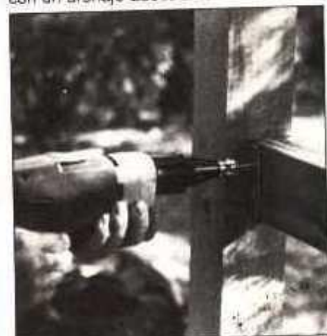
6 Coloque un riel de 2 x 4 en el soporte y más tarde perforé agujeros de guía para impedir que la madera se astille. A continuación fije el riel con tornillos galvanizados de 3.17 cm (1 1/4")
