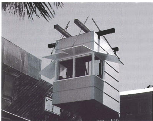
Contraventanas que actúan como parasoles
