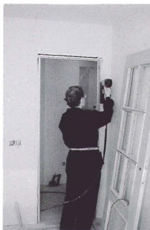
Fijación lateral con grapas, del cerco al prearco
