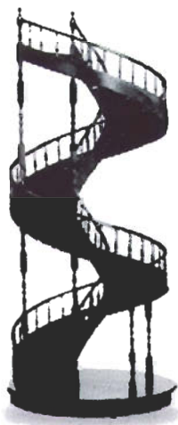
Escalera autoportanto de caracol
