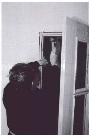
Fijación directa a través del cerco
