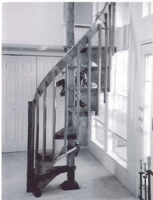
Escalera a la inglesa en sistema de entramado ligero a base de tablero contrachapado estructural. Su construcción in situ es muy sencilla
