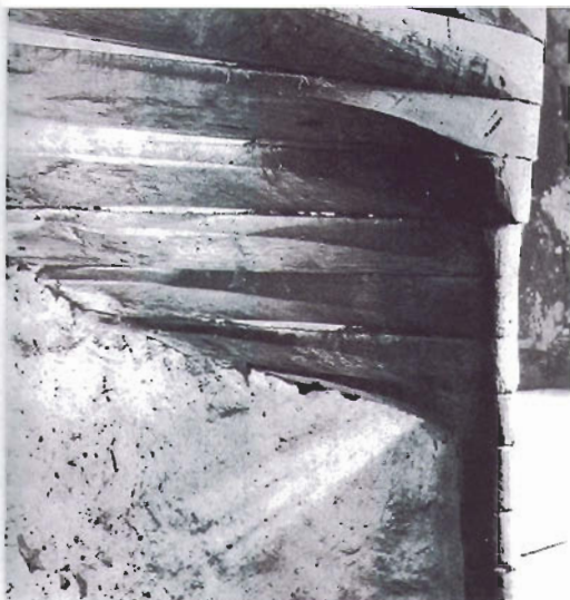
Escalera de caracol de peldaños apilados de madera
