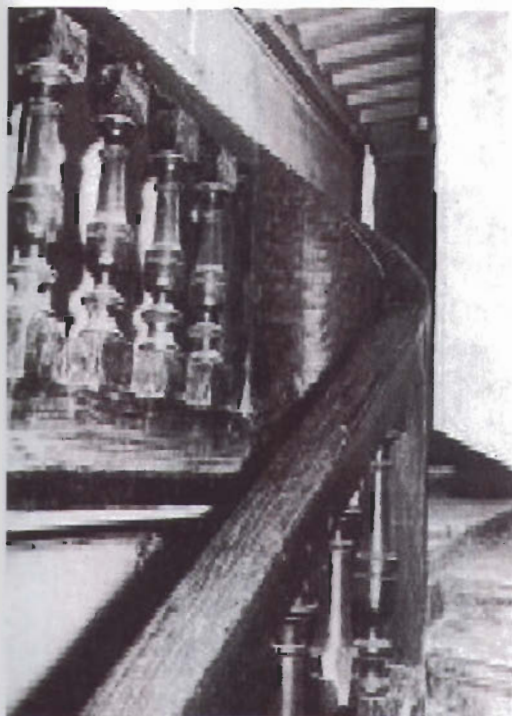
Escalera de cubillos
