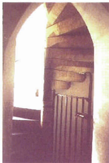
Escalera de caracol de la Torre de Londres
