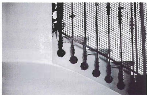
Apoyos en en escaleras a la inglesa con perfiles más suavizados (Siglo XIX)
