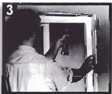
3 Abrir la hoja y poner el primer tirafondos a través de la jamba en el lado de las bisagras tan cercano a la esquina como sea posible. Asegurarse de atravesar las cuñas.
