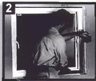
2 Con una escuadra, escuadrar las jambas laterales ajustando las cuñas. Acuñaar el resto de la ventana
