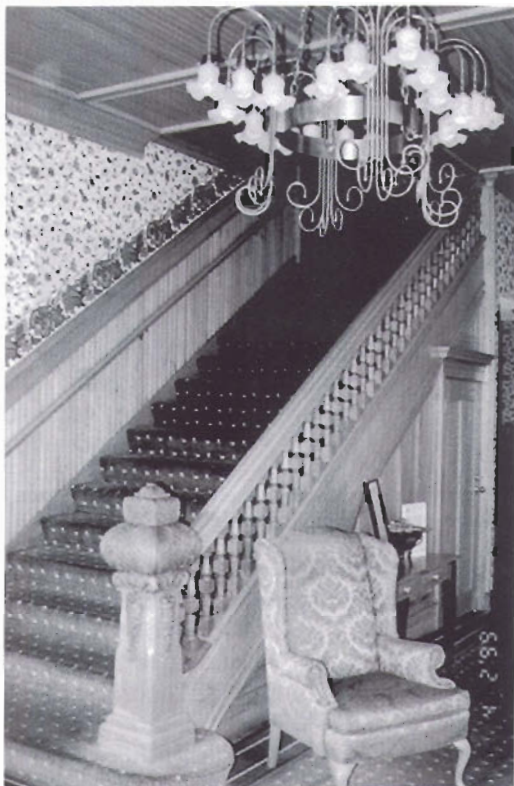
Peldaños compuestos forrados de moqueta. No se usa vuelo para facilitar su colocación.
