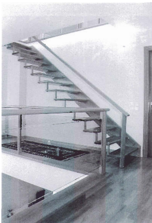
Escalera en voladizo
