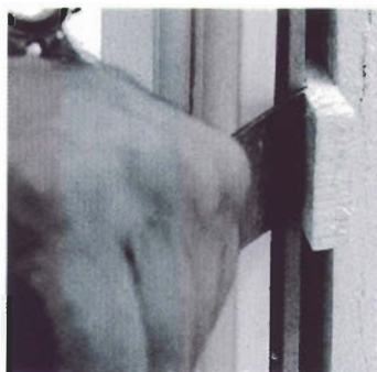
Eliminación del resto de cuñas
