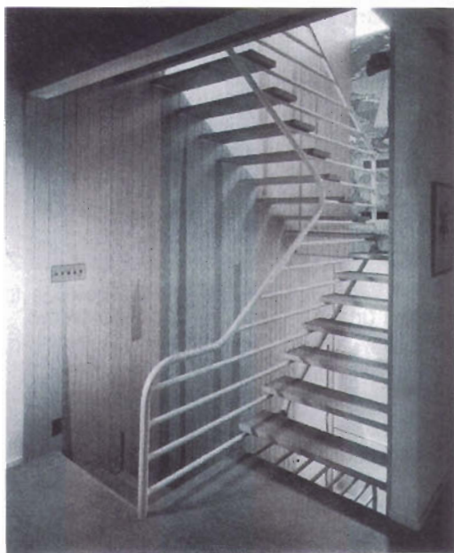
Barandilla portante de Marcel Breuer. Hagerty House 1940
