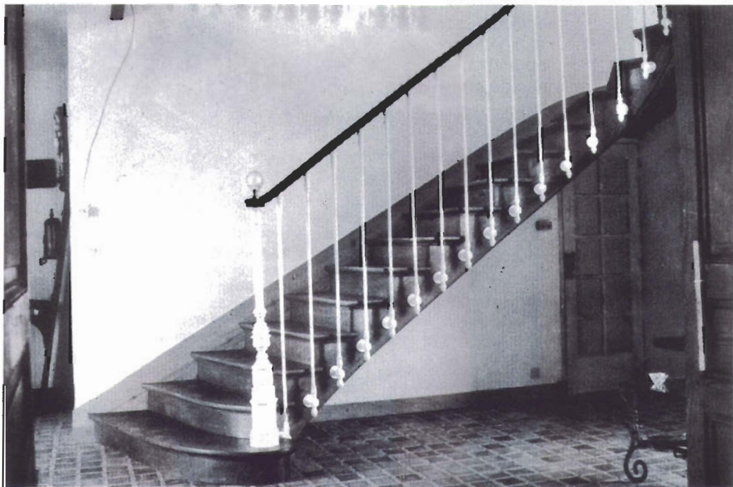
Aspecto clásico de una zanca a la inglesa: silueteado dentado y la huella que se marca lateralmente con un moldurado importante
