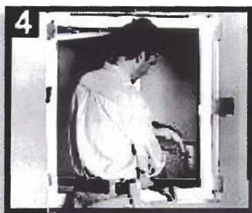
2 Con una escuadra, escuadrar las jambas laterales ajustando las cuñas. Acuñaar el resto de la ventana
