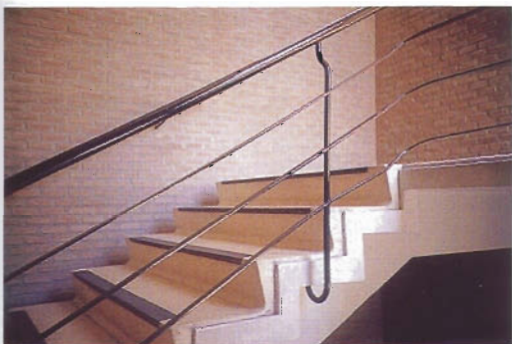
Escalera racionalista. Dominicos de Alcobendas. Miguel Fisac, 1955.
