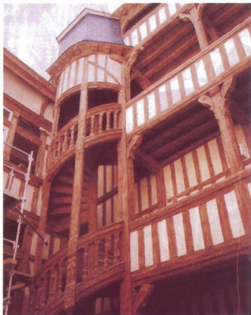
Rampa curva en una escalera de caracol Edificio de entramado de madera medieval
