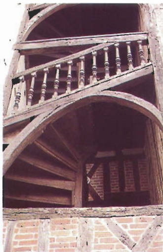
Escalera medieval de rampa exterior sobre pilar central (dos izquierda) y escaleras de rampa exterior posterior (derecha)
