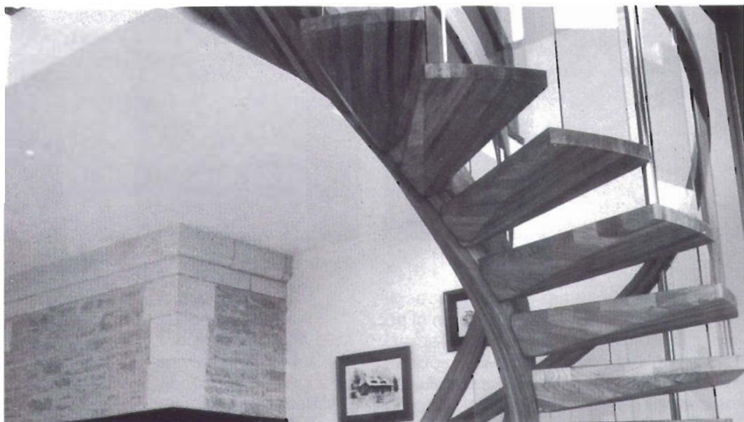
Empotramiento de peldaños de madera laminada en zanca helicoidal, también laminada
