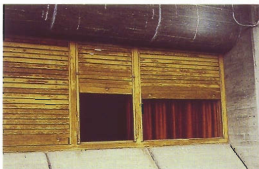
Persiana enrollable en cajón superior. Miguel Fisac (Colegio de la Asunción. Madrid)
