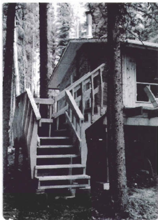
Escalera de dos tramos
