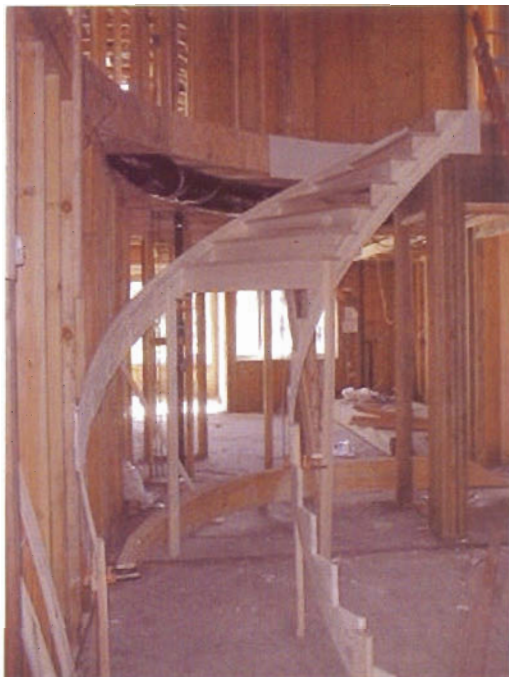
Escalera con zanca alistonada
