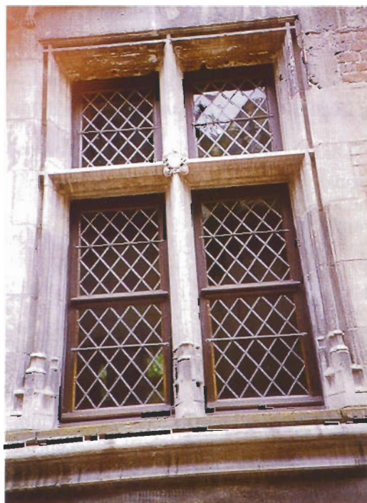
Ventana de maineles de piedra en un chateau del Loira. Se aprecia el vierteaguas redondeado
