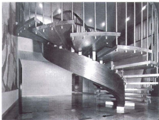
Unión de peldaños a la zanca con ensamble (arriba) y a través de una pieza metálica intermedia de cajón (abajo)
