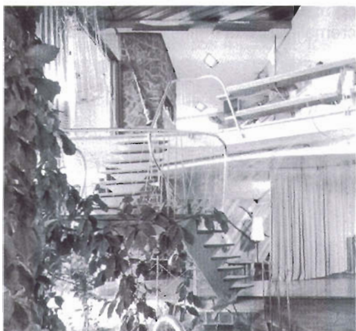
Zanca central de madera aserrada (derecha) y metálica (izquierda)
