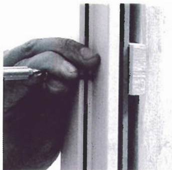
Fijación mediante atornillado
