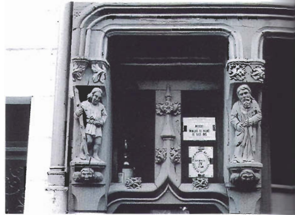
Ventana medieval francesa original con acabado a base de pintura
