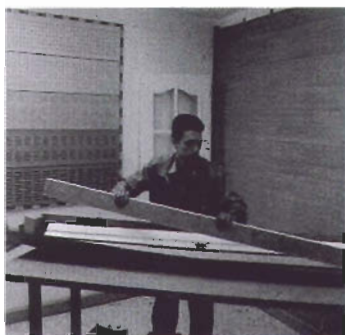
Armado del cerco que viene en forma de kit con llaves de plástico
