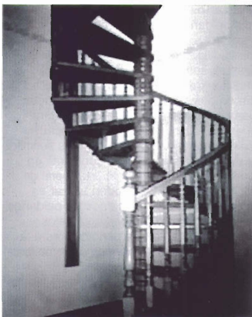
Peldaños radiales, tangenciales al núcleo
