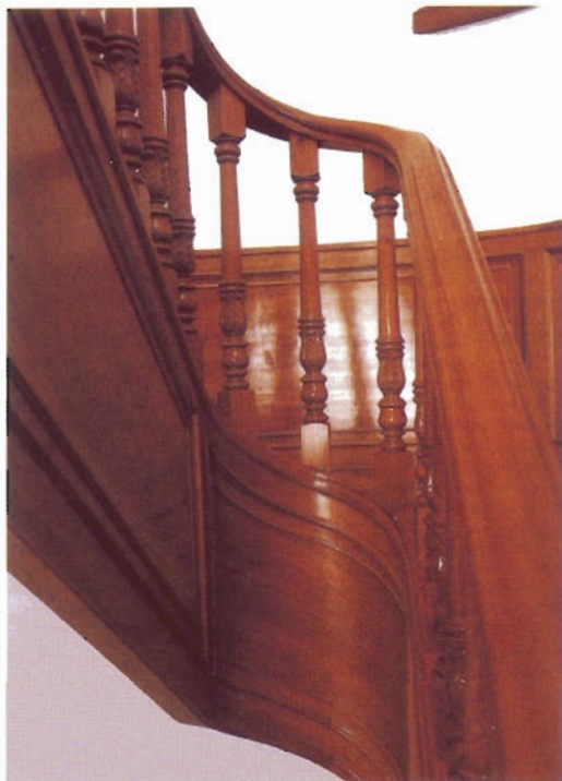
Escalera de zanca chapa laminada con acabado de chapa noble
