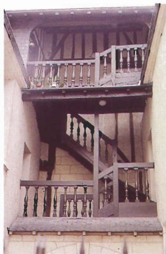
Escalera medieval de rampa exterior sobre pilar central (dos izquierda) y escaleras de rampa exterior posterior (derecha)
