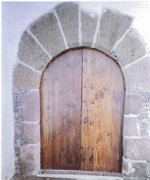
Puerta entablada lisa (las juntas van machihembradas)
