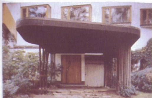
Ventanas en voladizo de Villa Mairea de Alvar Aalto (1938)
