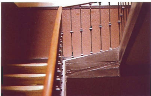
Prolongación de zanca para empotrar en la pared de la caja
