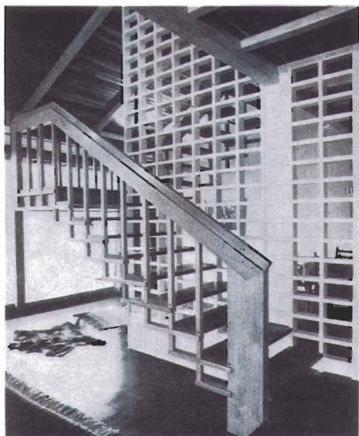
Barandilla portante en madera aserrada
