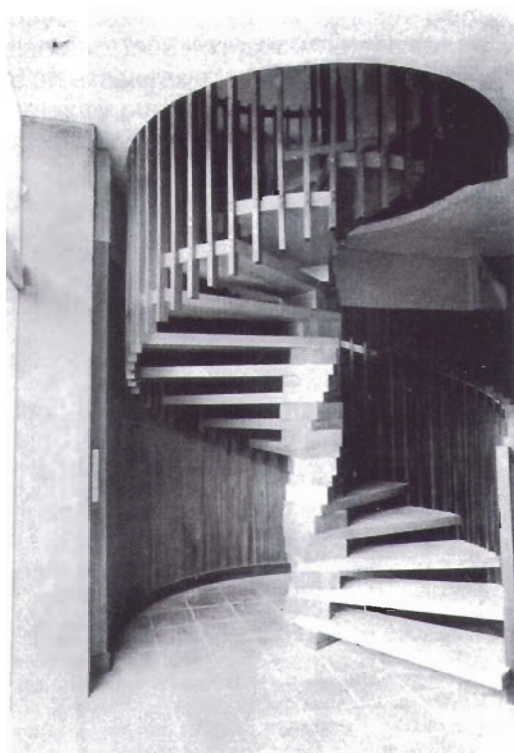
Escalera de directriz helicoidal por apilamiento de piezas cuadradas. Los peldaños son de madera maciza de pino Oregón. Por ser una especie relativamente blanda, se fajeó con moqueta
