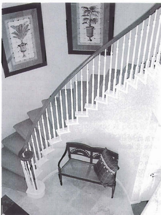
Peldaños radiales circulares de eje exterior a la rampa
