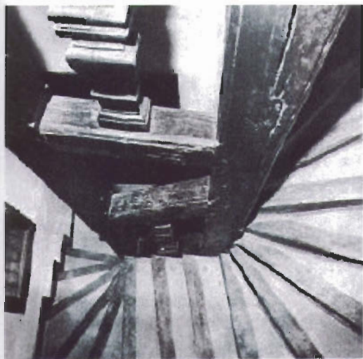
Escalera de barandilla superpuesta de rampa corta
