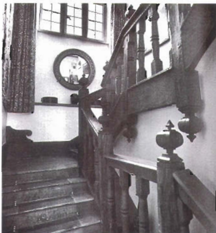
La continuidad de la rampa se ve comprometida por resaltes y esquinas de pilaretes
