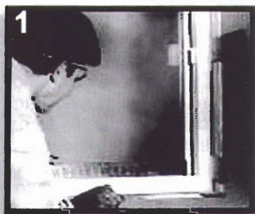
1 Insertar la ventana en el hueco acuñaando horizontalmente la peana al durmiente del hueco
