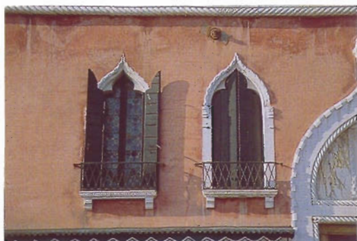
Persianas rústicas rigidizadas con tablas horizontales
