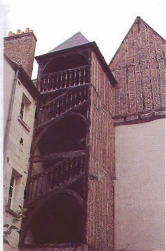
Escalera medieval de rampa exterior sobre pilar central (dos izquierda) y escaleras de rampa exterior posterior (derecha)
