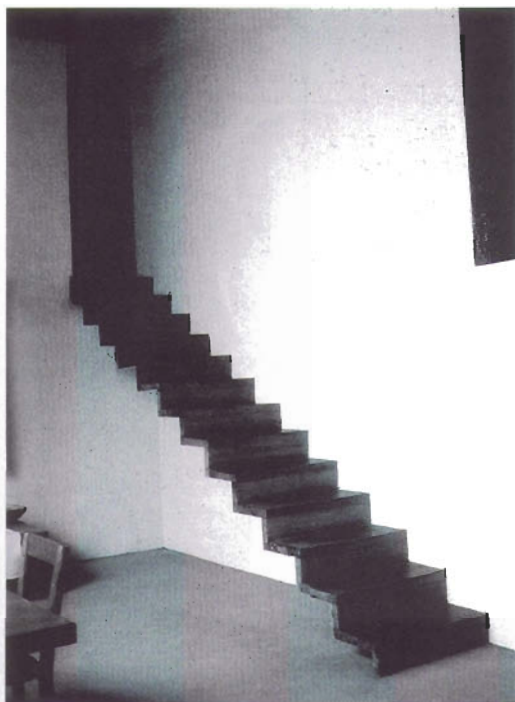
Escalera de peldaños compuestos empotrados. Casa-Estudio de Luis Barragán (México, 1947)
