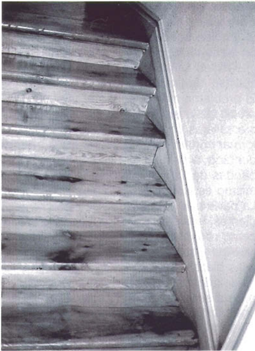
Tres distintos tipos de rodapiés: triángulos más rodapié continuo, silueteado de los peldaños y pieza recta con silueteado inferior
