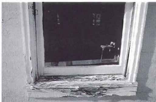
La degradación de la peana es una de las patologías más clásicas
