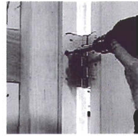
Colocación de la bisagra
