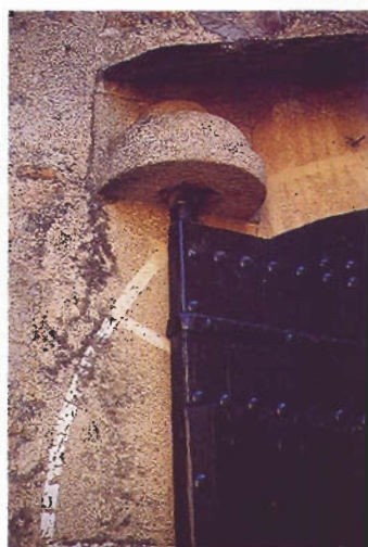
Quicialera exenta del muro. Cazoleta superior
