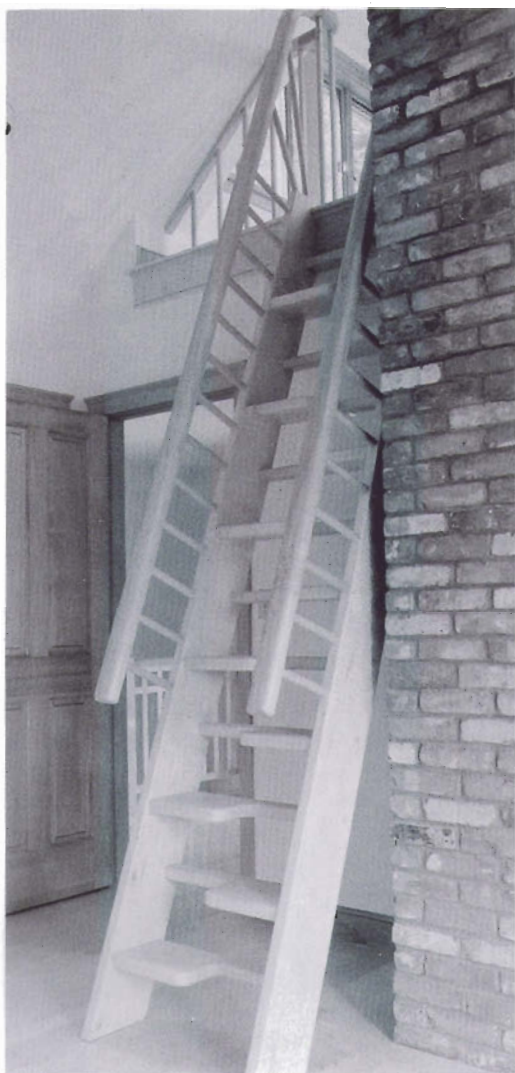
Escalera a la molinera con peldaños alternos
