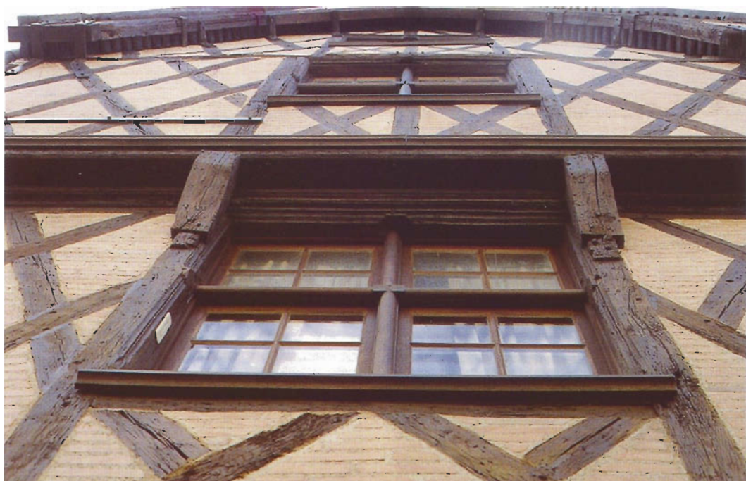
Ventanas renacentistas francesas en una casa de entramado de madera. En este caso las vidrieras originales se han sustituido por cristales ordinarios. Los maineles son de madera, a diferencia de los edificios nobles.
