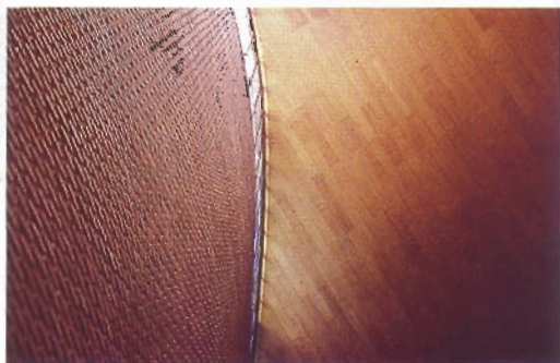
Cristalera que remata el muro en la iglesia de los Dominicos de Alcobendas (M. Fisac, 1955)
