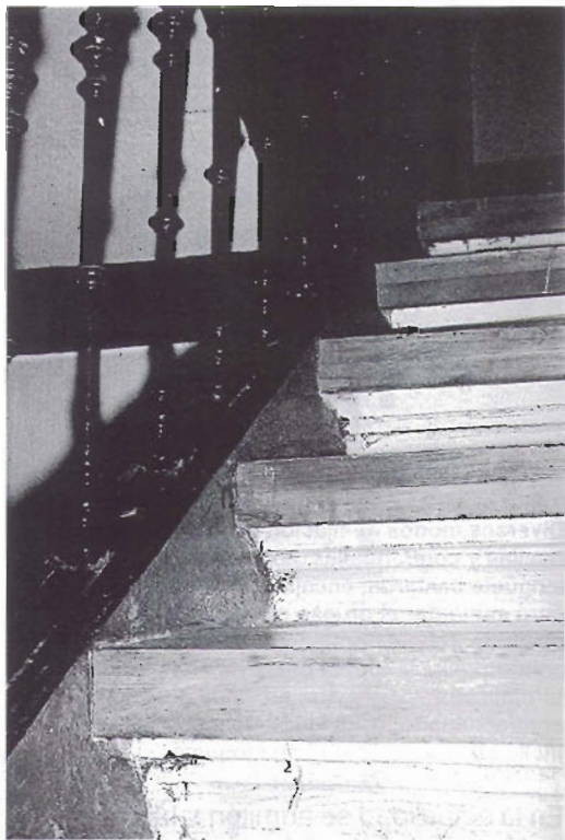
El moldurado debajo del perfil hace ganar visulamente a la escalera
