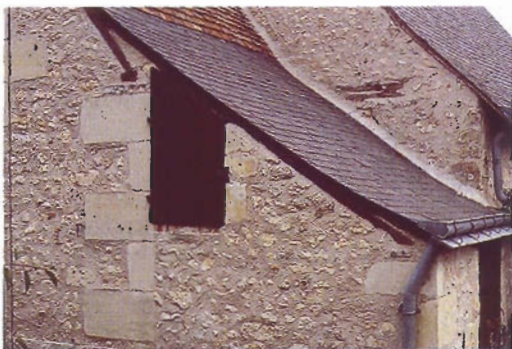
Persianas rústicas rigidizadas con tablas horizontales
