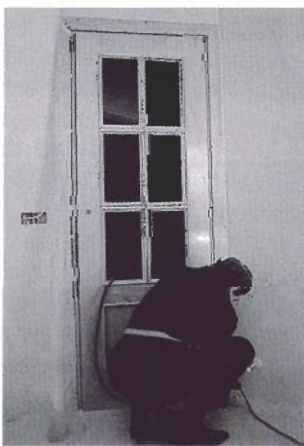
Colocación de tapajuntas
