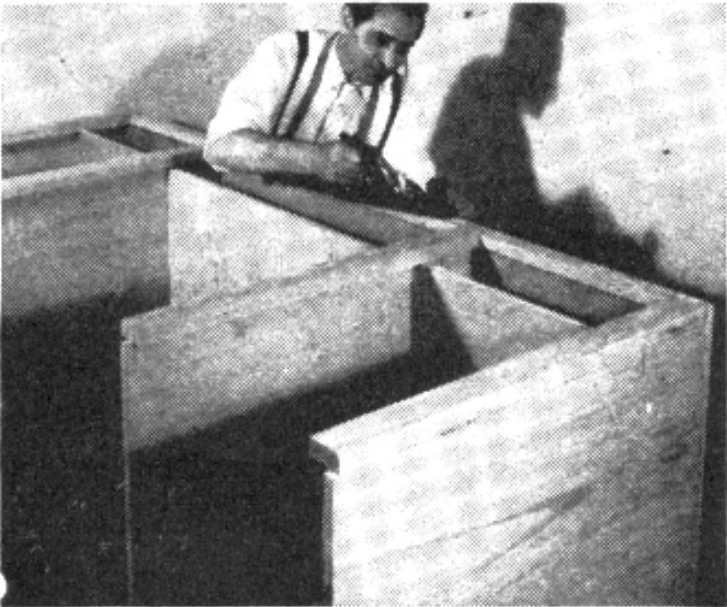
FIG. 4: Las abrazaderas son para sostener lados y divisiones en su lugar y unirlos al panel inferior. Use cola y tornillos.
