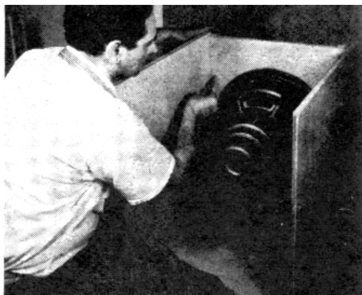
FIG. 12: La bocina se fija al agujero del panel con pernos de carrocería. Luego, el panel se atornilla al bastidor del gabinete.
