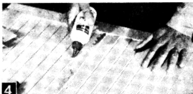
Para hacer paneles laterales enlistados, aplique alguna sustancia adhesiva a lo largo de las líneas trazadas sobre la contraplancha de madera.
