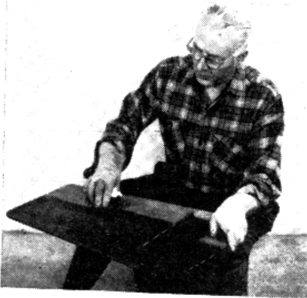
Fig. 7. Aplique tinte de aceite con brocha o con un lienzo suave a lo largo de la fibra de la madera. Cubra un panel cada vez eliminando el exceso de tinte con un paño.
