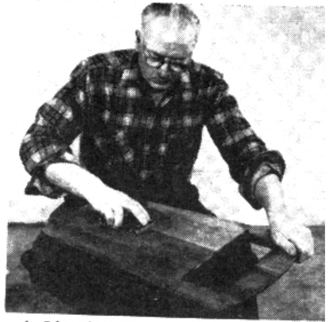
Fig. 4. Limpie la superficie con un paño humedecido con aguarrás. Estos pasos serán necesarios cuando se trabaje con muebles viejos; los siguientes son para todo
