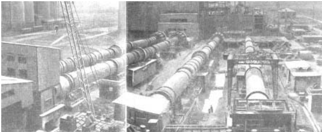
Figura 14.1 Vista general de una fábrica de cemento
