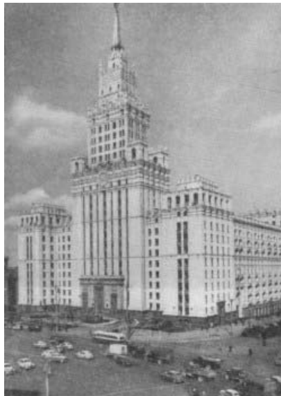
Figura 27.1 Edificio de gran altura en Moscú, en la plaza Lérmontov, revestido de calizas blancas de las cercanías de Moscú
