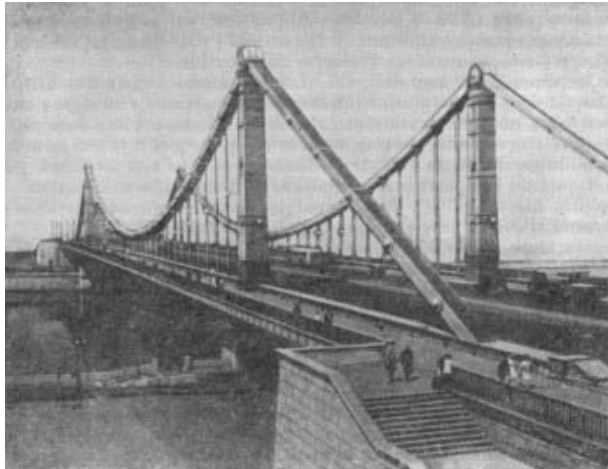
Figura 33.4 Moscú. Puente de Crimea, construido de duraluminio
