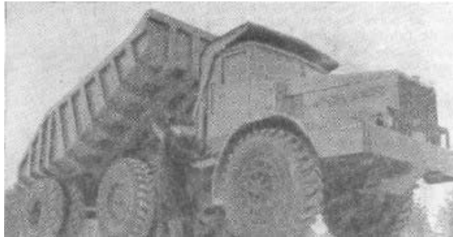
Figura 23.3 Camión de 40 t. de capacidad
