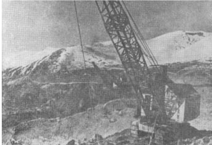
Figura 24.9 Los excavadores abriendo un arenal aurífero
