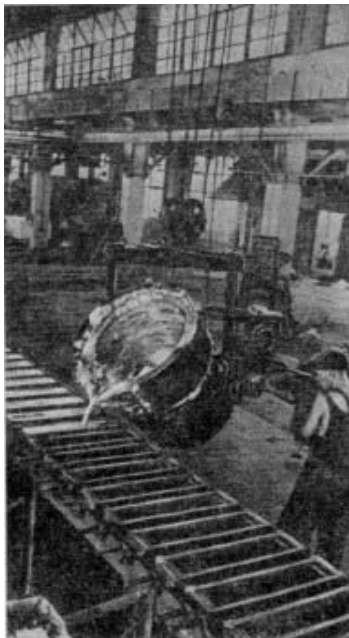
Figura 21.7 Vaciado en moldes del aluminio en un taller de fundición
