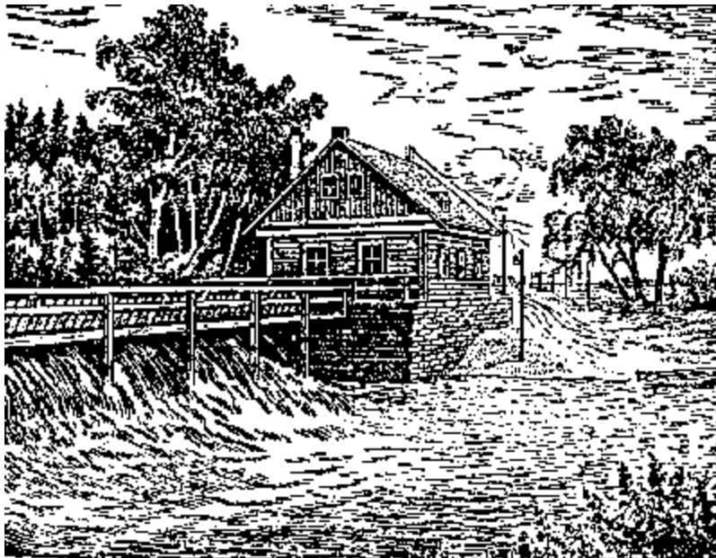
Figura 43. Estación hidráulica con potencia de 80 kilovatios de una artel agrícola de Burmakin; da energía para los siete koljoces.
