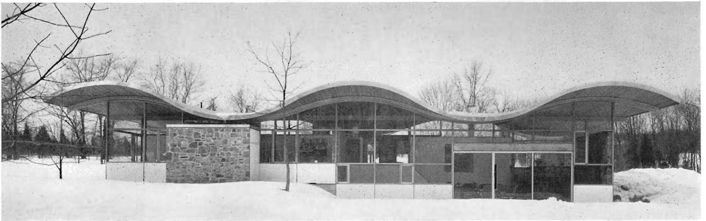
Die Konstruktion besteht aus schlanken Holzpfosten und verleimten Balken. Alle Wände sind nichttragend und nur 2,15 m hoch. Darüber sind zur Decke feste Verglasung. Zwei Scheiben aus Naturstein wirken als Windaussteifung.
