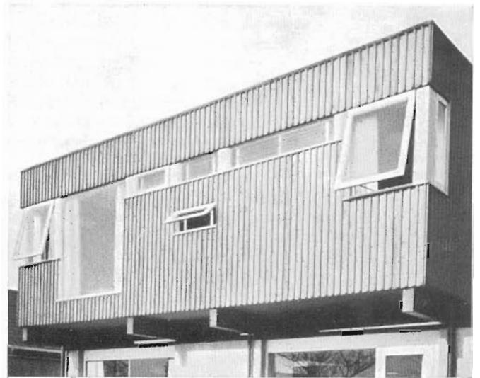
Figura 3. — La fachada de esta casa es un revestimiento vertical sin alero. Las ventanas se colocaron una vez casi concluida la fachada y, por lo tanto, completamente expuestas a la influencia de la intemperie.
