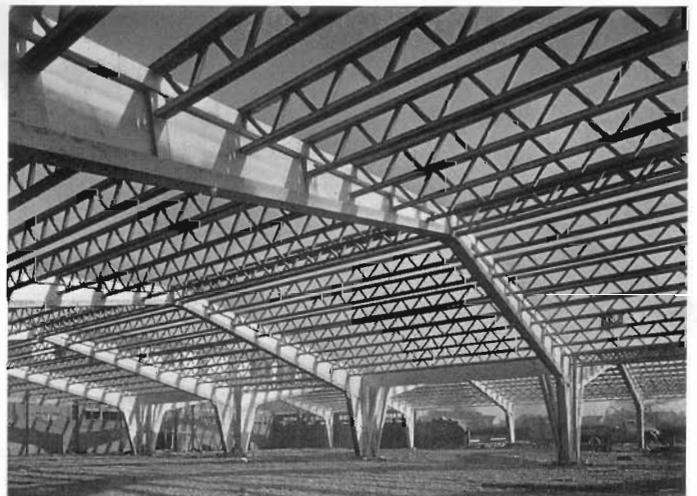
Vigas de alma reforzada unidas con correas CPT. Almacén de dos naves. Luz libre entre pies derechos de 21,60. Separación entre las vigas: 8 m. (Reproducción autorizada por la Bruderverlag, Karlsruhe.)
