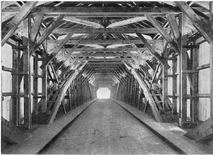
Construcción de madera con cuñas. Puente sobre el Rin, en Salez, 1928. Luz de 3 x 50 m. Proyecto y dirección del Ing. W. Stäubli, Zurich (EMPA, Construcción de puentes, andamios y grandes edificios de madera en Suiza. Zurich, 1936).
