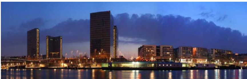
Fig. 3. Bibliothèque Nationale de France. Architect: Dominique Perrault
