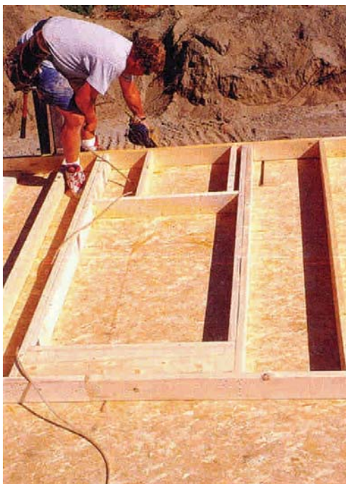
Figura 10 - 27: La calidad de la madera utilizada es esencial para la prefabricación de los entramados verticales, ya que de ello depende fundamentalmente la durabilidad y estabilidad de los elementos en servicio.
