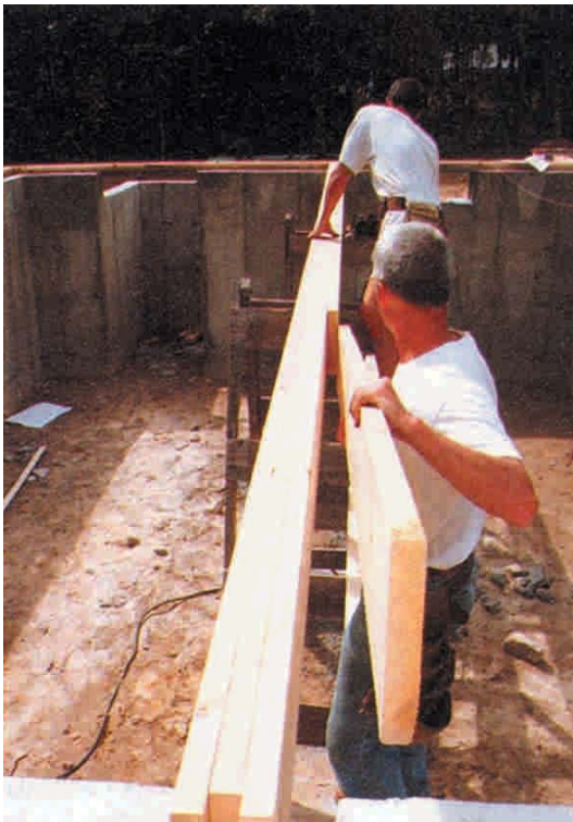
Figura 9 - 56 : Ubicación de la cuarta pieza de Pino radiata grado estructural que conforma la viga compuesta de escuadría final de 6"x 8", las que se deben traslapar en un tercio de su largo y lograr la pieza requerida.
