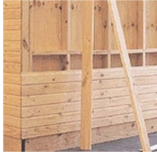
Figura 1 - 75: Moldura usada en forma horizontal para el revestimiento exterior de tabiques.
