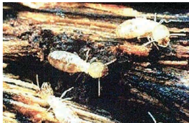
Figura 2 - 10: En la imagen se observan termitas subterráneas en pleno ataque a una solera de un tabique.
