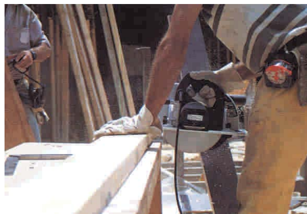
Figura 4 - 8: Protección de manos al efectuar cortes en la madera con sierra manual.
