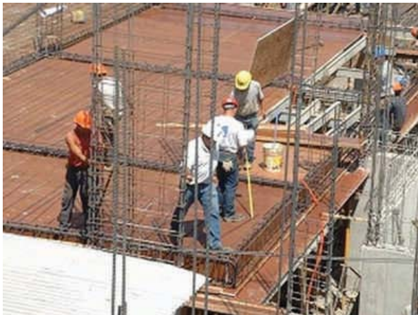
Figura 1-85: Ejemplo de aplicación de tableros contrachapados en moldajes para elementos de hormigón armado.
