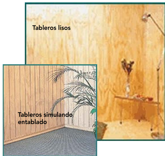
Figura 19 - 23: Revestimiento con tableros contrachapados.
