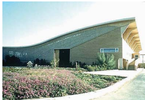
Figura 1 - 95: Aplicación de la madera laminada en estructuras de grandes luces, construcción industrial, arquitecto José Cruz Ovalle.
