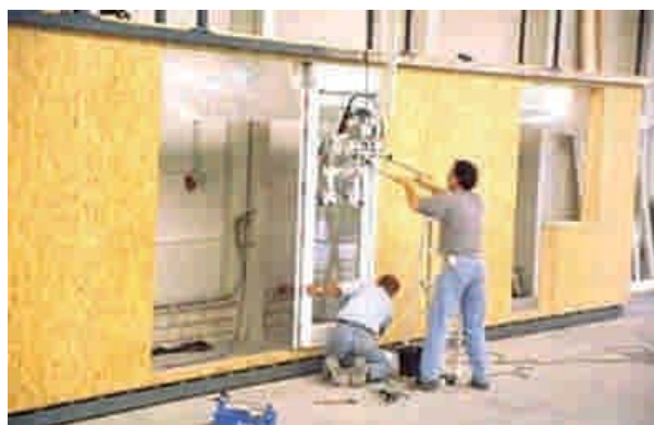
Figura 6 - 4: Instalación de una puerta a un tabique autosoportante.
