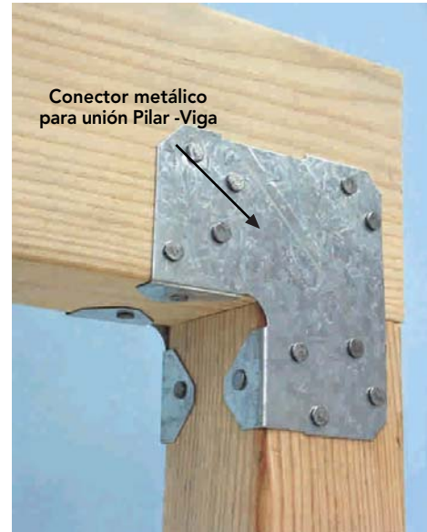
Figura 9 – 45: Conector metálico que une vigueta de plataforma de terraza con pilar.
