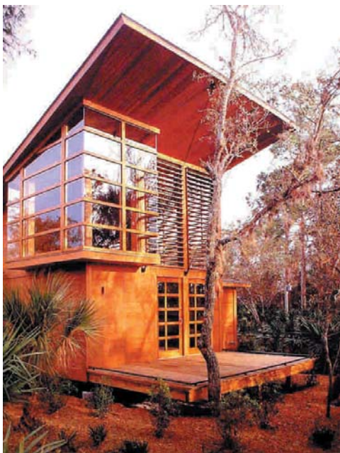
Figura 4-1: Toda obra de arquitectura ofrece riesgos de accidentes durante su ejecución.
