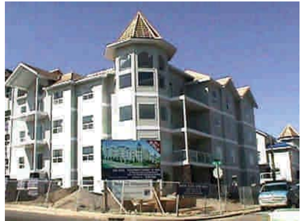
Figura 1 - 2: Edificio de departamentos multifamiliar de cuatro pisos estructurado en madera en 1998, Calgary, Alberta, Canadá.
