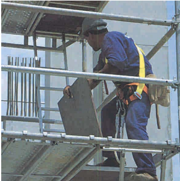
Figura 4-17: Sólo se deben usar andamios de estructura, barandas y tabloncillos metálicos que entregan una mayor seguridad para trabajos en altura.
