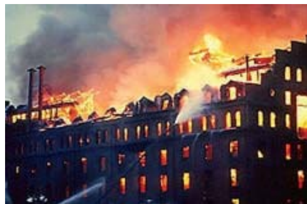
Figura 15–10: El no cumplimiento de las disposiciones mínimas en lo que a protección pasiva se refiere, provocará que la estructura de un edificio presente escasa resistencia al avance de las llamas y propagación de gases, siendo altamente probable la muerte de personas.
