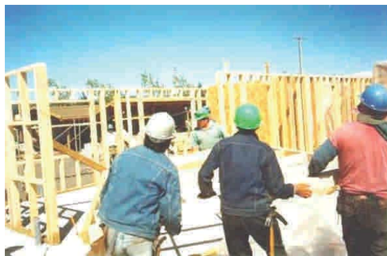
Figura 10 - 73b: Traslado manual del elemento prefabricado en obra, de dimensiones 3,20 m de ancho por 2,40 m de alto.
