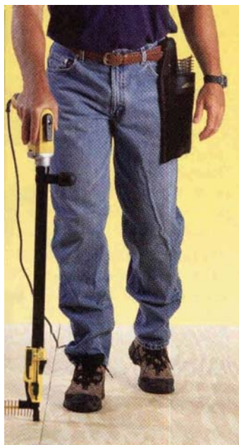
Figura 9 - 12: Taladro con extensión para atornillar tableros que arriostran la plataforma de un entramado de piso, a distanciamiento correspondiente.
