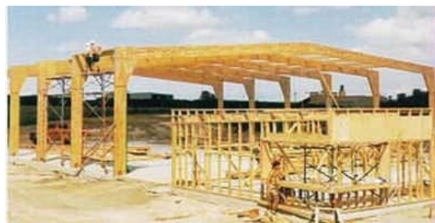
Figura 1 - 95: Aplicación de la madera laminada en estructuras de grandes luces, construcción industrial.
