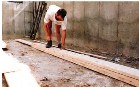
Figura 9 – 54: Presentación de las piezas de Pino radiata de grado estructural, en este caso de escuadrías de 2"x8" que conformarán la viga maestra o principal.
