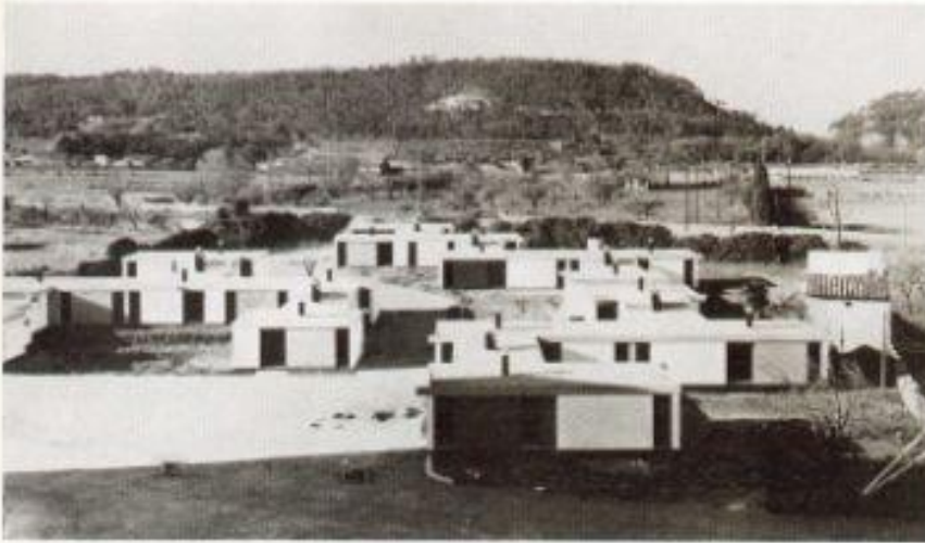
230/231 Bagnols sur Cèze, Coronelles/Francia - 1959 → 50, 134/135 Casas en hilera durante la construcción
