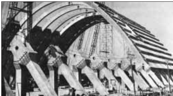
Almacén típico de azúcar a granel en construcción
