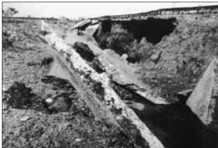
La Carretera Central, en la de la derecha se ve la placa de hormigón de 30 centímetros totalmente destruida
