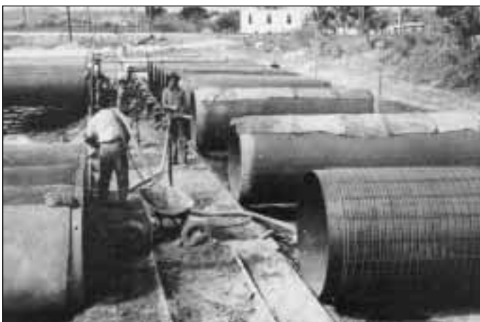
Producción de tubos Centro Acero en el Naranjito
