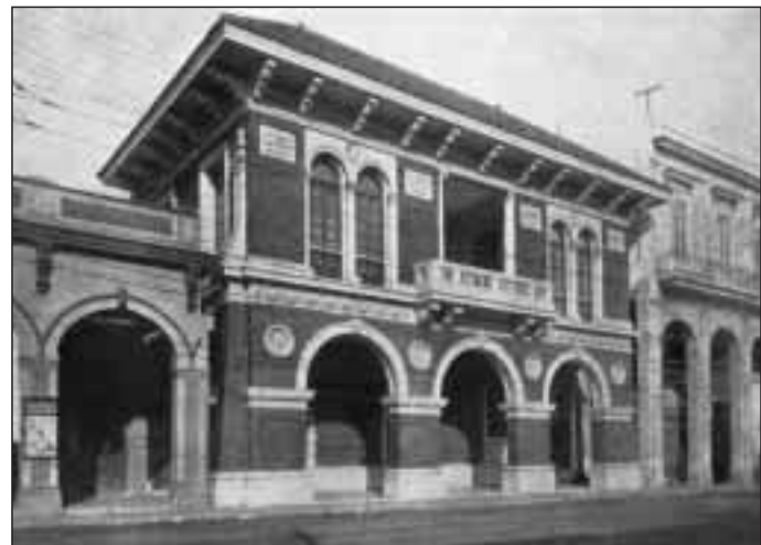
Edificio de la Sociedad Cubana de Ingenieros, en la calle Montserrate, frente al edificio Bacardí
