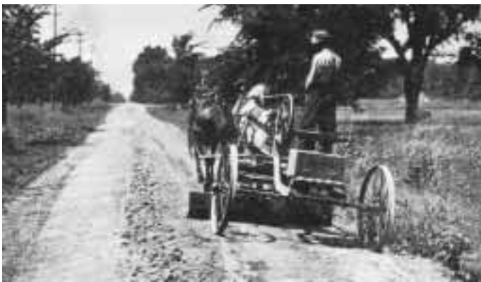
Niveladora tirada por caballos, usadas en la construcción de la Carretera Central
