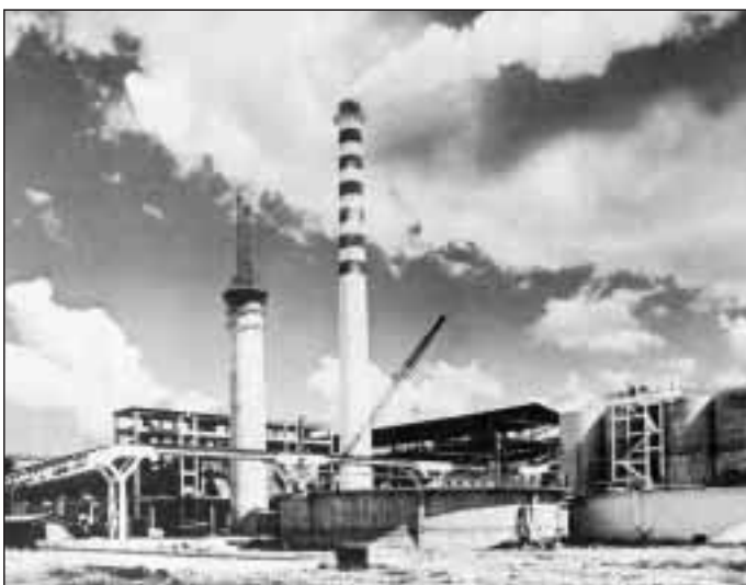
Construcción de la segunda chimenea de la fábrica de cemento Siguaney
