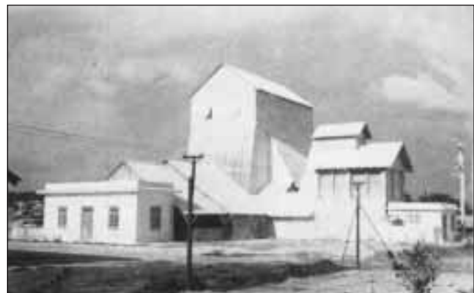
Foto de la cantera Novo, situada donde después se construyó la calera "Mártires del Corinthia" en la Avenida 100 y línea del ferrocarril
