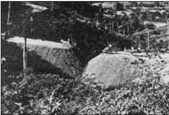
Construcción de la carretera de Pinar a Luis Lazo en 1907, donde se realizaba el movimiento de tierra con carretones de caballos
