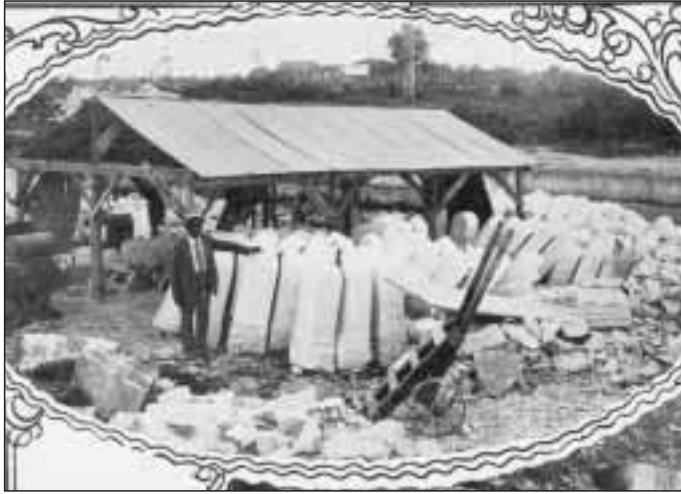
Taller donde se fabricaron los mojones que se situaron en la Carretera Central para marcar los kilómetros
