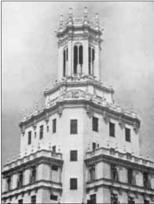
Torre del edificio de la Empresa de Teléfonos
