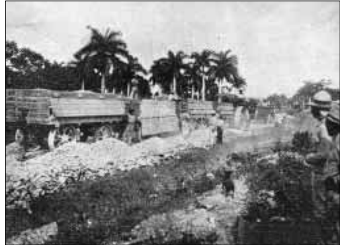
Equipo llamado "Troy" por los norteamericanos, usado para el transporte de áridos, en la construcción de la carretera de Pinar a Luis Lazo, en el año 1907
