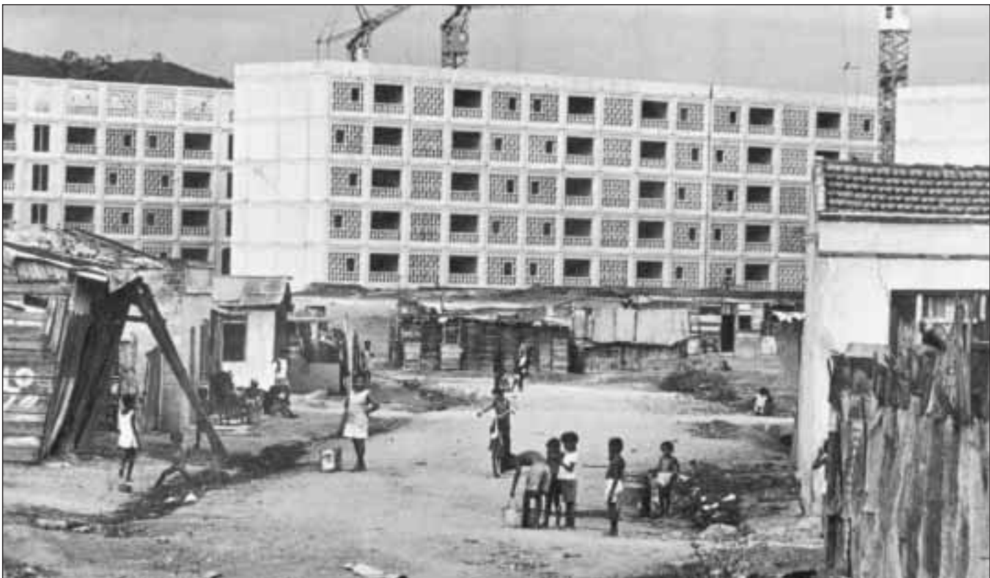
Construcción de viviendas prefabricadas soviéticas. En primer plano, las viviendas marginales que reemplazaron
