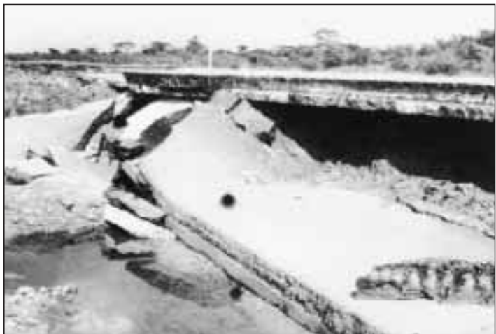
La Carretera Central, en la de la derecha se ve la placa de hormigón de 30 centímetros totalmente destruida
