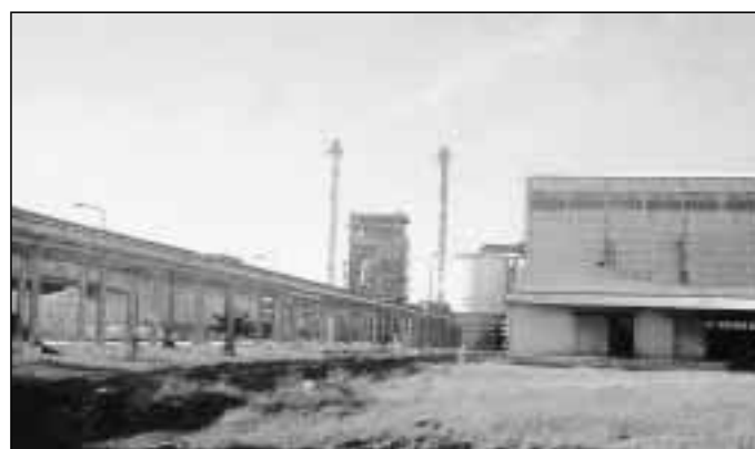
Construcción de la planta "Papel Blanco Uruguay"
