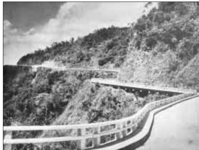
Vista del trazado de la carretera en la zona llamada de La Farola y del Viaducto que se construyó para salvar su abrupta geografía
