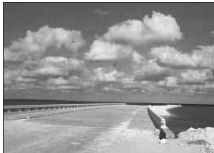
Vista de uno de los puentes del pedraplén Caibarién-Santa María
