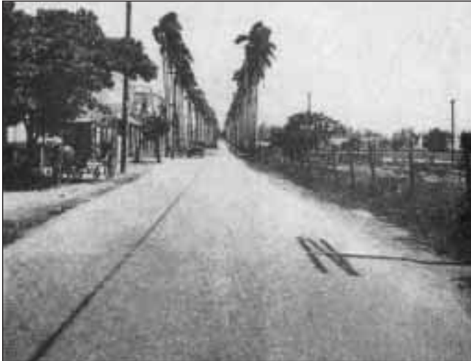
Tramo de Palatino a Vento, pavimentado con roca asfáltica
