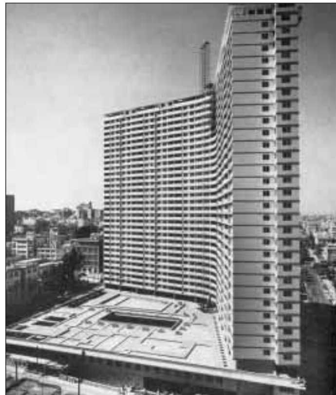
El FOCSA un mes antes de su terminación
