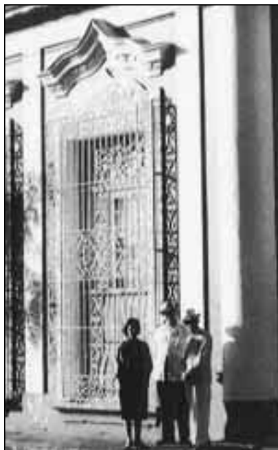
Reja en casa de la calle Céspedes
