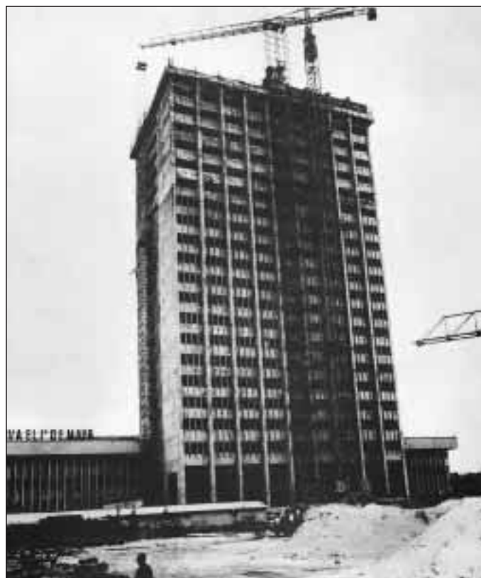
Hospital Ameijeiras en construcción
