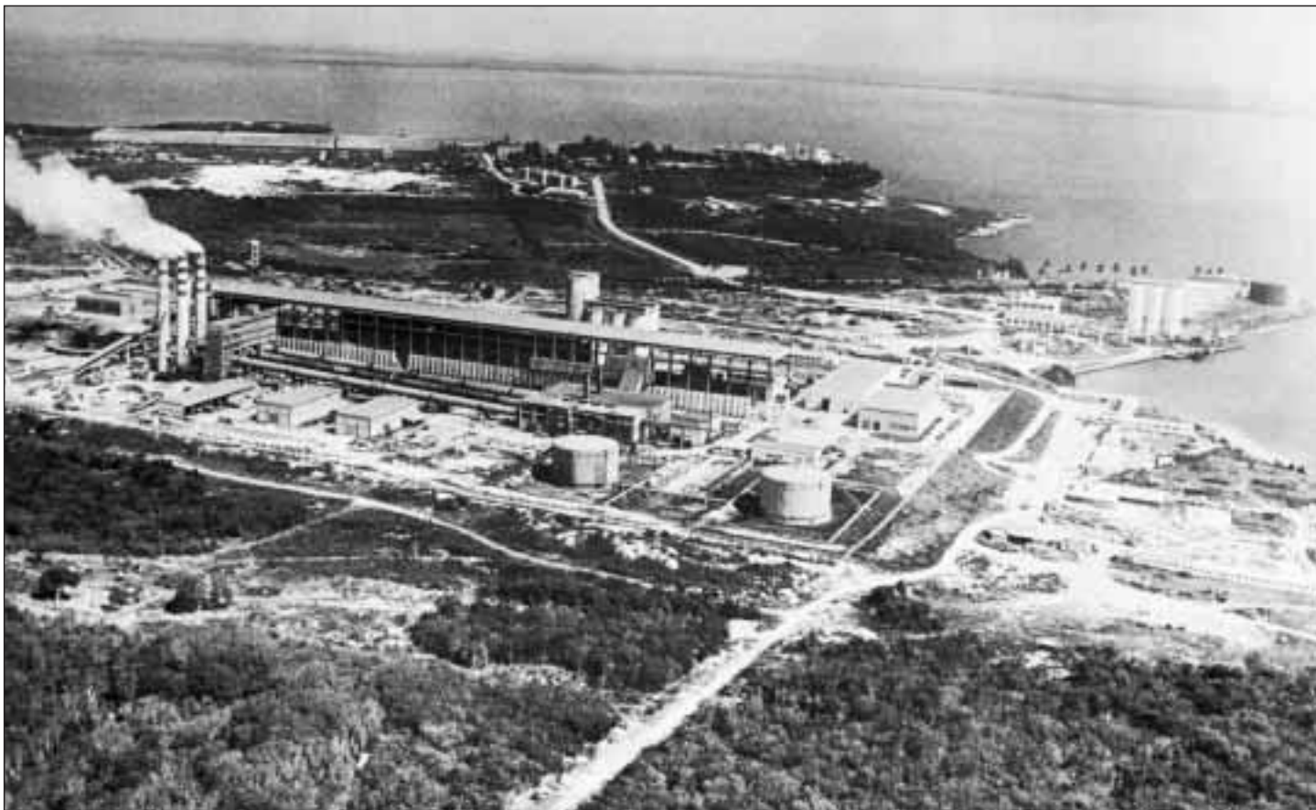
Vista de la fábrica de cemento en Nuevitas, a la derecha de los silos y el atraque de la fábrica
