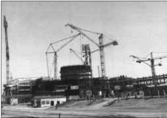
Construcción de la Central Electronuclear
