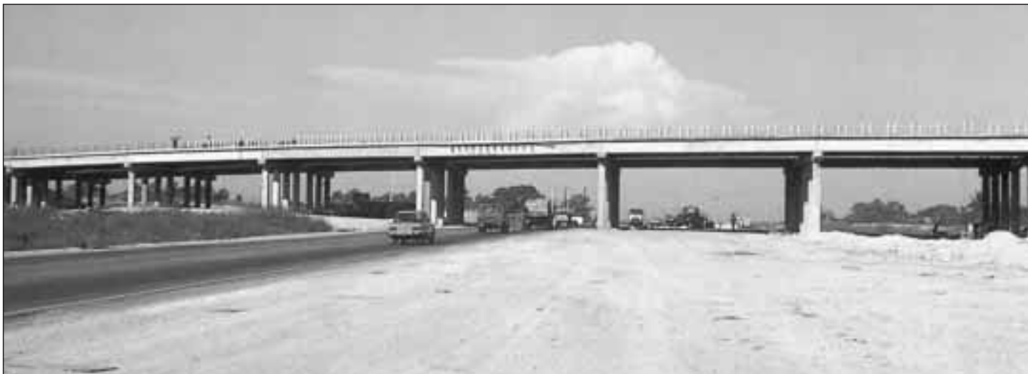
Construcción de la autopista "Este-Oeste"
