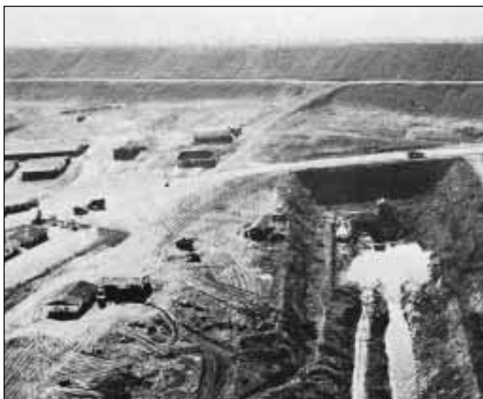
Vista de la construcción de la presa Paso Malo en Granma
