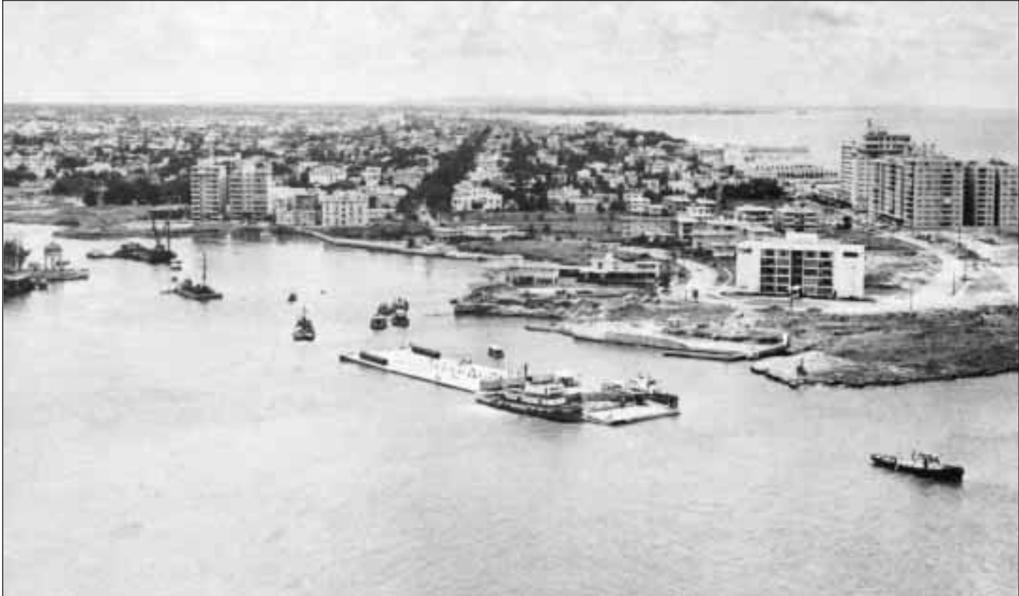
Foto tomada desde un helicóptero donde se ve el traslado flotando del túnel que se instaló para sustituir el Puente de Pote. A la izquierda, la glorieta de la esquina del restaurante "1830"; a la derecha, los edificios "Rosita de Hornedo" y "Río Mar".
