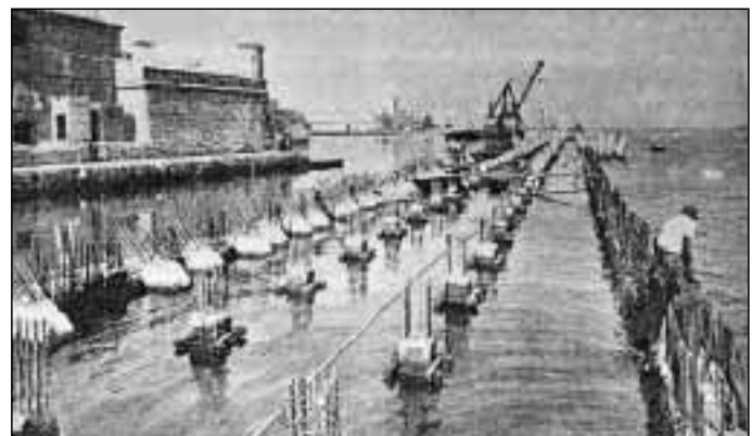
Construcción del Malecón entre el Castillo de la Punta y los muelles. Obsérvese que el mar llegaba hasta los muros del Castillo de la Fuerza
