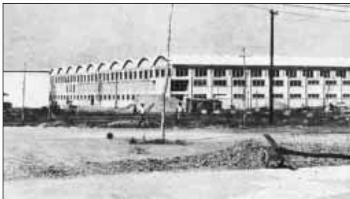
El INPUD cuando se encontraba en proceso de construcción
