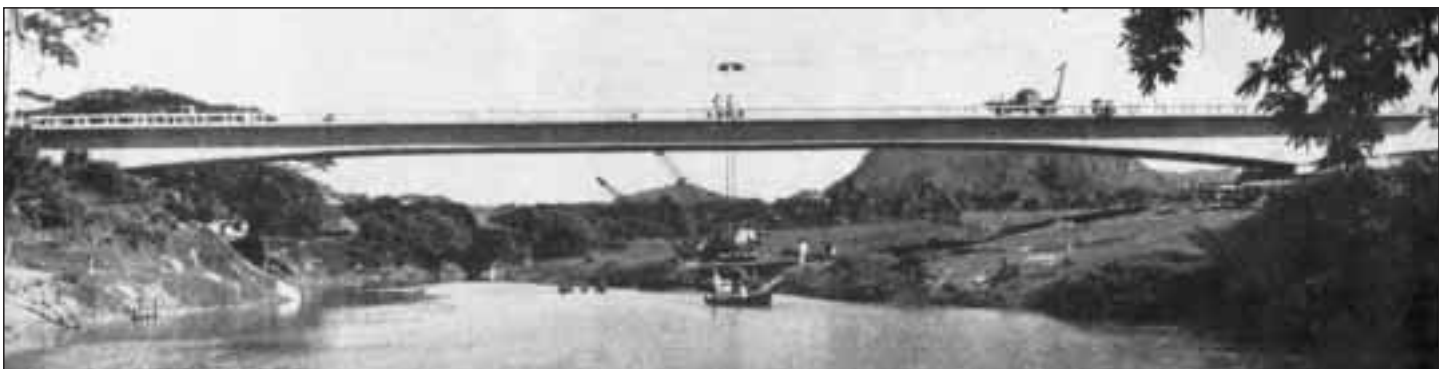
Foto tomada cuando se estaba terminando el puente sobre el río Cuyaguaje
