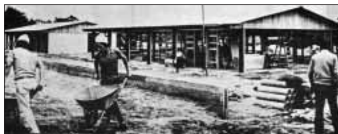
Trabajadores internacionalistas cubanos construyendo el hospital de Carhuaz en Perú
