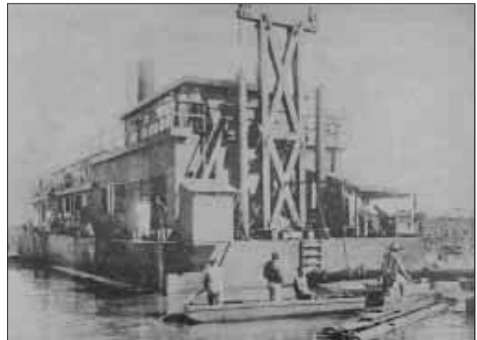
Draga número 1, trabajando en el Canal de Roque
