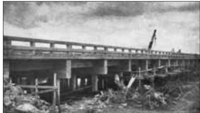
Puente prefabricado sobre el río Guanabo
