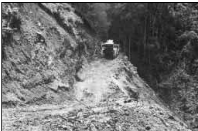
Impresionante foto de un buldózer realizando el corte de una montaña en la carretera Mayarí-Sagua-Moa
