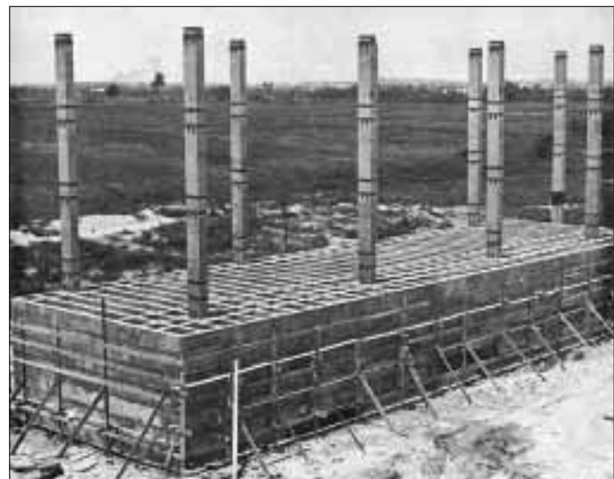
Elementos del sistema "Lift Slab" fundidos antes de ser elevados con gatos en la construcción de la Ciudad Universitaria José Antonio Echeverría (CUJAE)
