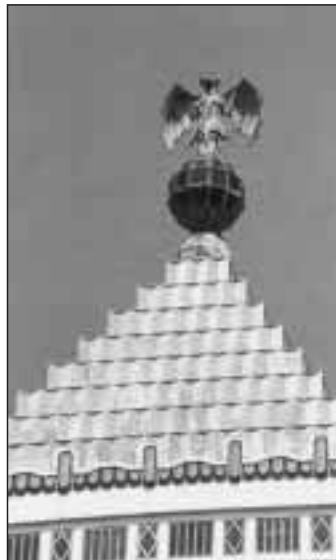
Detalle de la cúpula
