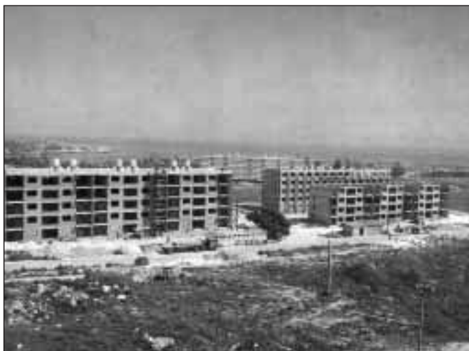
Foto tomada en 1972 cuando se comenzaba la construcción por las microbrigadas en Alamar
