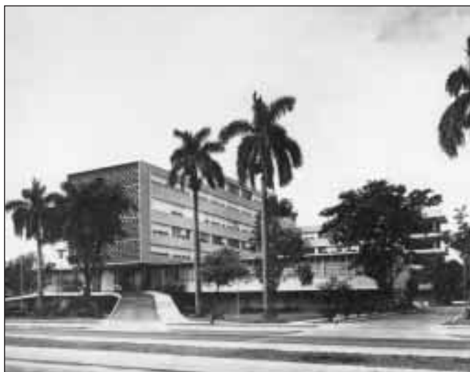
Hospital Clínico Quirúrgico en Avenida 26 esquina a Avenida de Rancho Boyeros
