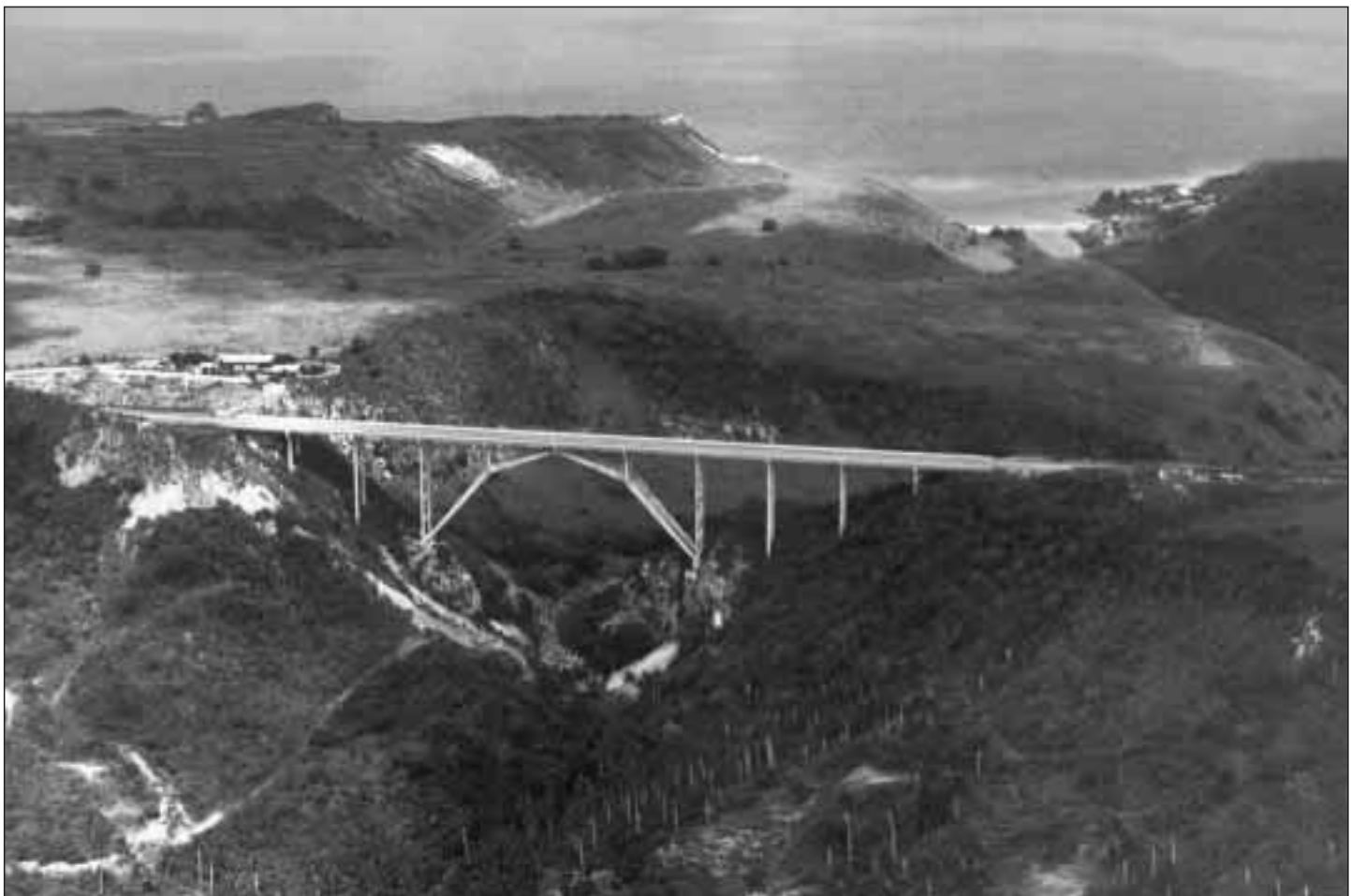
Foto aérea del puente Bacunayagua
