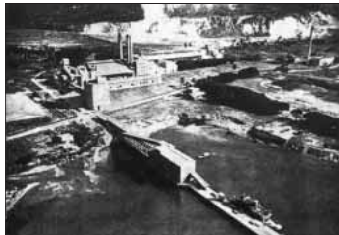
Vista aérea de la fábrica del Mariel, tomada en 1956
