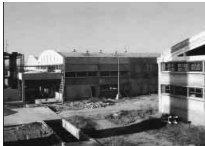
Frigorífico en construcción
