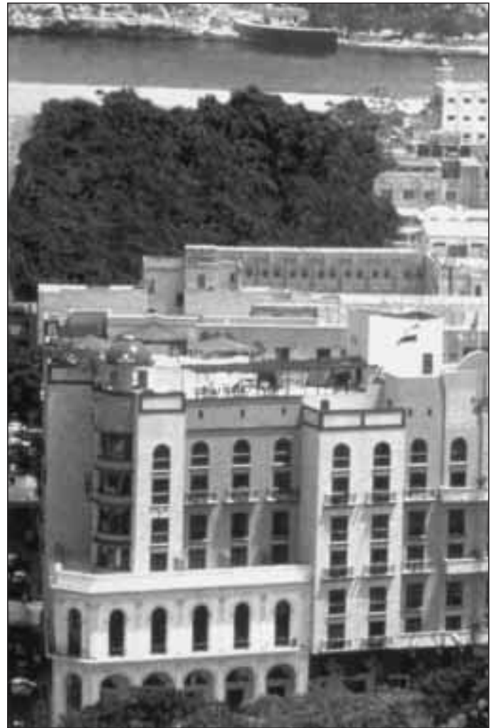
Vista del Hotel Parque Central, nótese la parte del antiguo edificio conservado en su fachada
