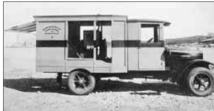
Camión laboratorio dotado de una perforadora para tomar muestras de los hormigones
