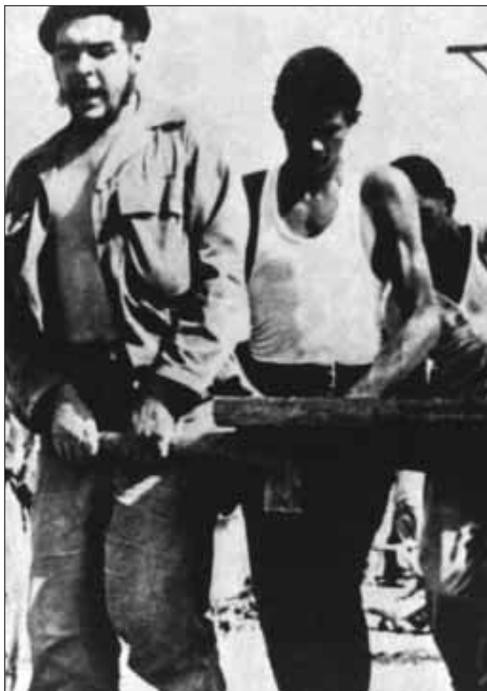
El "Che" realizando trabajo voluntario en la construcción
