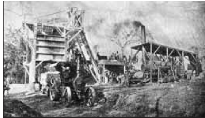
Molino accionado por vapor instalado por el gobierno interventor de Magoon para construir la carretera de Pinar a Luis Lazo. Nótese que el tractor bajo las tolvas también era accionado por vapor
