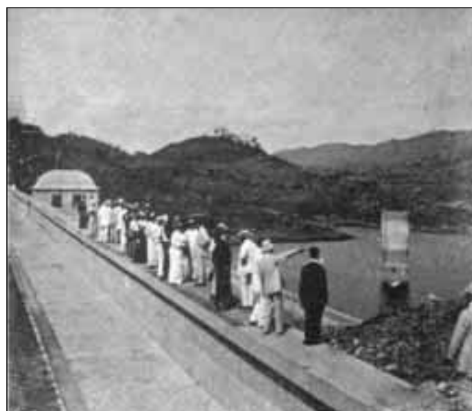
Presa sobre el río Purgatorio
