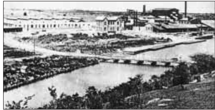
Vista de la fábrica de cemento "El Almendares", tomada desde la orilla del Vedado. Se ve sobre el río el llamado "Paso de la Madama", antes de que se construyera el puente "Asbert"
