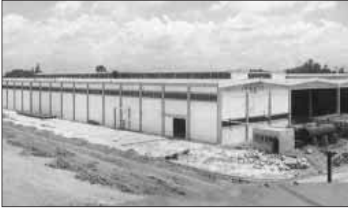
Planta de elementos aligerados de Bayamo en construcción
