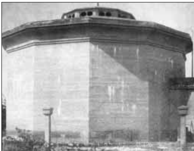
Tanque del acueducto de Guanabacoa
