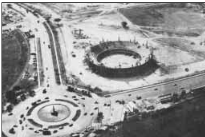
Vista aérea de la construcción de la Ciudad Deportiva en 1956. En primer plano, la fuente luminosa en la rotonda
