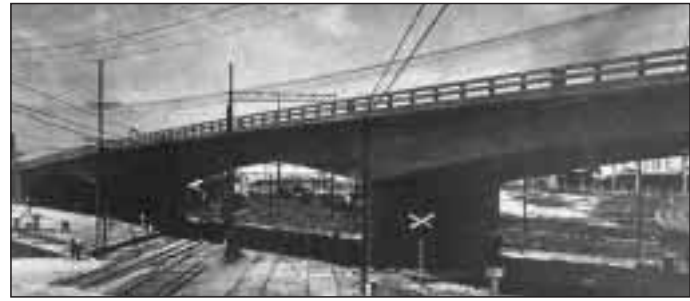
Paso Superior sobre la Vía Blanca
