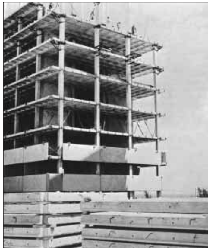
Edificio IMS en construcción
