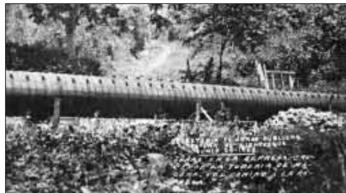
Acueducto de madera ensayado en Cienfuegos en los años veinte
