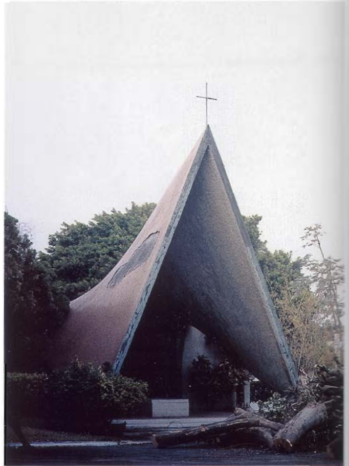
Paraboloide hiperbòlic gaudinià al panteó Núñez-Gálvez, obra dels germans Max i Enrique Borges, al cementiri de Colón (1956)
