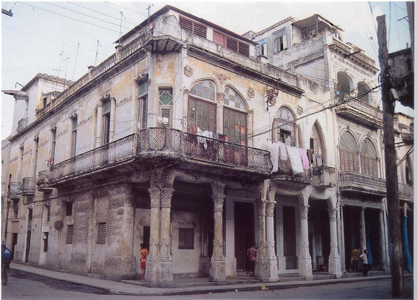
A la cantonada del conjunt del carrer Càrdenas, de Mario Rotllant, hi llueïa un balcó amb cupulí de trencadís que va ser característic d'aquest constructor En la esquina del conjunto de la calle Càrdenas, de Mario Rotllant, lucía un balcón con cupulín de trencadís que fue característico de este constructor
