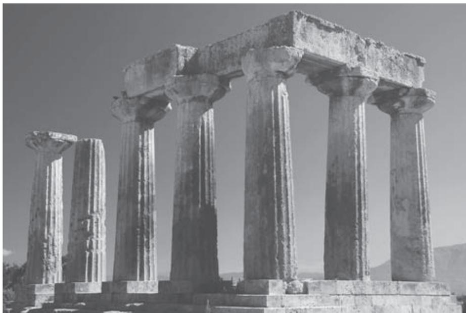
Figura 36. *Templo de Apolo, en Corinto. Columnas de fuste monolítico, con veinte estrías, y equino muy abierto, según el módulo dórico arcaico.*
