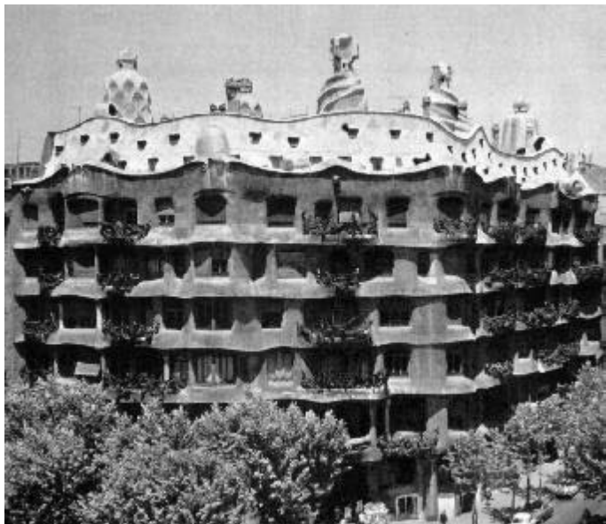
Antoni Gaudí: Casa Milà («La Pedrera») —Barcelona, 1905-1910
