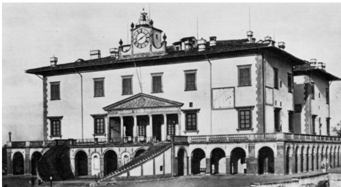
Giuliano da Sangallo: Villa Medicea de Poggio , en Caiano
