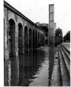
E.83. Freixes y Miranda, parque del Clot, Barcelona, 1986: planta general y vista de la arcada-acueducto.
