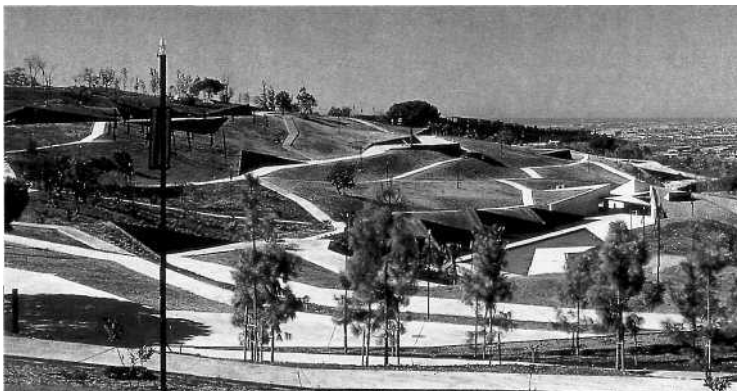
E.84. Ferrater, Canosa y Figueras, Jardín Botánico de Barcelona, 1999: planimetría y vista general.
