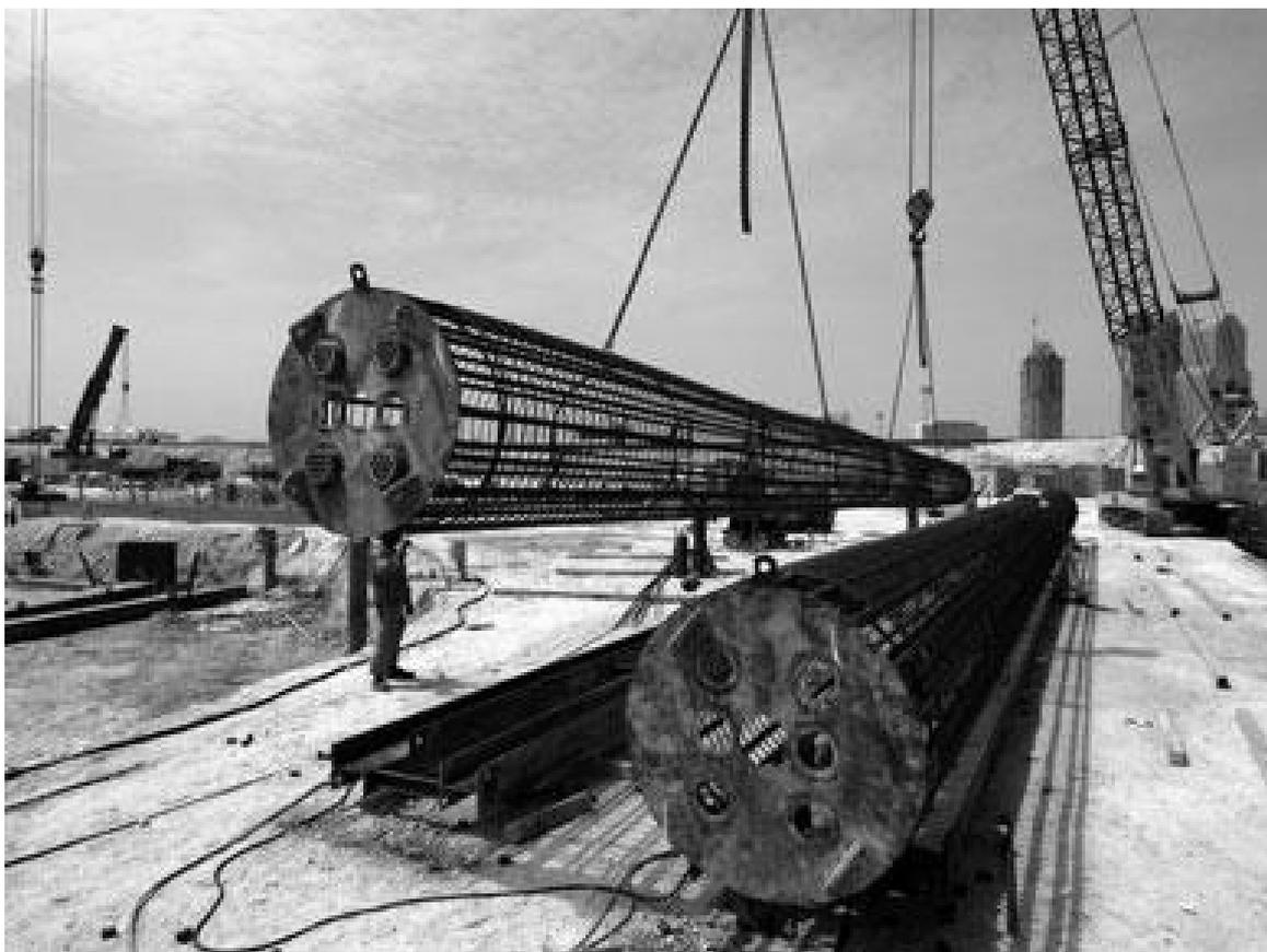
Figura 495: Armaduras de los pilotes ejecutados como parte de la fundaci3n del Burj Khalifa (ref. 120)
