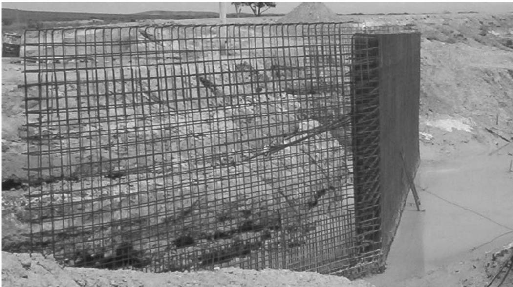
Figura 587: Armado de un muro de contención tipo ménsula
