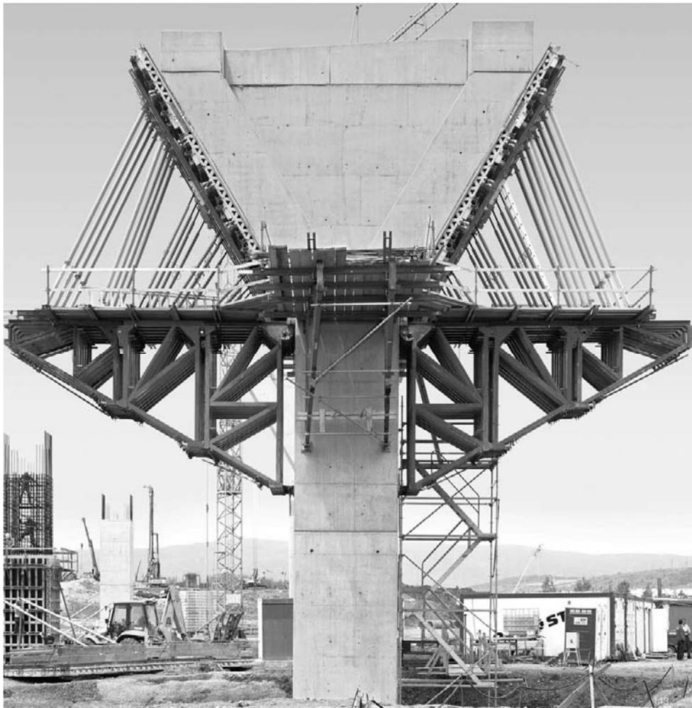
Figura 535: Sistema de escuadras PERI para el encofrado de la pila del puente de la autopista Trmice , Aussig, Rep. Checa (referencia 103)
