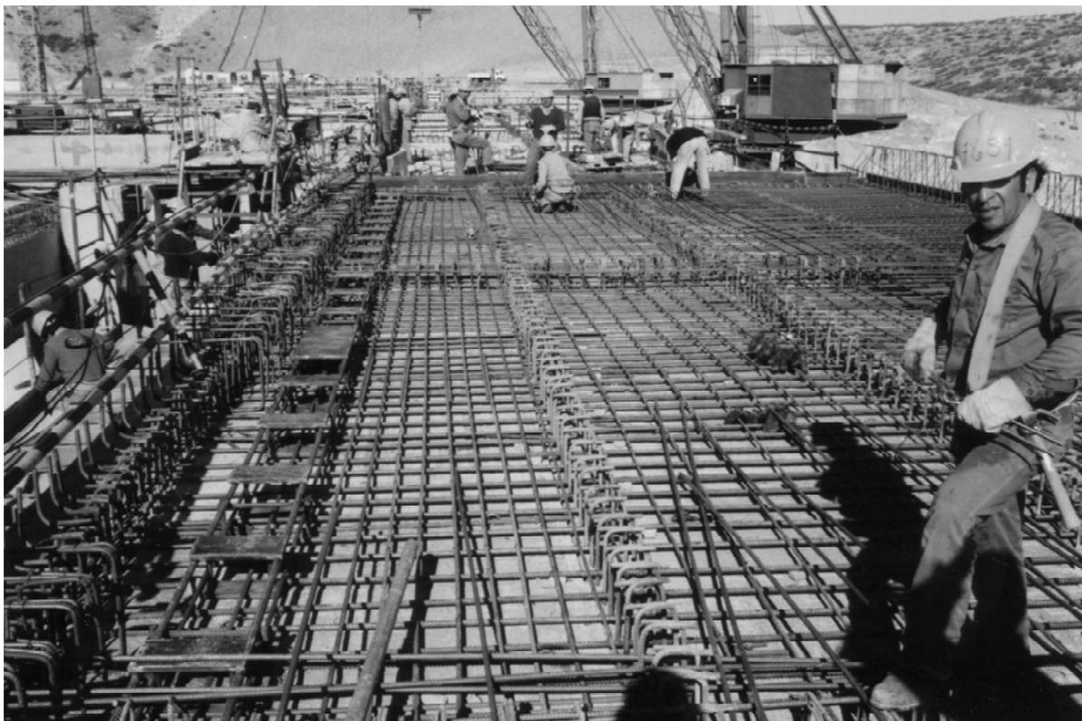
Figura 280: Proceso de armado de una losa de puente sobre vertedero de una presa, la que conforma con las vigas premoldeadas de la Figura 281, un puente viga. Se aprecian los conectores de viga incorporados a la losa. Se utilizan losetas premoldeadas como encofrado perdido.
