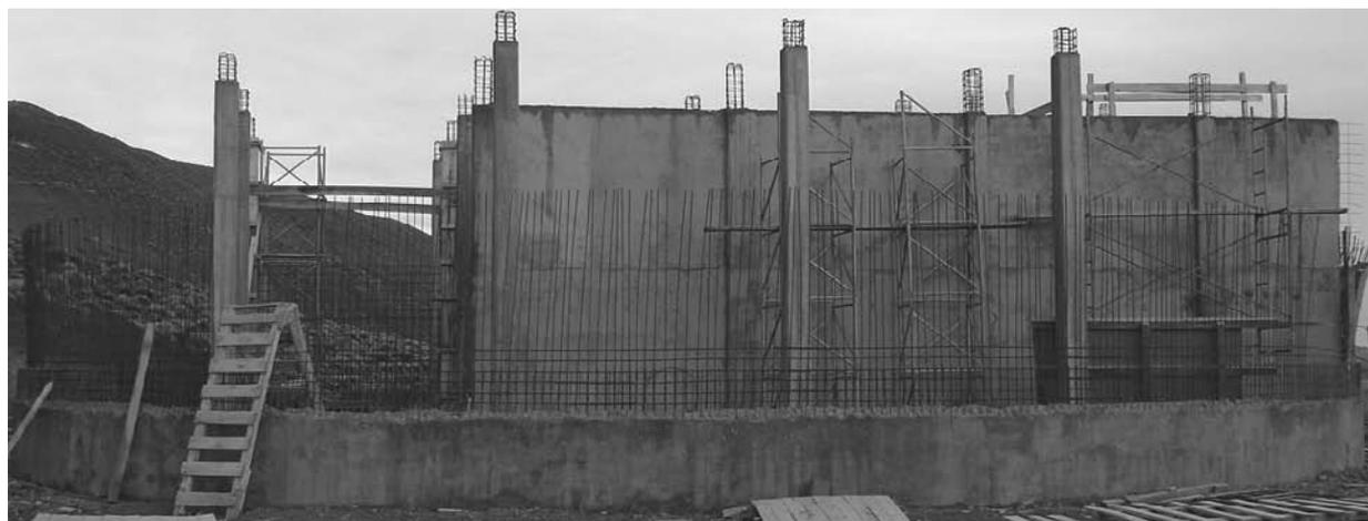
Figura 505: Armadura de espera para paredes laterales, columnas y tabiques aquietadores
