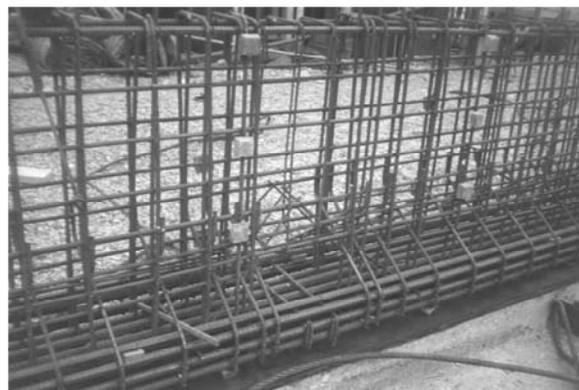
Figura 176: Armadura de piel en una viga premoldeada de puente fuera de ruta
