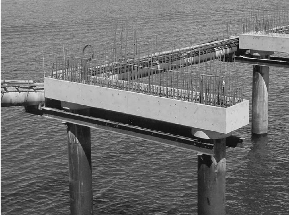
Figura 445: Cabezal premoldeado de dos pilotes aún sin hormigonado in situ
