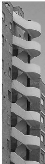
Figura 137: Escalera apoyada en un columna central de un edificio de altura.
