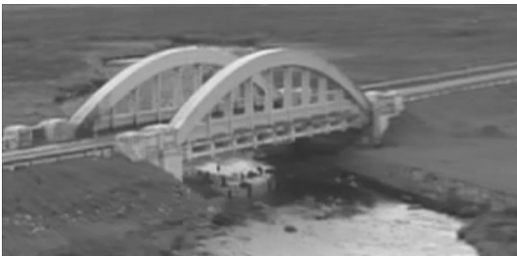
Figura 150: Puente arco con tirantes de hormigón armado
