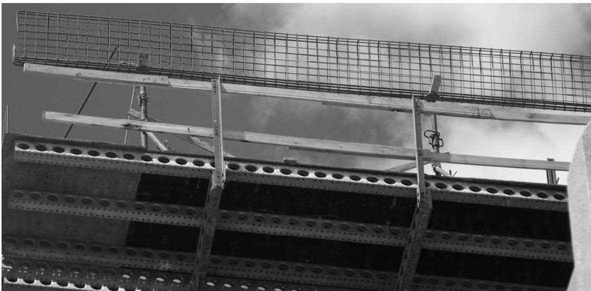
Figura 309: Proceso de armado de una viga balcón
