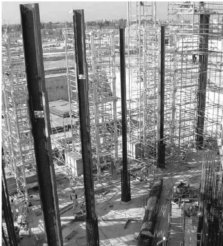
Figura 376: Montaje del núcleo de acero de columnas compuestas
