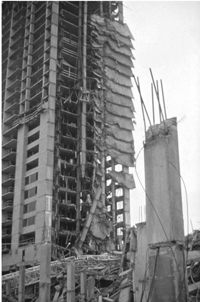
Figura 9: Colapso progresivo vertical y horizontal del Skyline Plaza Apartments en EE.UU.
