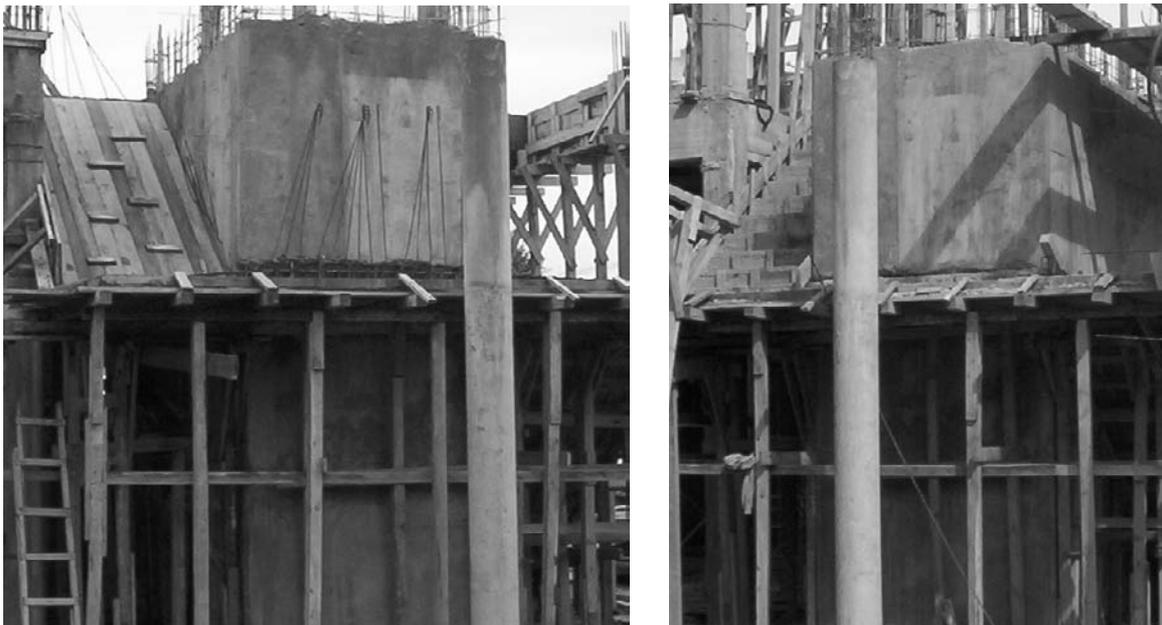
Figura 130: Montaje del encofrado, vista de la armadura de vinculaci3n al tabique (izq.) y losa hormigonada para una escalera en voladizo
