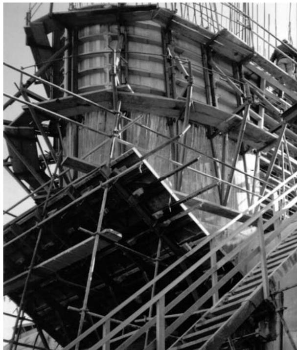
Figura 527: Encofrado trepante para el hormigonado de la “nariz” de la pila de una presa
