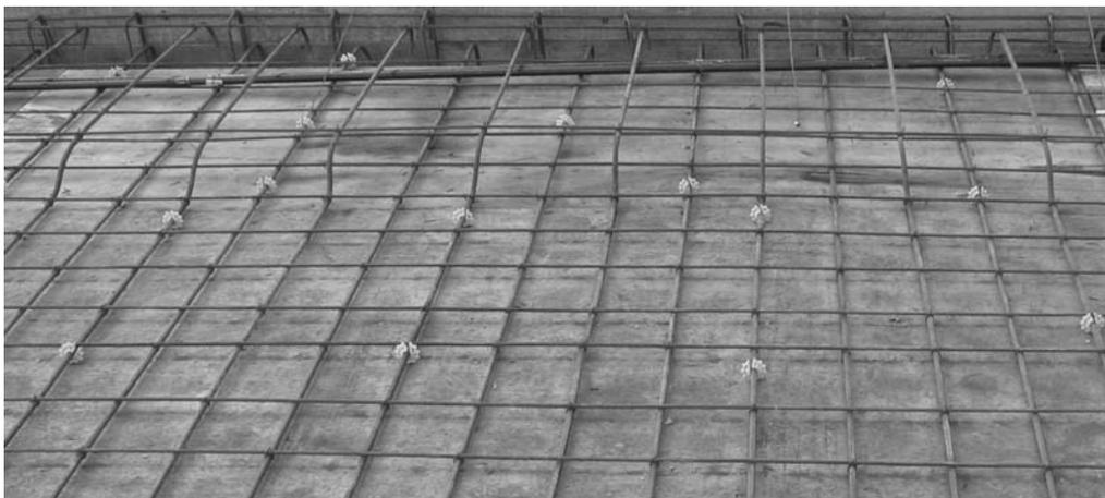
Figura 123: Disposición de barras dobladas en un apoyo simple de una losa
