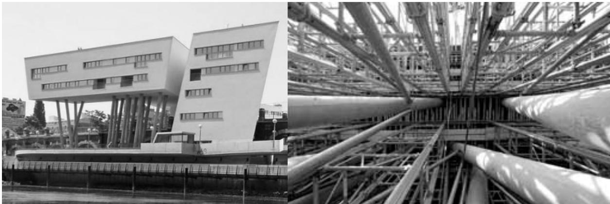
Figura 393: Edificación sobre arcadas del tren en Viena, Austria con columnas inclinadas de hasta 11 m de altura encofradas con sistemas PERI (referencia 103)
