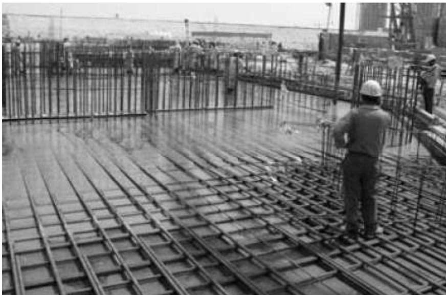
Figura 485: Hormigonado de un sector de la platea de fundación del Burj Khalifa (Burj Dubai) (ref. 120)
