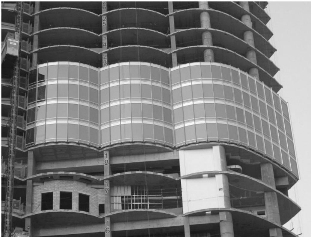
Figura 439: Sistema de placas planas en el Burj Khalifa (referencia 120)
