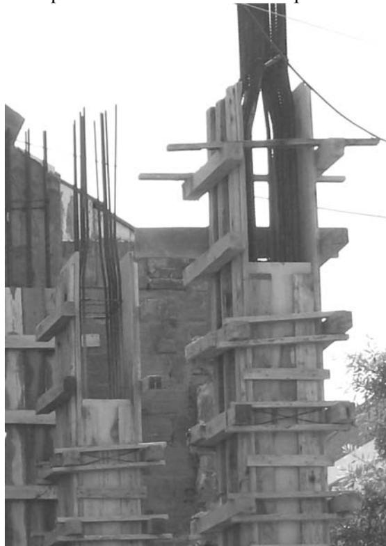
Figura 385: Encofrado y armaduras de empalme en columnas rectangulares de planta baja
