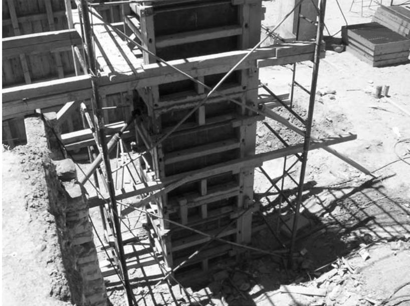
Es necesario efectuar un pequeño dado de hormigón sobre el tronco de la base para la fácil y correcta colocación de los tableros. Generalmente, se ejecuta de una altura no superior a los 10 cm y se lo ubica cuidadosamente según los ejes de la columna.
