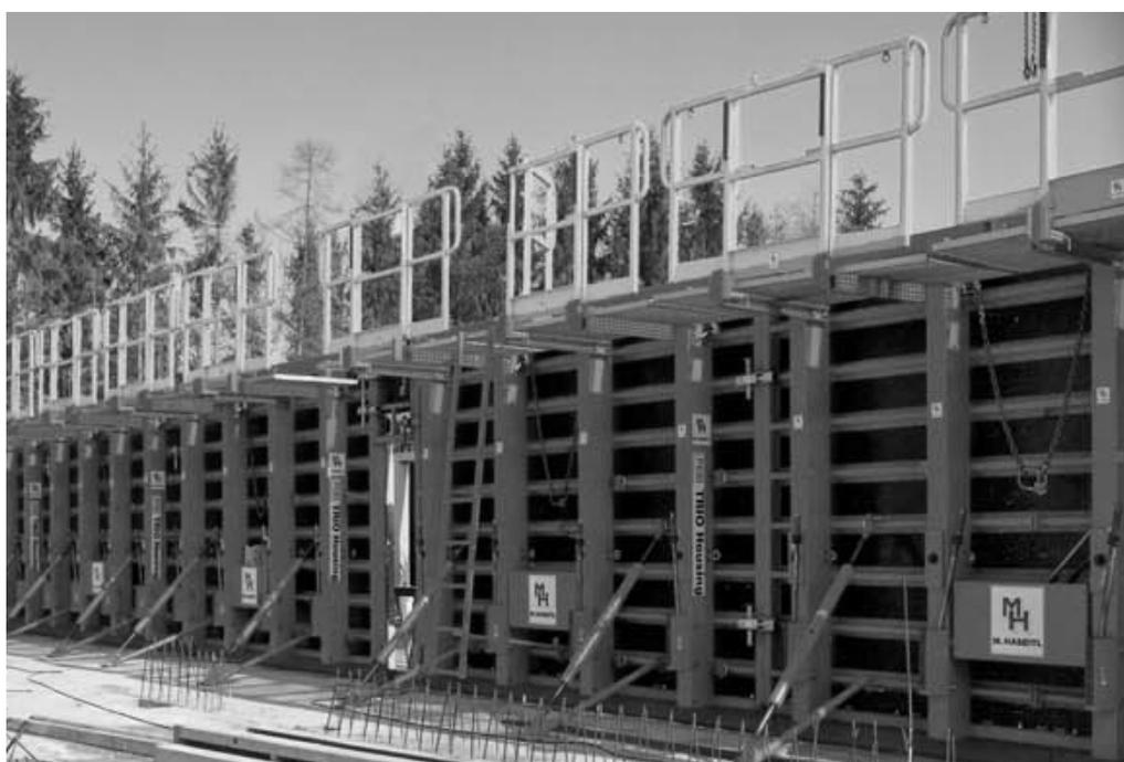
Figura 532: Encofrado para muros con plataforma de trabajo, escalera y escuadras metálicas PERI (ref. 103)
