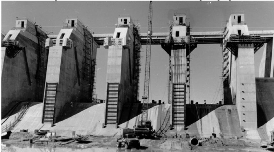
Figura 2: Hormigón estructural. Vertedero Presa Hidroeléctrica de Pichi Picún Leufú – Etapa constructiva.
