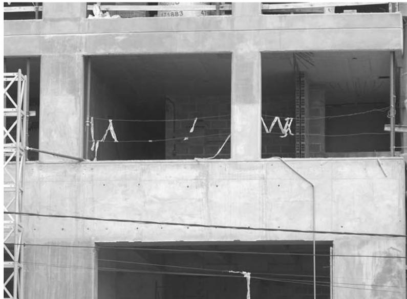
Figura 209: Caso de apeo de una columna sobre una viga en planta baja en un edificio de 10 niveles
