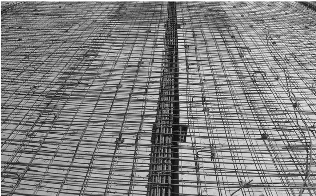
Figura 510: Armaduras de losas y vigas de la losa de cubierta de la Figura 511
