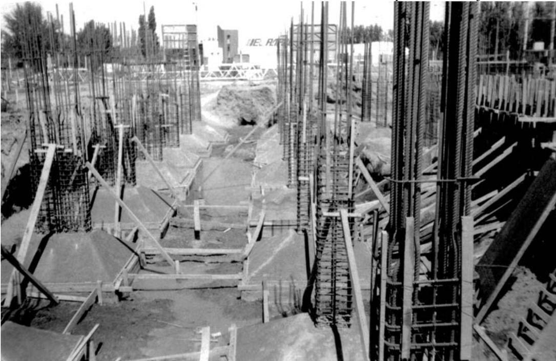
Figura 442: Sistema de bases centradas
