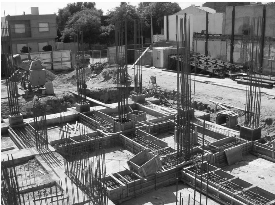
Figura 444: Platea de fundación con vigas superiores
