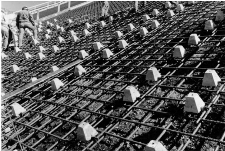
Figura 529: Separadores de hormigón en una losa de impermeabilización de la cara de una presa
