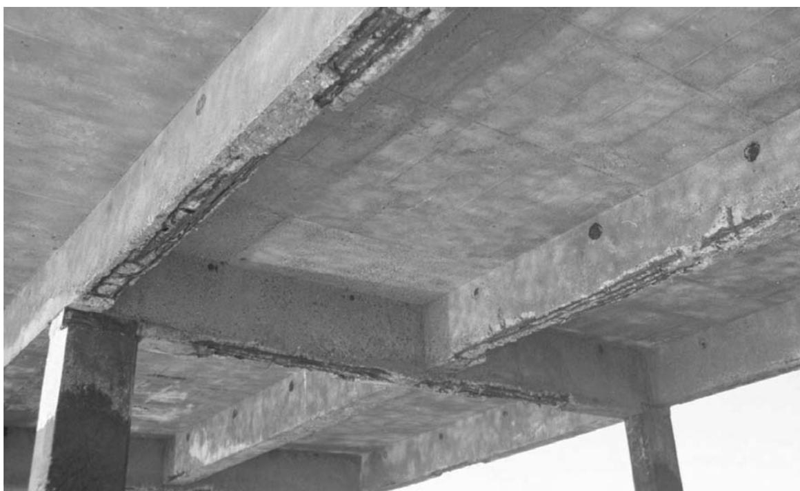
Figura 152: Deterioro en vigas por acción corrosiva sobre las armaduras en un ambiente marino
