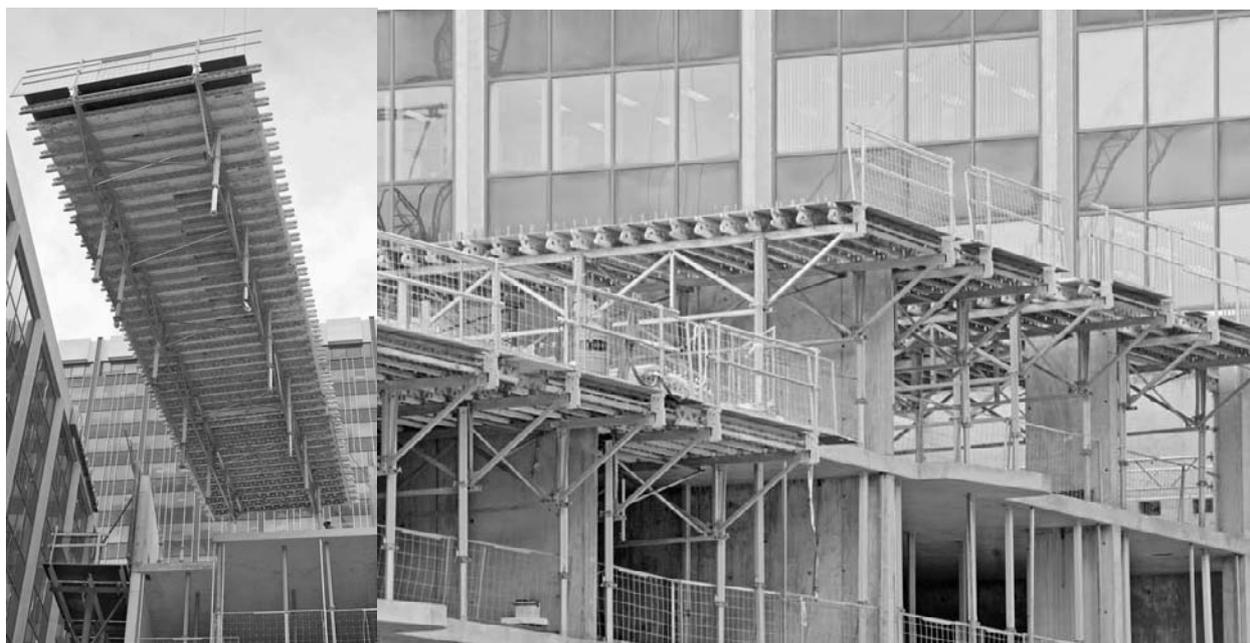
Figura 538: Mesas para encofrado de losas (referencia 103)
