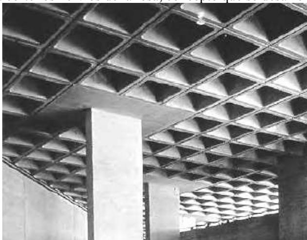
Figura 143: Aspecto de una losa nervurada en un entrepiso sin vigas
