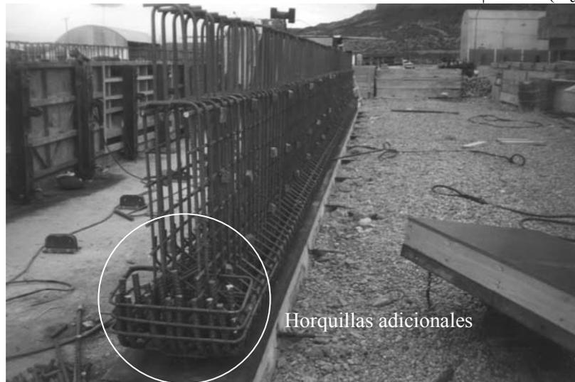
Figura 259: Colocación de horquillas adicionales para confinar el hormigón en el anclaje
