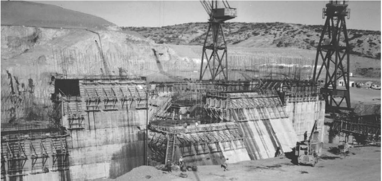
Figura 35: Muro divisorio canal de descarga vertedero presa Pichi Picún Leufú – Ejemplo de una estructura de hormigón masivo
