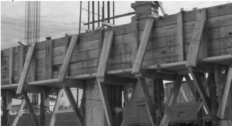
Al respecto, es importante mencionar la importancia del apuntalamiento como elemento rigidizador de los encofrados, de sostén del hormigón y de los operarios.
