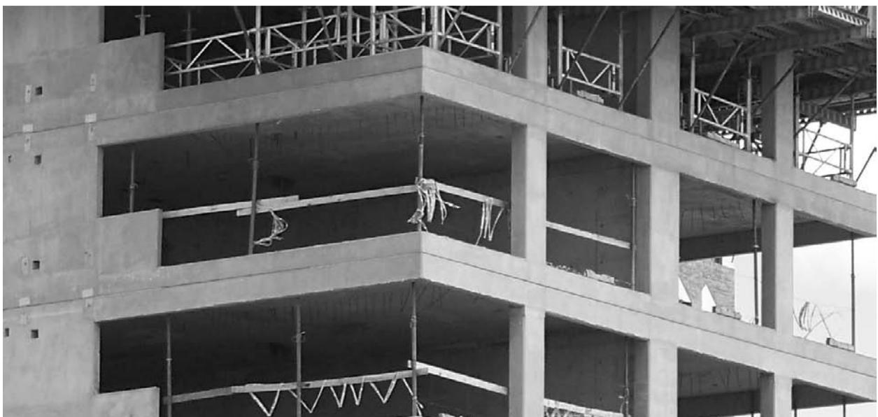
Figura 307: Ejemplo de una viga balcón sometida a esfuerzos de torsión
