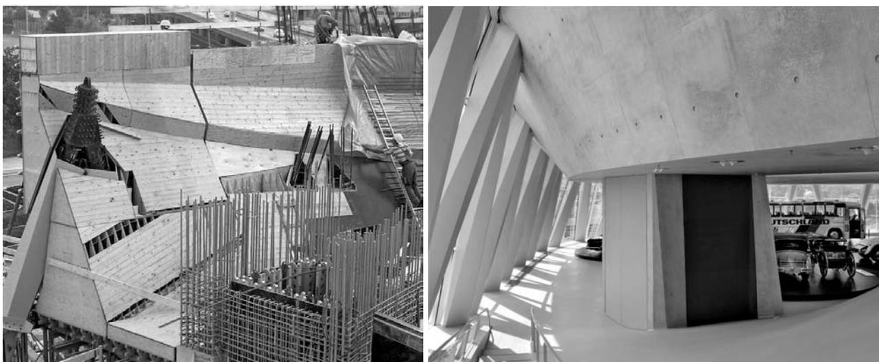
Figura 543: Encofrados especiales PERI en la construcción del museo Mercedes Benz en Stuttgart (ref. 103)
