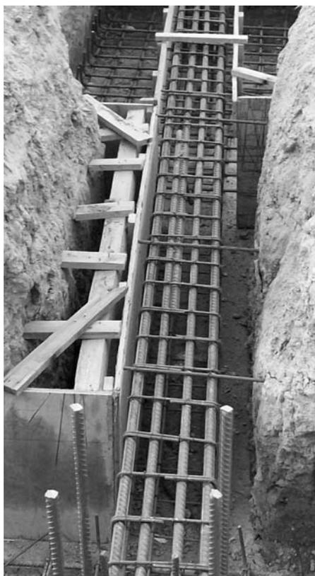
Figura 356: Empalme de armaduras en una viga portamuros
