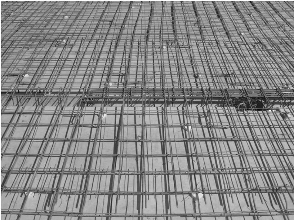
Figura 124: Armaduras superiores e inferiores de un apoyo de losas de cubierta en una dirección
