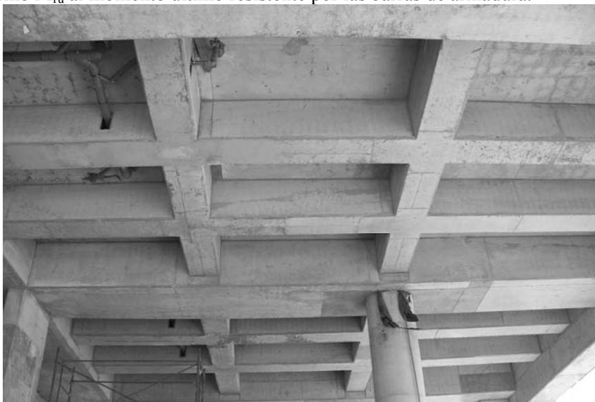
Figura 425: Entramado de vigas principales y secundarias sobre columnas circulares de planta baja
