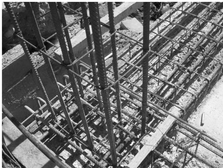
Figura 382: Primer plano de las armaduras longitudinales y transversales de una columna de planta baja de un edificio de 10 niveles con 8φ25 mm
