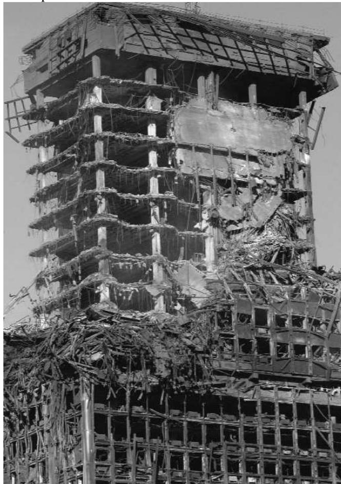
Figura 546: Acción del fuego sobre una estructura de hormigón armado
