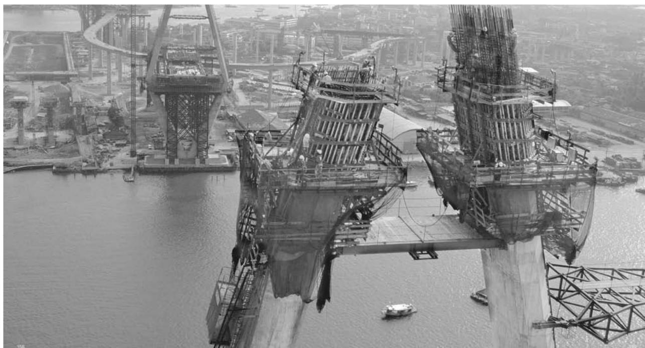
Figura 541: Construcción de pilas del puente Ring Road de Bangkok con una altura de 173 m (ref. 103)
