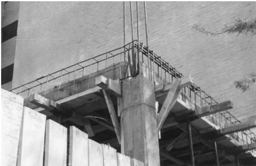
El encofrado de losas se apoya generalmente sobre tirantes de 3" x 3", denominados soleras, separadas cada 0,60 m y apoyadas en los extremos sobre los tableros de las vigas, las cuales se apuntalan en toda su longitud sobre tirantes de 3" x 3" o puntales telescópicos metálicos distanciados cada 0,80 m como máximo. El clavado de los encofrados de madera se realiza con clavos de Punta París de 21/2" para los clavados principales y de 2" para los secundarios.
