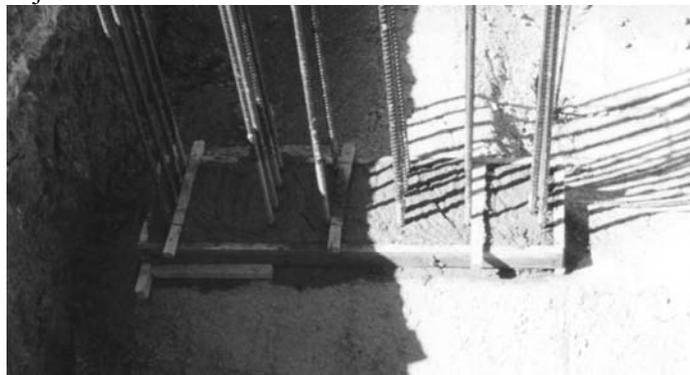
2) Fijaciones: pueden ser mediante marcos simples o dobles, contruidos de madera o bien por grampas metálicas (imagen anterior).
