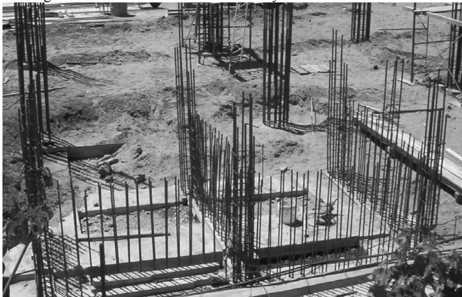
Figura 416: Armado de tabique núcleo de ascensor y escalera (se observa el ensanchamiento del mismo en los bordes para alojar la armadura)
