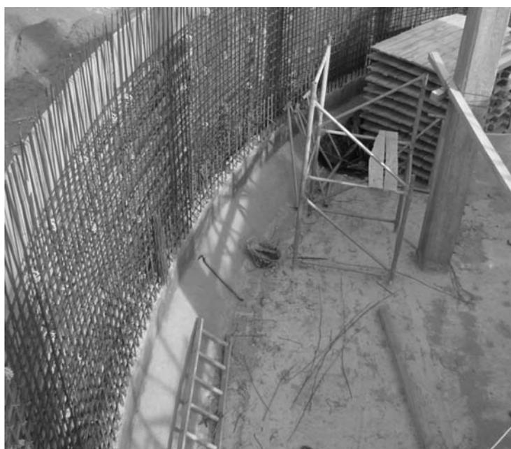
Figura 506: Armaduras de paredes laterales y cartela inferior
