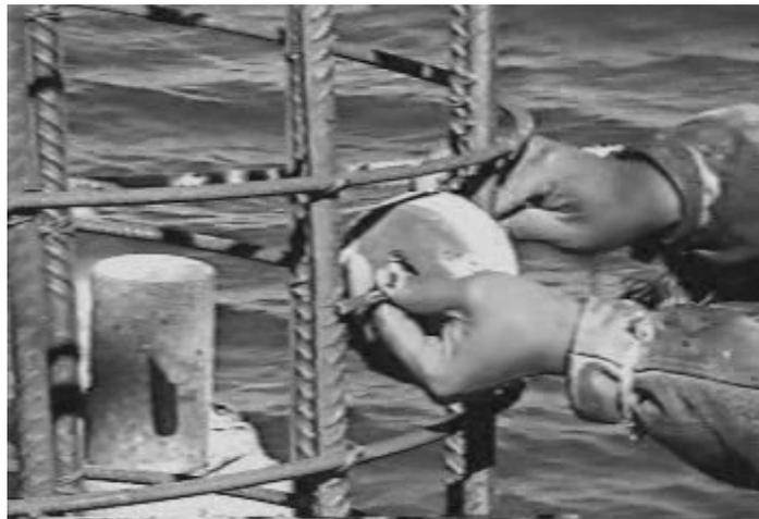
Figura 530: Colocación de separadores en armadura longitudinal de pilotes de hormigón armado
