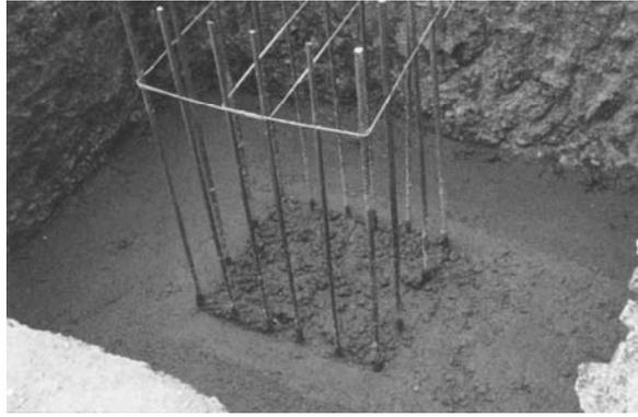
Figura 465: Barras de espera en una base aislada
