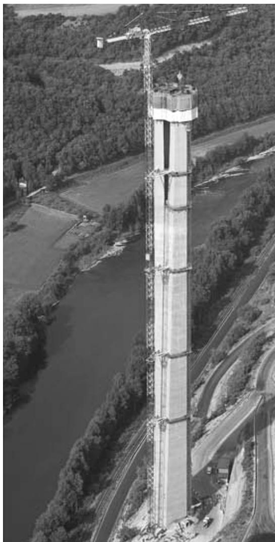
Figura 540: Aplicación del sistema de encofrados trepante PERI a la construcción de las pilas del Viaducto de Millau en Francia con una altura de hasta 245 m (referencia 103)
