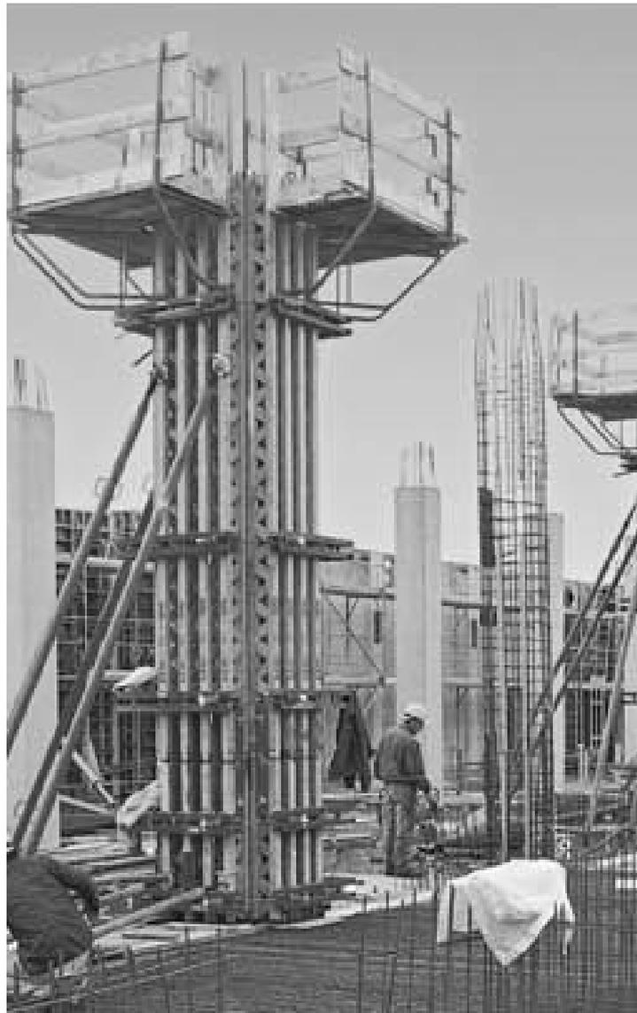
Figura 537: Aplicación de encofrados industriales PERI a una columna de 5,7 m de altura en un edificio de oficinas (referencia 103)
