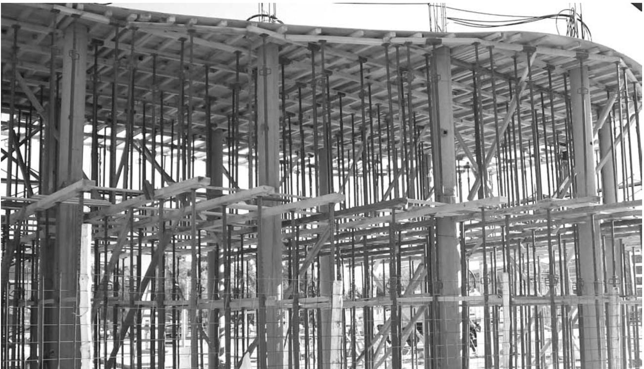
Figura 408: Columnas circulares de 6 m de altura para una estructura de hormigón armado.
