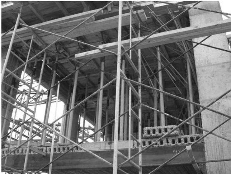
En lo que a vigas respecta, el molde se realiza con tableros de tablas yuxtapuestas que por razones de ejecución y practicidad se ejecutan fuera del encofrado para luego colocarlos en su respectiva posición sobre los cabezales de apuntalamiento (usualmente de tirantes de 3" x 3" con longitud mínima de 0,80 m para facilitar el flechado lateral de los citados tableros).
