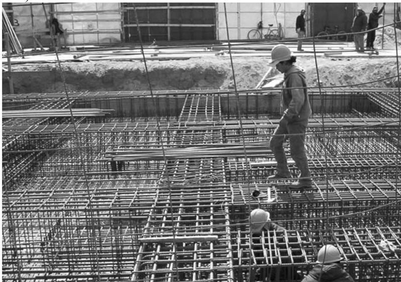
Figura 348: Proceso de armado de una platea de fundación
