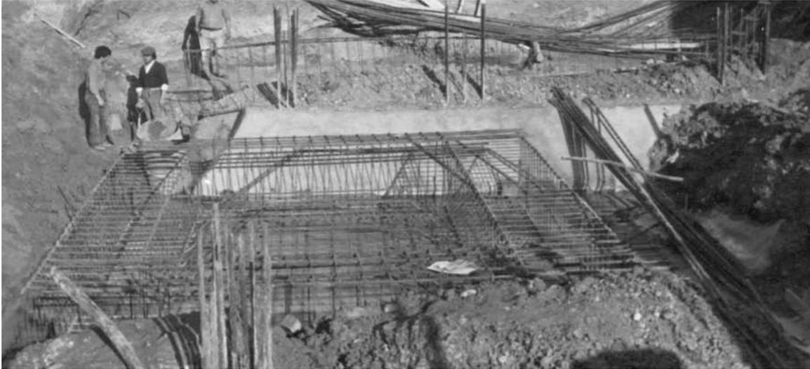
Figura 443: Aspecto de una base combinada para tres columnas (área posterior)
