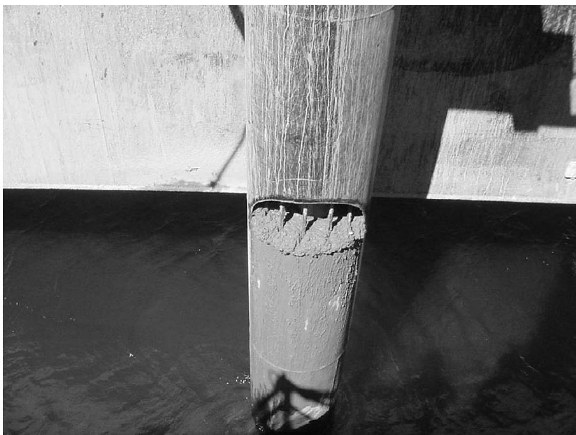
Figura 496: Hormigonado de un pilote perteneciente a un muelle mar3timo
