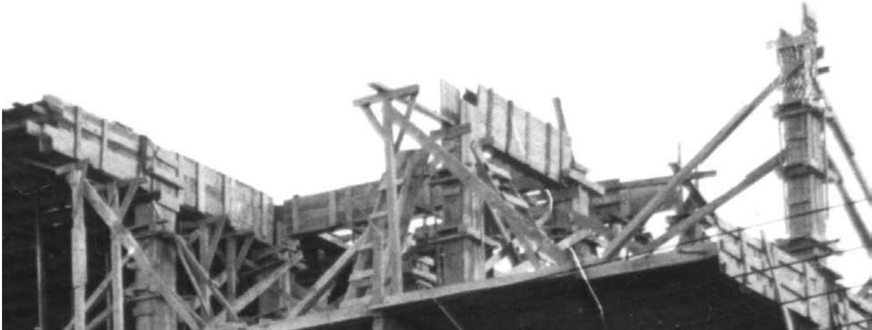
2) Construcción de encofrados para el hormigonado inicial de columnas, luego de vigas y losas.
