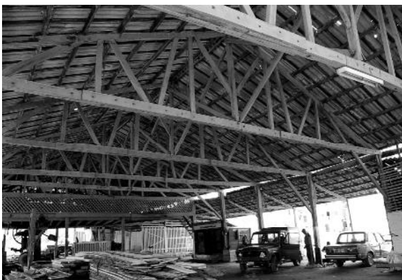
Fig. 9.62. Cercha de madera aserrada con 20 m de luz aproximadamente.
