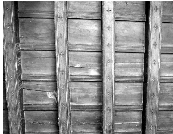
Fig. 9.16. Alfarje de tablero superior con tapajuntas.
