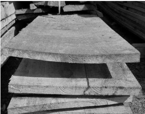
Fig. 4.18. Pandeo y rajadura de la madera por motivo del corte y secado.
