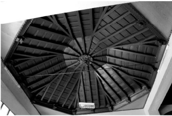
Fig. 9.50. Cubierta de Par y Nudillo con 8 faldones.
