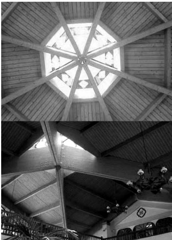
Fig. 1.10. Cubierta de madera laminada encolada, Lobby del Hotel Jibacoa.
