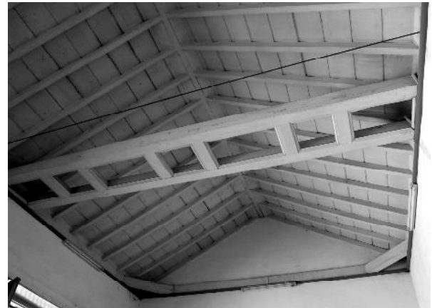
Fig. 1.9. Cubierta de Par y Nudillo con dos faldones.
