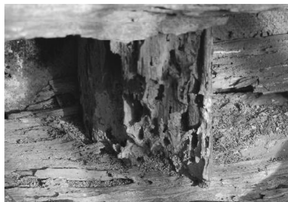
Fig. 11.4. Madera atacada por polillas.
