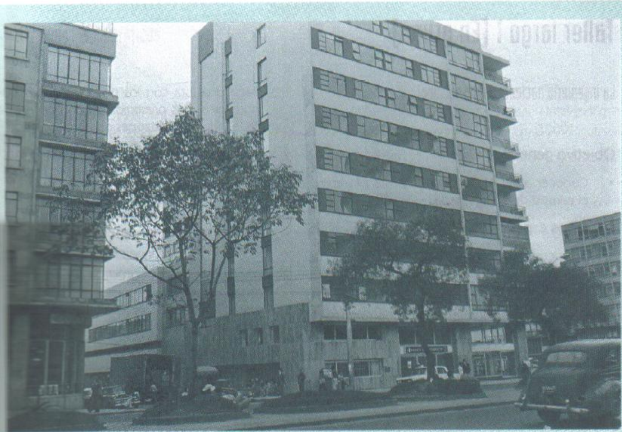
Figura 1.31. Panorámica del edificio Cudecom, después de su traslado.
