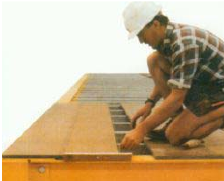
Figura 56. Estructuración de pisos.
