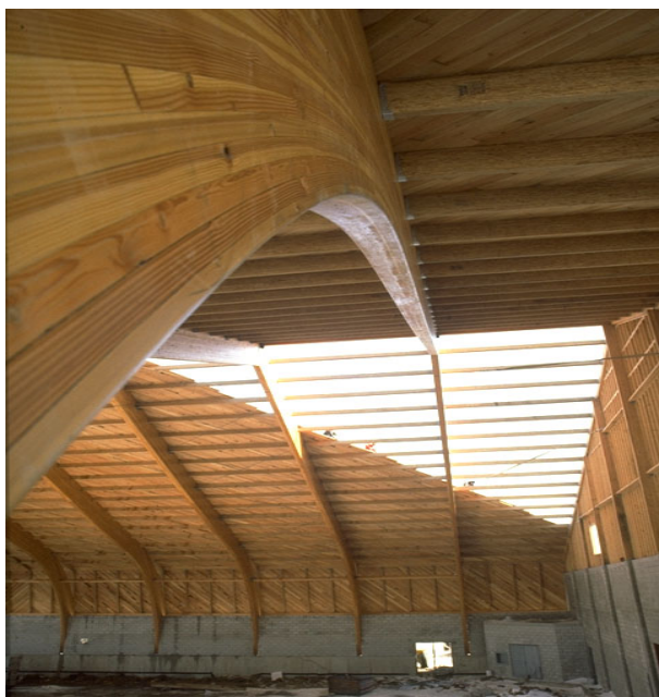
Viga conformada en el espacio funcional
