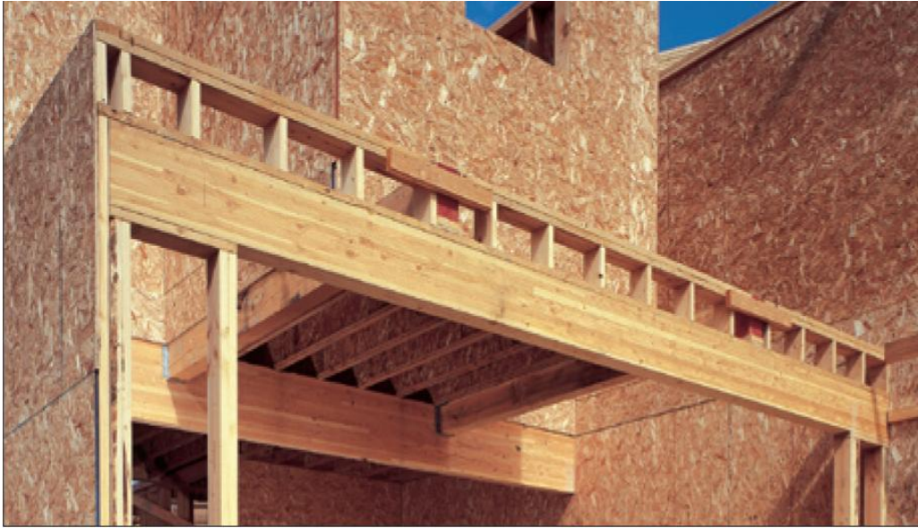
Figura 29. Construcción con OSB y otros EWP.
