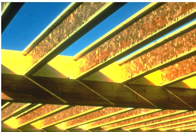
Figura 63. Aplicación de las vigas en “T”.
