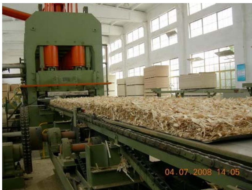
Figura 22. Prerensa para paneles OSB.
