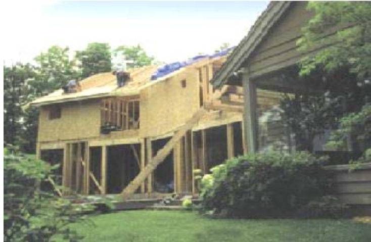
Figura 28. Construcción con OSB.
