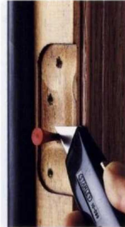
**2** Cubra con pegamento las T de golf o los taquetes; insértelos dentro de los agujeros desgastados de los tornillos. Espere a que seque el pegamento. Corte y elimine la parte sobrante del taquete o de la pieza.
