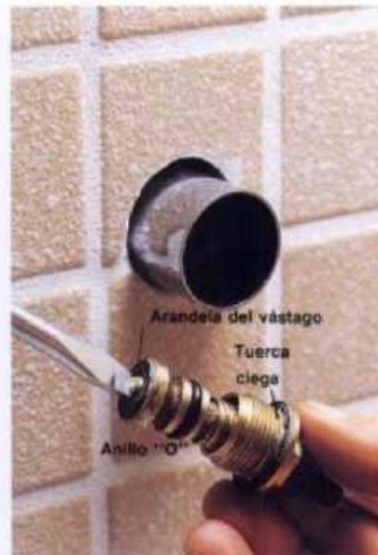
**3** Quitar y cambiar la roldana del vástago. Quitar y cambiar el anillo "O" usado, la roldana vieja de empaque o la cuerda de empaque. Lubricar ligeramente el vástago con grasa a prueba de calor y después ensamblar de nuevo el grifo.
