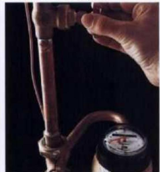
La **válvula principal de paso**, que se localiza cerca del medidor del agua, puede cerrarse para interrumpir toda el agua. Abrir los grifos de las partes más altas y más bajas de la casa para drenar las tuberías de agua.
