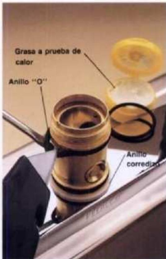
**5** Quitar el grifo con movimiento de torsión hacia arriba. Cortar con navaja los anillos "O" de empaque usados. Aplicarles grasa a prueba de calor a los nuevos anillos "O" e instalarlos. Instalar de nuevo el grifo con movimiento de presión hacia abajo hasta que el collarín se asiente sobre el anillo corredizo de plástico.
