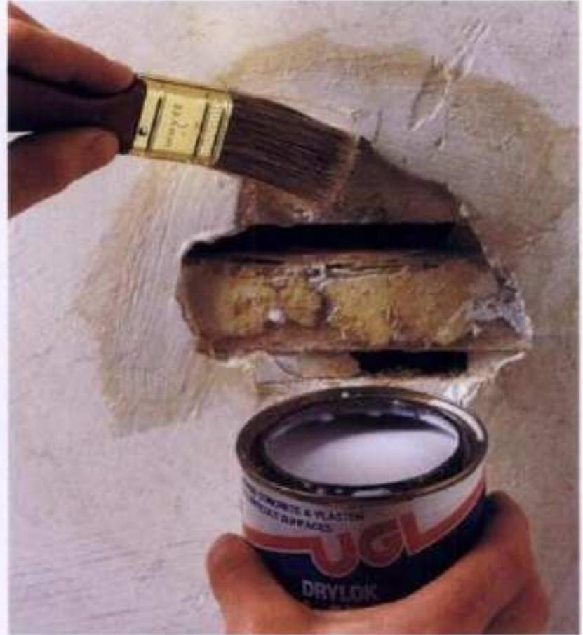
**2** Aplique con brocha líquido adhesivo de látex sobre el área que va a resanar. Recubra completamente los bordes del yeso viejo. No se deje mojar el área del resane después de recubierta. El yeso para resanar se mezcla a la densidad adecuada para que pueda aplicarlo con llana metálica.
