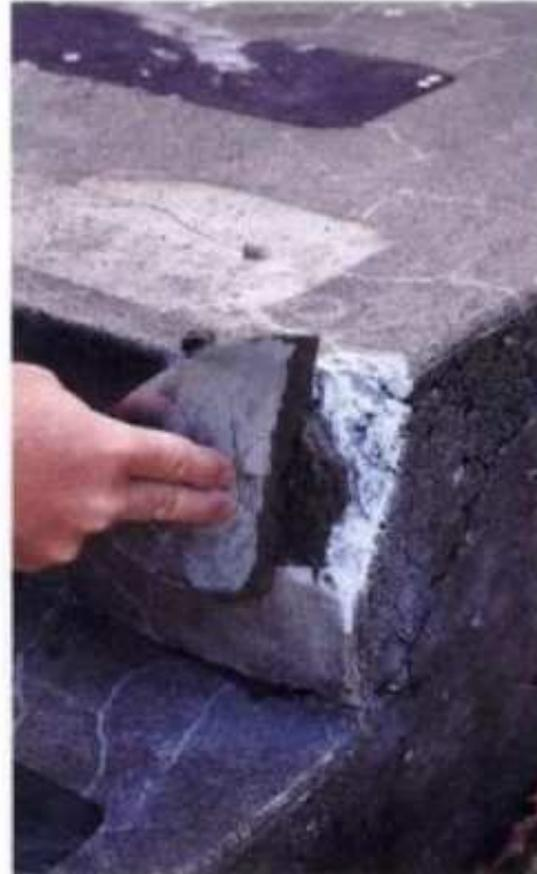
**2** Mezcle el resane para concreto con agua; después, vacíelo en el líquido adhesivo, según las instrucciones del fabricante. Aplíquelo en el área en reparación con una espátula flexible o con lana metálica.
