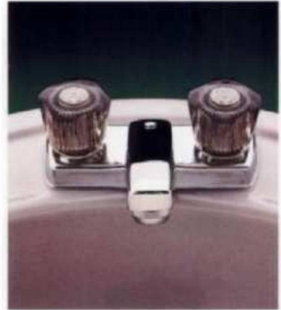
**Los grifos de compresión** (de vástago y asiento) de muchos lavamanos de dos llaves y los accesorios de baño tienen roldanas de neopreno que comprimen contra un asiento de válvula. Las tapas índice de la parte superior de las llaves del grifo ocultan los tornillos de las llaves.
