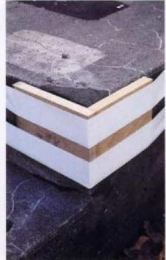
**3** Fije unas tablas con cinta adhesiva en la esquina del escalón, según se ilustra, para sujetar el resane hasta que se endurezca.
