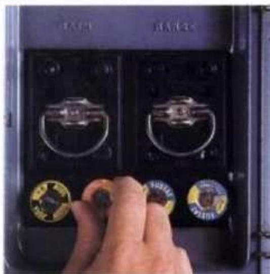
**Los fusibles** controlan la carga de corriente en los sistemas anteriores de alambrado. Identifique el fusible que controla los alambres en los cuales se va a trabajar. Sin tocar más allá del borde aislado, desenrosque el fusible y póngalo a un lado. Los alambres se prueban con el probador de circuitos antes de comenzar el trabajo de reparación.
