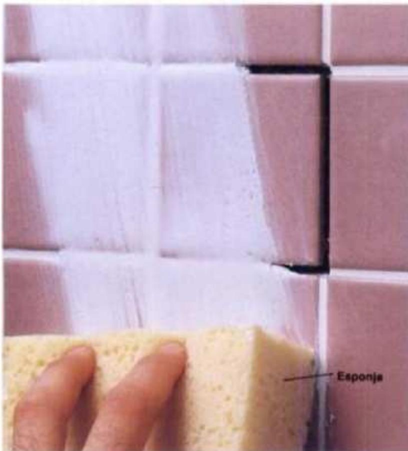
**3** Desprenda la cinta de recubrir. Aplique la lechada premezclada de cemento para azulejo con una esponja o una llana de madera. Espere a que la lechada se solidifique ligeramente; después, limpie y elimine el excedente con un trapo húmedo.
