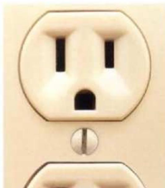
**Los enchufes conectados a tierra** tienen dos ranuras y una perforación. Adquiera un enchufe de repuesto con las mismas capacidades de amperes, volts y diámetro de alambre del receptáculo viejo (página 39).
