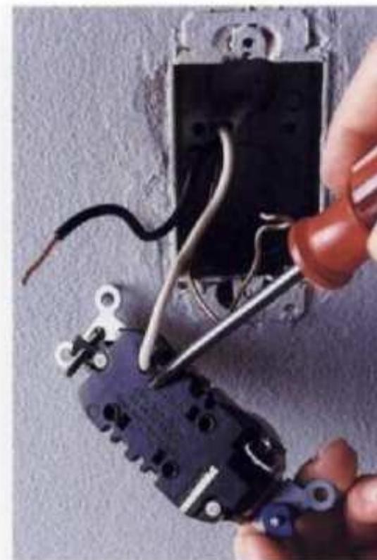
**3** Inserte las punta de un desarmador pequeño hacia adentro de la ranura de liberación para soltar las conexiones de presión; o afloje las terminales roscadas para quitar el enchufe de los cables.
