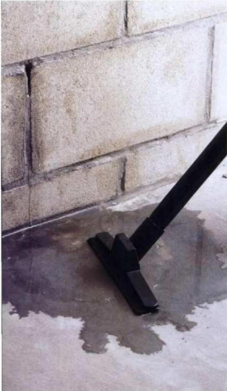
**Los sótanos húmedos** causan daños a los muebles, a los aparatos eléctricos y a los pisos. La causa de la humedad en los sótanos por lo general se encuentra en canalones del techo y en canales de descenso obstruidos, con agujeros por herrumbre, o cuya salida no quede alejada de la pared de la casa. Para corregir la falla, se reparan los canales de descenso y los canalones (páginas 112, 114) y se revisa el grado de inclinación del terreno alrededor de la cimentación (página 113).
