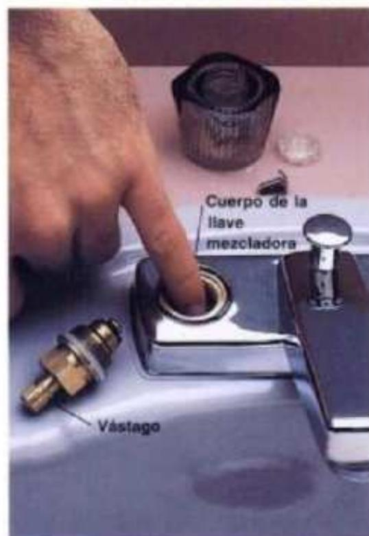
**1** Las fugas persistentes probablemente indican que un asiento de válvula del interior del cuerpo del grifo se encuentra dañado. Quitar el vástago de la espita y tocar el asiento de válvula con la punta del dedo índice. Si se siente áspero, cambiar el asiento, o reafinarlo con herramienta reafinadora de asientos (a la derecha).
