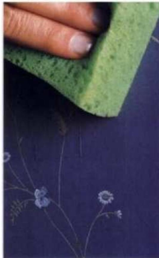
**3** Desprenda la parte dañada. Aplique adhesivo por atrás del corte de remiendo; con cuidado colóquelo en la abertura y haga coincidir la pieza cortada. Limpie con una esponja limpia y húmeda.
