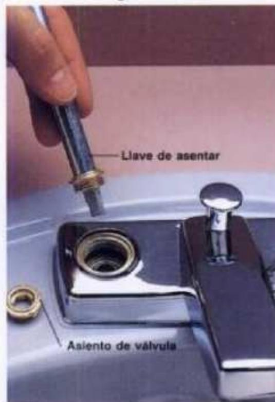
**2** Quitar el asiento desgastado con la llave para asientos. Seleccionar el extremo de la llave que se adapte al asiento de válvula e insertarlo hacia adentro del grifo. Girar en sentido contrario a manecillas de reloj para quitarlo. Usar la llave para introducir el nuevo asiento. Si no se puede sacar el asiento, reafinarlo con la herramienta reafinadora de asientos (a la derecha).
