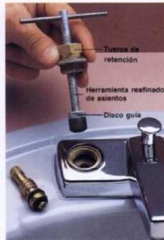
**Para rectificar** (reafinar) un asiento de válvula seleccionar un disco guía que se adapte al grifo. Fijar el disco a la herramienta rectificadora e insertar la tuerca de retención. Apretar ligeramente la tuerca de retención hacia adentro del grifo. Presionar ligeramente la herramienta hacia abajo y girar el esmerilador en sentido de manecillas de reloj. El asiento queda rectificado cuando la herramienta gira fácilmente.
