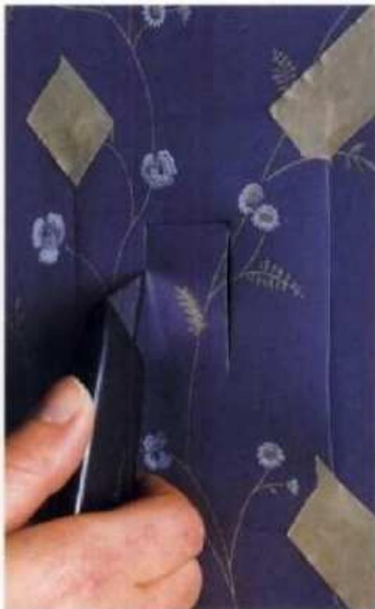
**2** Corte las dos capas de papel tapiz con una navaja bien afilada para obtener una plantilla que se ajuste exactamente. Desprenda el material de remiendo; después, humedezca el área del tapiz que está dañada.
