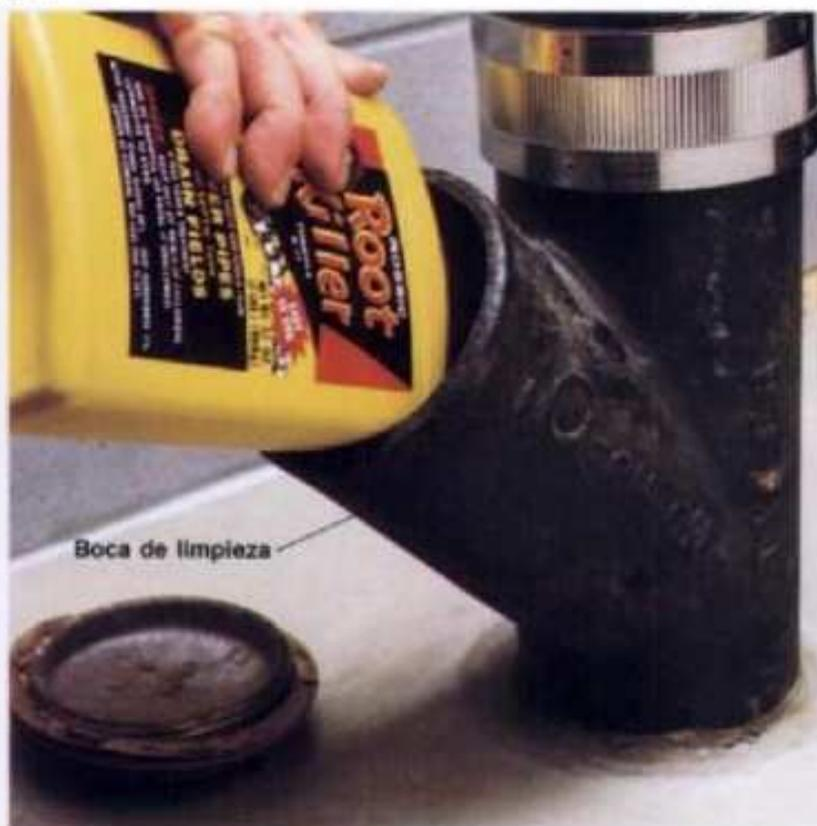
**2** Vaciar aproximadamente 2 tazas de eliminador de raíces de sulfato de cobre en el tubo principal del drenaje. Cambiar el tapón principal del tubo de drenaje. Dejar que la acción química trabaje toda la noche antes de soltar agua corriente o baldear el inodoro. Las raíces son destruidas por los cristales y después son deslavadas.
