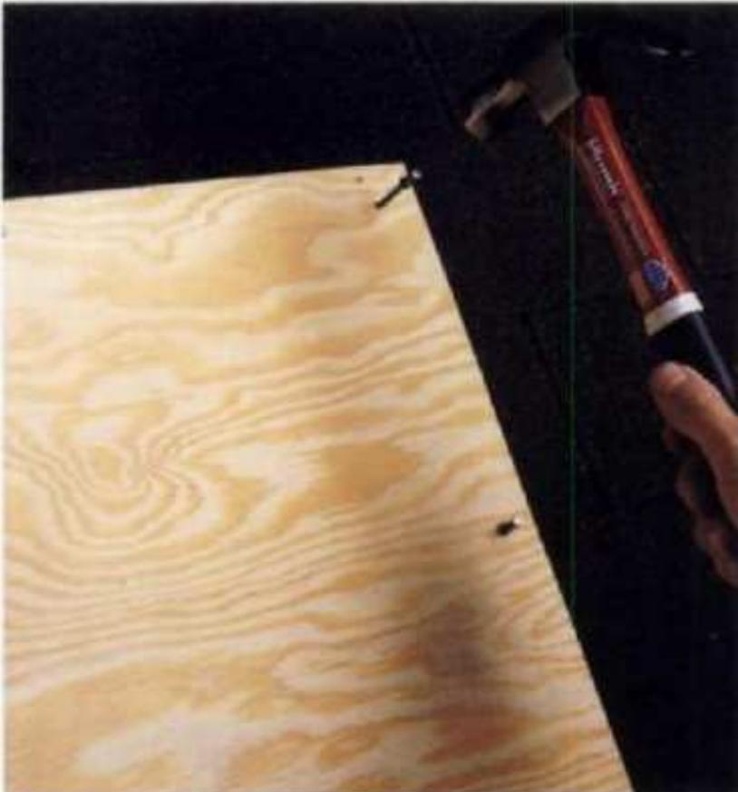
Una hoja de madera laminada se puede usar como cubierta de emergencia en el techo. Usar clavos de doble cabeza para fijar temporalmente la hoja de madera. Los agujeros se resanan con mástique después de que se quitan los clavos.
