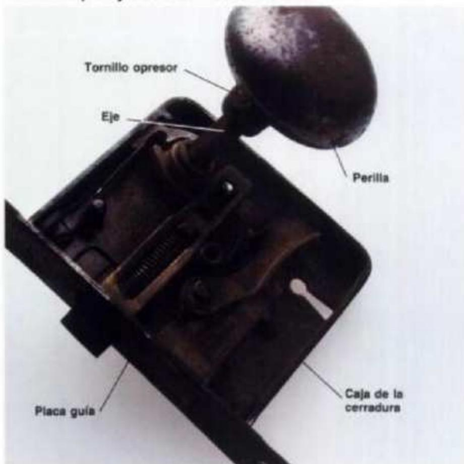
**Cerradura de paso vieja.** Se afloja el tornillo opresor de la manija para quitar las manijas y el husillo. También se aflojan los tornillos de la placa de sujeción y con una palanca se saca la cerradura de la puerta. Quitar la tapa o placa de sujeción de la cerradura. Rocíar solvente lubricante en todas las piezas. Quitar el lubricante que sobre y ensamblar de nuevo la cerradura.
