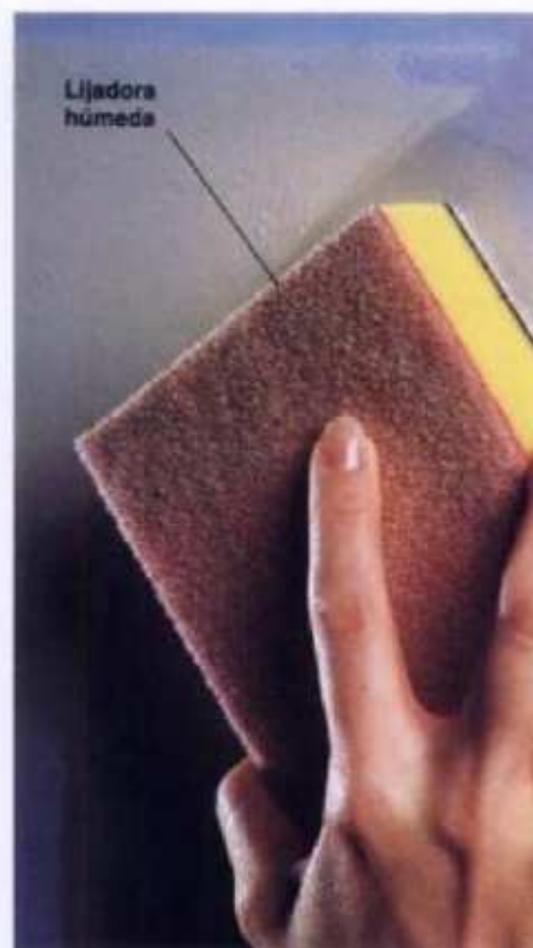
**6** Aplique una segunda capa de compuesto. Una vez que esté seco se pule ligeramente con lijadora húmeda o lija común para alisar el remiendo. Retoque la pared.
