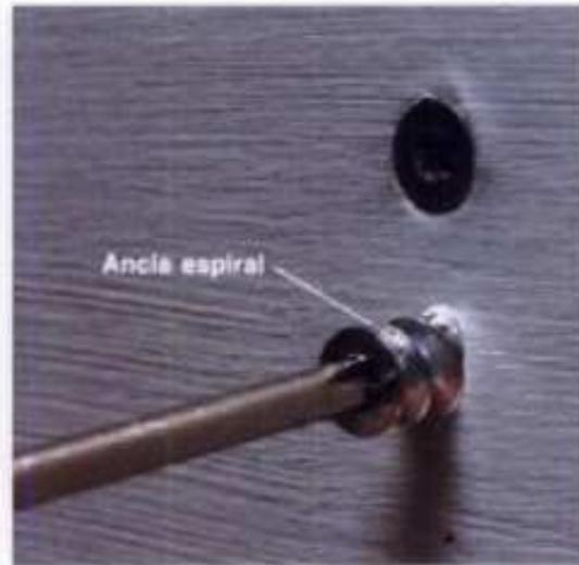
**3** Coloque las anclas de torsión dentro de la pared seca. Después, atornillelas. Si las monta en una pared recubierta de yeso, taladre agujeros guía para tornillos Grip-It®
