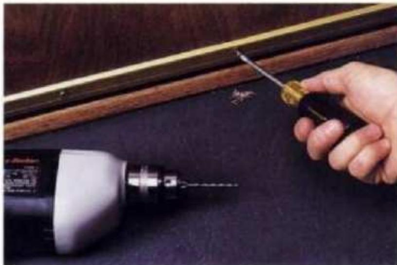
**2** Taladre barrenos piloto para los tornillos; después fije con tornillos la tira en el interior de la puerta para que el fieltro o vinilo selle la abertura debajo de la puerta. Las perforaciones ovaladas permiten efectuar el ajuste necesario.
