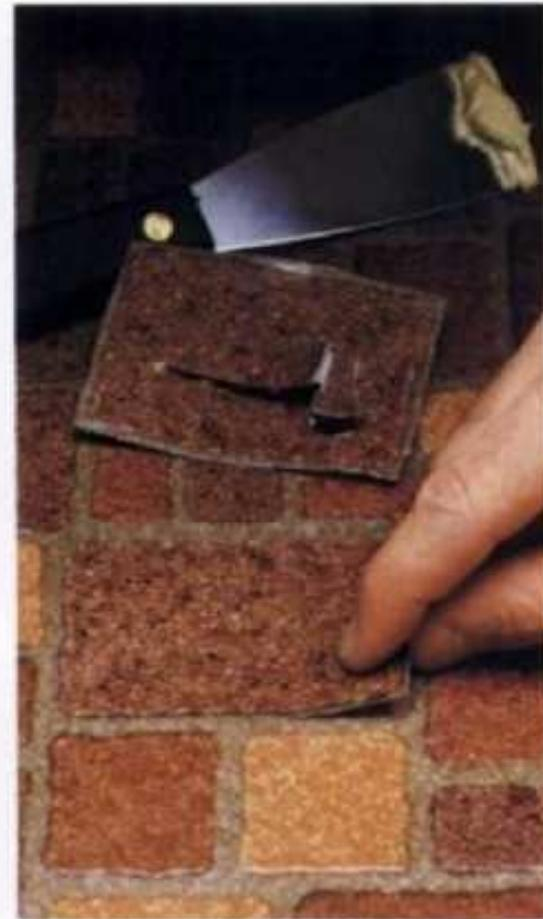
**3** Aplique soluciones minerales para disolver el adhesivo; después limpie con espátula de vidriero o con un raspador tipo rastrillo. El nuevo adhesivo se aplica al fragmento de reemplazo y se adapta dentro de la cavidad. Se pasa el rodillo sobre el vinilo para aplanarlo y que quede bien pegado. Quite el adhesivo sobrante.
