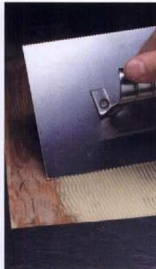
**3** Aplique el adhesivo al contrapiso. Coloque la loseta en la cavidad. El rodillo se utiliza para aplanar la loseta y lograr buena adherencia. Quite el adhesivo sobrante.
