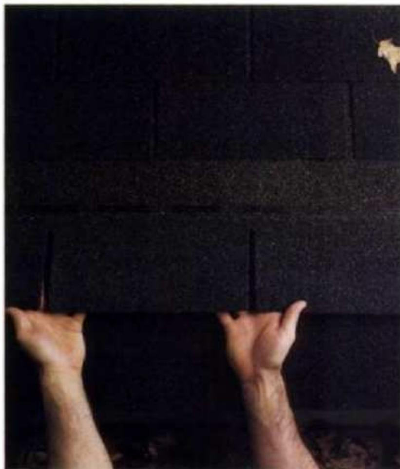
**2** Inserte la nueva teja; debe quedar alineada con las tejas adyacentes. Desprenda el revestimiento que cubre el adhesivo por detrás de la teja.
