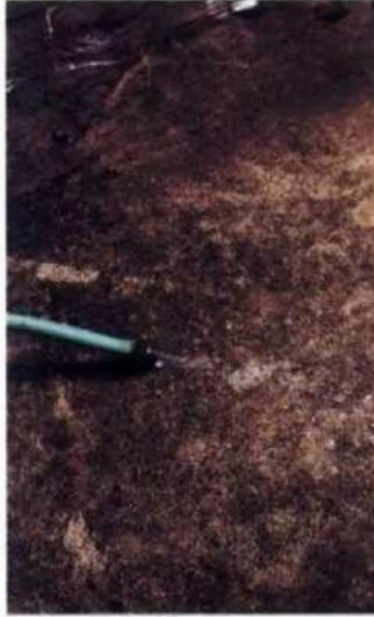
**2** Vierta en la superficie con solución de fosfato trisódico, después enjuague con una manguera o con regadera mecánica de alta presión.
