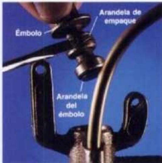
**2** Jalar hacia arriba del émbolo para quitarlo. Con una alzaprima se alfoja la roldana usada. (Quitar el tornillo del vástago, si es necesario.) Con la alzaprima también se alfoja la roldana ranurada de empaque o el anillo "O" de empaque.
