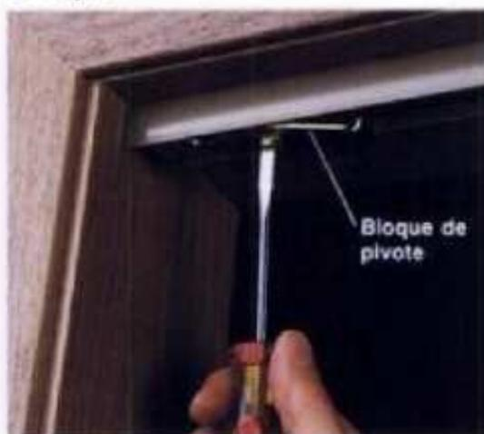
**2** Verifique el alineamiento de las puertas cerradas dentro de su marco. Si la separación que queda con la puerta cerrada no es pareja, ajuste los bloques superiores de pivote con un desarmador o con una llave.
