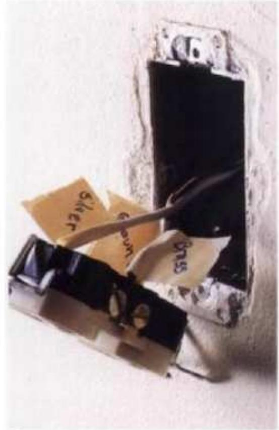
**Marcar los alambres** con pequeños marbetes de cinta para recubrir antes de desconectar un contacto o un interruptor. Los alambres se unen al nuevo enchufe o al interruptor según las marcas que tienen los marbetes.
