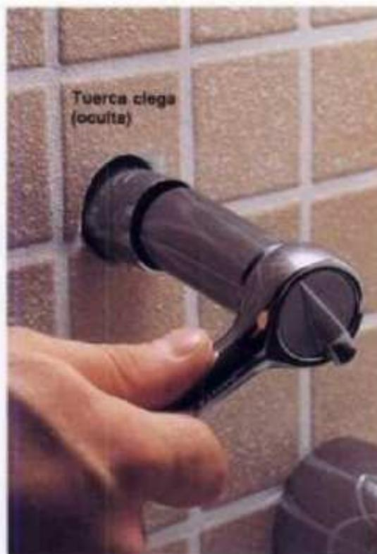
**2** Quitar la tuerca ciega por medio de una matraca reversible y dado hondo. (Desbastar el azulejo de atrás en la pared y rebajar yeso o concreto de alrededor de la tuerca, si es necesario.) Si la tuerca se atora, aplicar aceite penetrante y esperar 15 minutos.
