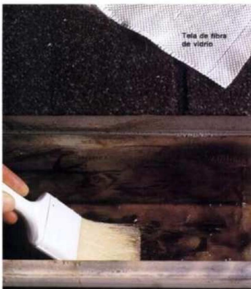
**3** Para las demás áreas oxidadas, aplique con una brocha resina de fibra de vidrio sobre el metal. Cubra la resina con tela de fibra de vidrio cortada a la medida del canalón. Espere hasta que la resina se endurezca ligeramente, después, aplique más resina con la brocha. Deje que se seque la resina toda la noche.
