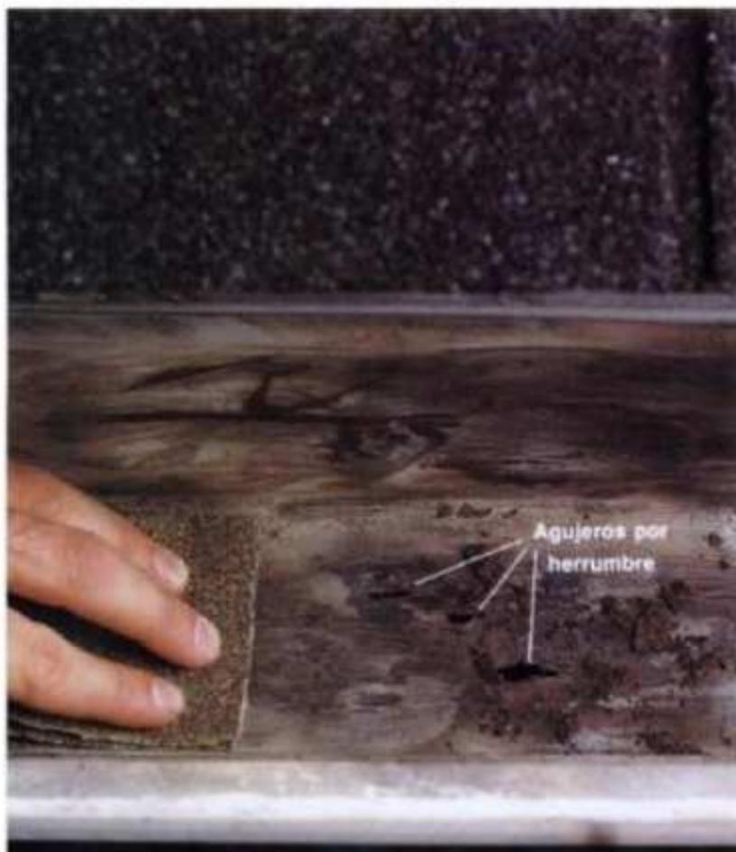
**1** Raspe toda la pintura levantada y la herrumbre con papel de lija o un raspador. Los agujeros se tapan con una sección de canalón igual. Use un juego de herramientas y materiales para reparaciones con fibra de vidrio para resanar otras áreas herrumbrosas.
