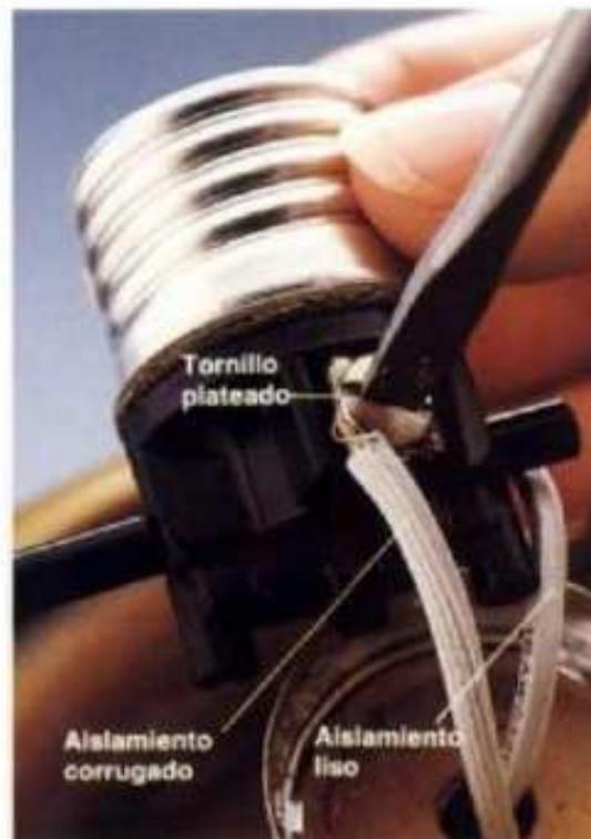
**5** Si el cordón y la clavija funcionan bien, cambie el portafoco; instale uno que tenga la misma capacidad de amperes y volts del portafoco viejo. Uno de los dos alambres del cordón plano está revestido de aislante corrugado o marcado; este alambre se conecta a la terminal roscada plateada. El otro se conecta a la terminal de bronce.
