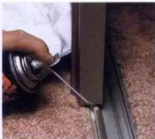
**2** Aplique el solvente lubricante en todos los rodillos. Cambie las partes dobladas o desgastadas.
