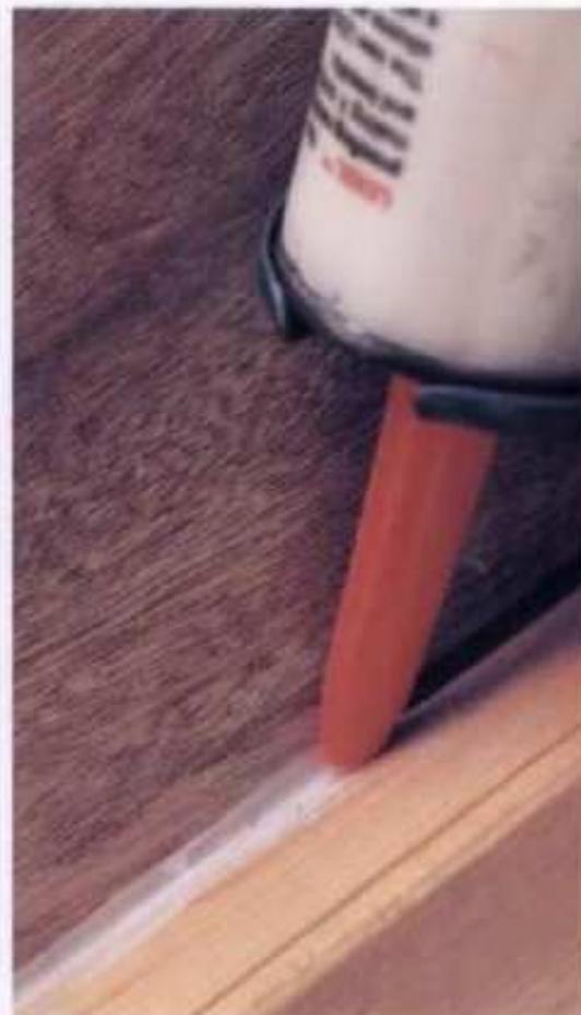
**3** Sostenga la pistola en posición inclinada y apriete el gatillo uniformemente durante el calafateo. Corra la punta del tubo de calafateo firmemente para aplicar el reborde en forma uniforme.
