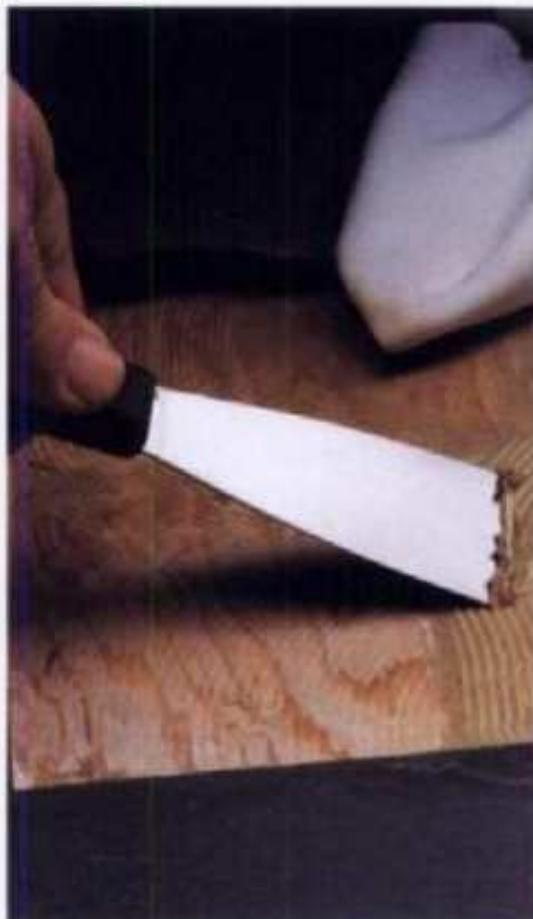
**2** Aplique sales minerales para disolver el adhesivo del recubrimiento. Raspe todo el adhesivo con espátula o raspador tipo rastrillo.
