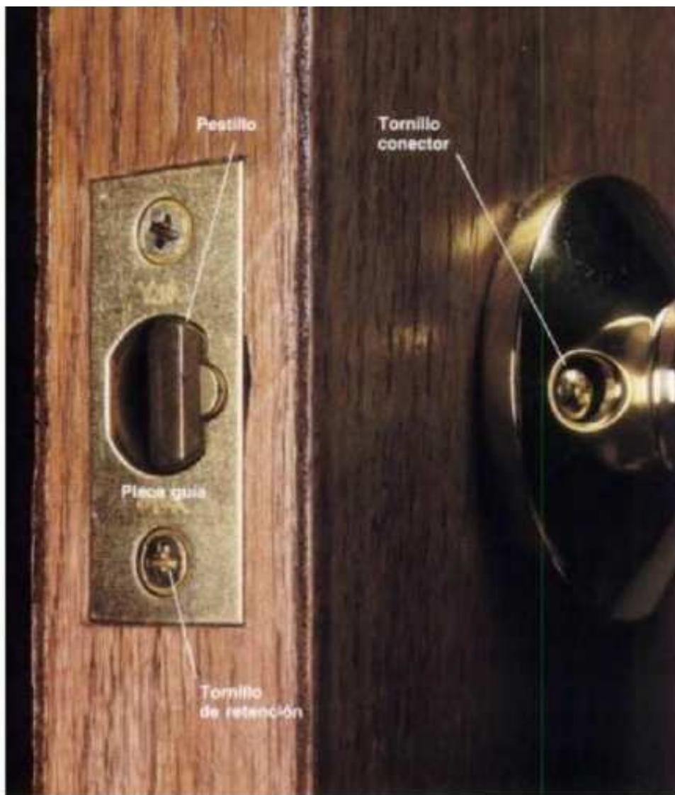
**El pestillo que se atora** es un problema que se debe a la acumulación de mugre y a la falta de lubricación. Limpiar y lubricar la cerradura (páginas 67-68). Asegurarse de que los tornillos de conexión no estén demasiado apretados. Un tornillo apretado excesivamente origina que el pestillo se atore.
