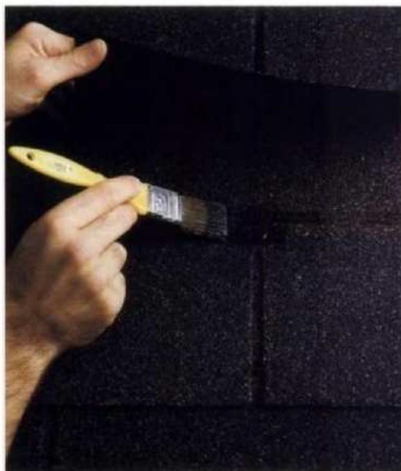
**4** Aplique un poco de mástique para techos en cada cabeza de clavo y presione para aplanar las tejas. El calor solar activará el adhesivo y la teja quedará sellada.
