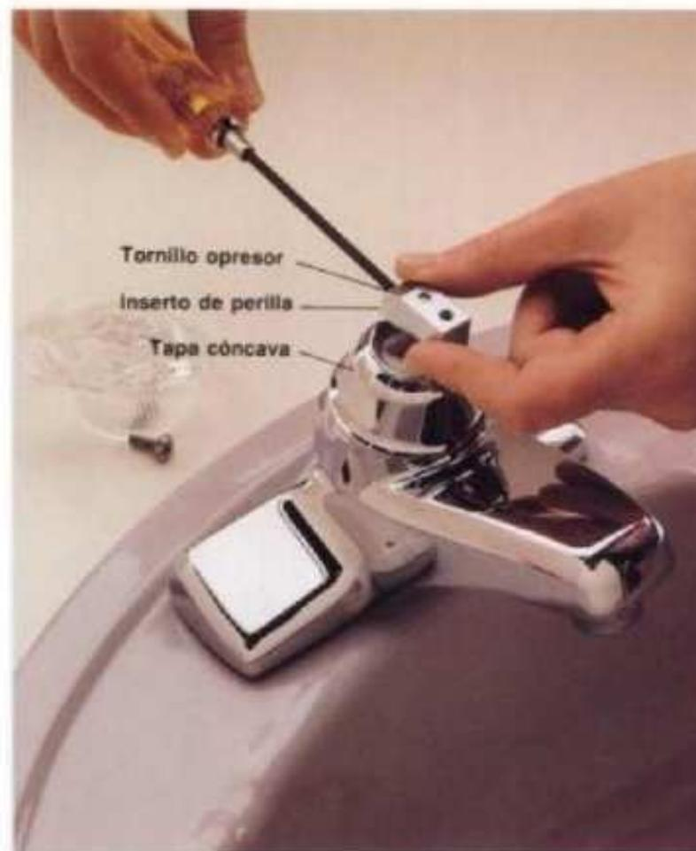
**2** Usar una llave allen para aflojar el tornillo opresor; después quitar el inserto de la manija. Desenroscar y desprender la tapa cóncava.
