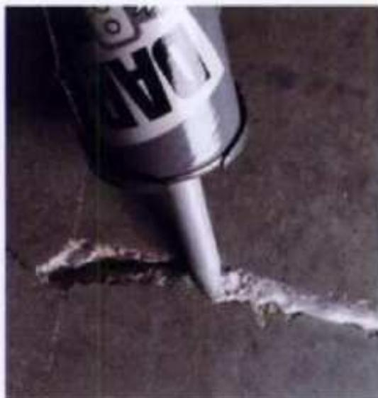
**2** Utilice una pistola de calafatear para aplicar el resane de mampostería a la abertura. Los compuestos de látex de relleno para mampostería se aplican y se limpian fácilmente.
