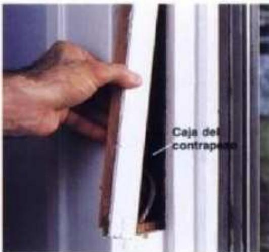
**4** Levante con una palanca o desenrosque la tapa de la caja del contrapeso que se encuentra en el extremo inferior de la ranura de la ventana. Saque del interior de la caja el contrapeso. Quite el cordón viejo del contrapeso del marco de ventana.
