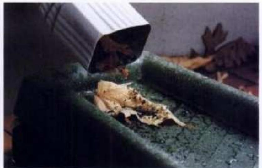
**La grava en los canales de descenso** o en los canalones de lluvia indica que hay desgaste en la superficie de las tejas. Probablemente pronto sea necesario cambiar el techado.
