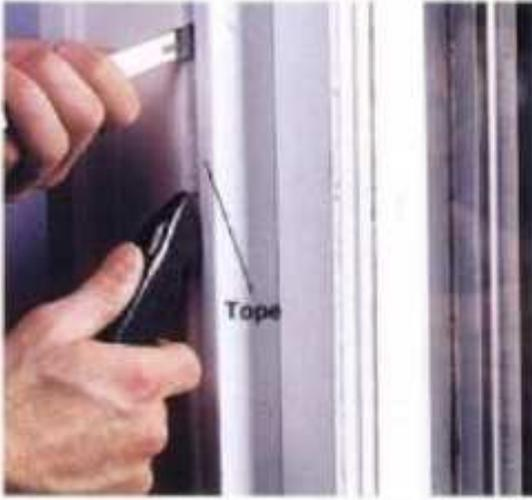
**1** Corte cualquier sello de pintura que haya entre el marco y los topes de la ventana, con una cuchilla o una espátula dentada. Con una palanca levante los topes para separarlos de la ventana, o quite los tornillos.
