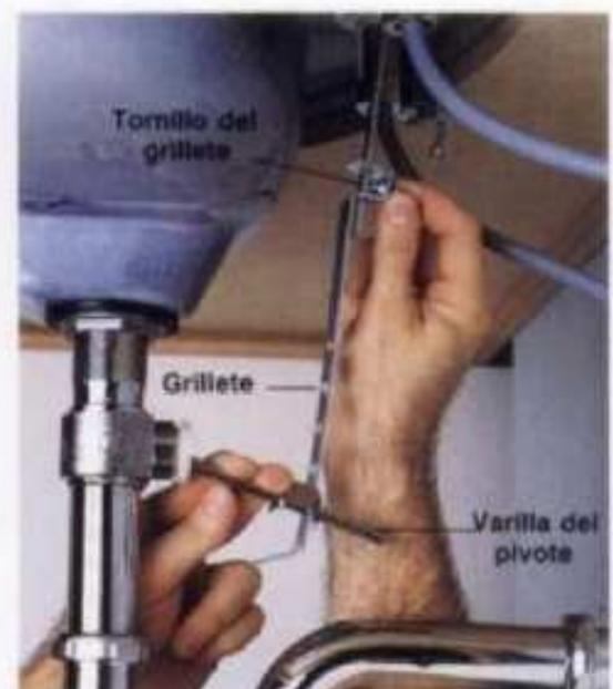
**3** Si el lavamanos no desagua correctamente, aflojar el tornillo del grillete abajo del fregadero. Jalar la varilla de pivote hacia abajo y apretar de nuevo el tornillo del grillete. Si el tapón no funciona, mover la varilla de pivote a un barreno más alto en el grillete.
