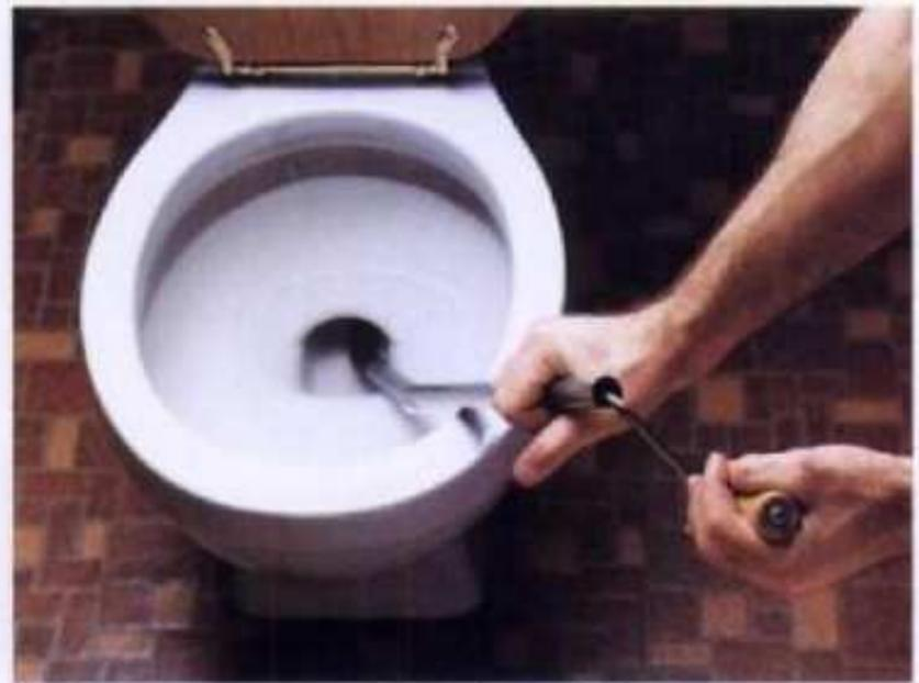
Usar una sonda espiral de fabricación específica para deshacer obstrucciones de inodoros. Insertar la sección acodada de caucho hacia adentro de la abertura y darle movimiento de manivela a la manija para impulsar el espiral hacia adentro de la trampa del inodoro. Cuando la punta se encaje hacia adentro de la obstrucción, extraer con cuidado los desechos, o mover el espiral de la barrena hacia adelante y hacia atrás para desmenuzar la obstrucción.
