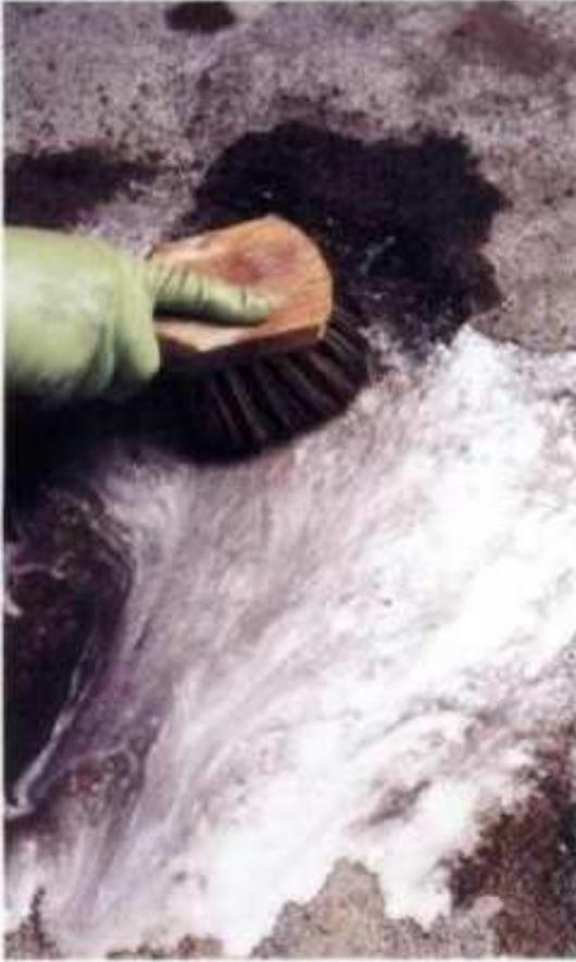
**1** Limpie el concreto con un cepillo y una solución al 5% de ácido muriático, de venta en centros comerciales para el hogar. Use guantes y ropa de protección cuando trabaje con el ácido.
