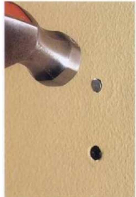
**2** Hunda con martillo el clavo zafado para que quede una marca pequeña. Resane las marcas con pasta de recubrir. Espere a que el resane se seque para que pueda pintarlo.
