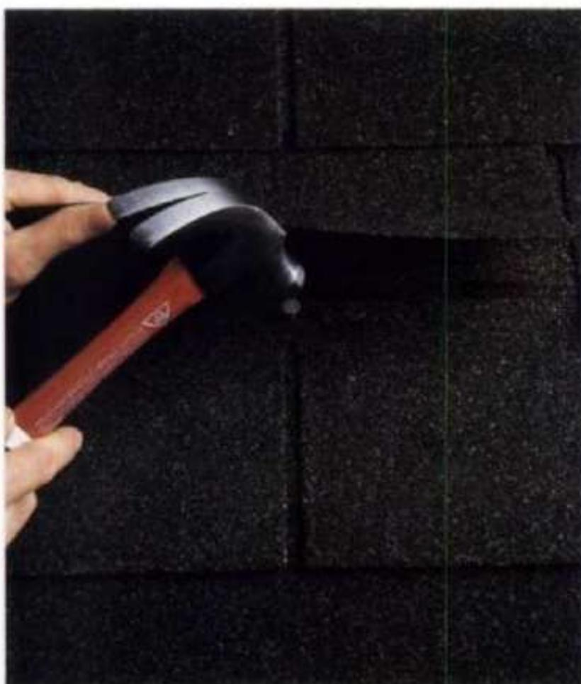
**3** Utilice clavos galvanizados para techos en cada lado y en la parte superior de cada ranura de la nueva teja. Las cabezas de los clavos deben quedar tapadas por las tejas traslapadas.
