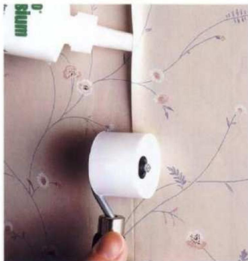
**Para arreglar las orillas** se alza el borde del tapiz y se inserta la punta del aplicador de pegamento por debajo. Oprima el envase y aplique el adhesivo en la pared. Aplane la orilla nuevamente en su lugar con un rodillo y quite el adhesivo sobrante con una esponja limpia y mojada.
