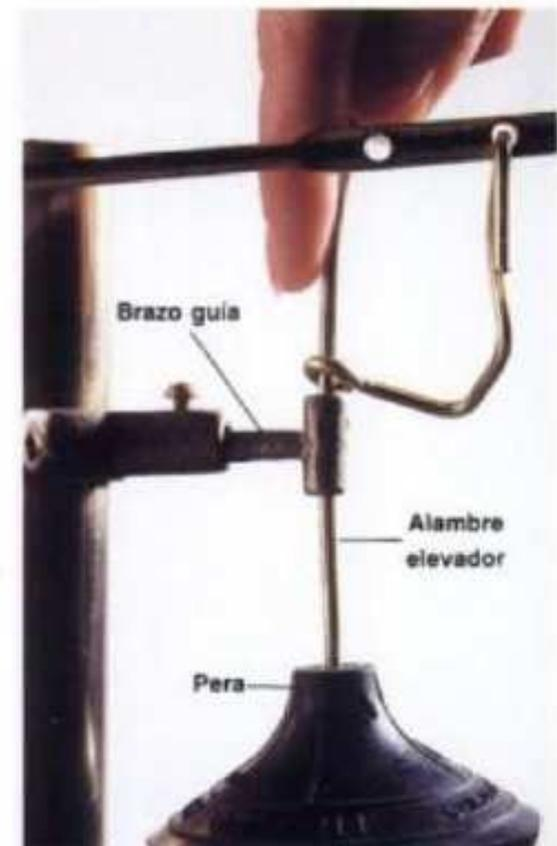
**3** Enderezar el alambre elevador vertical del mecanismo de bola del depósito. La bola debe ascender y descender suavemente cuando se dispara la palanca. Abrir la válvula del agua para llenar de nuevo el depósito y probar con baldeo.
