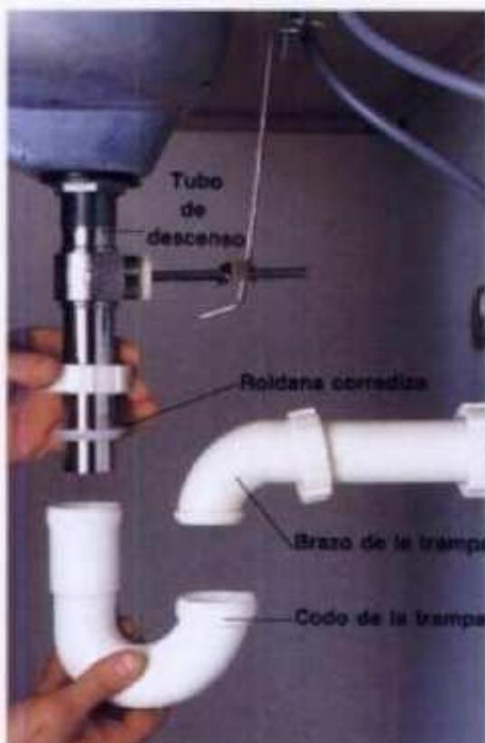
**2** Deslizar la tuerca corrediza por sobre el extremo del vástago roscado del grifo (cuerda hacia abajo), después una roldana (lado ahusado hacia abajo). Empujar el extremo largo del acodamiento de la trampa por sobre el extremo de vástago roscado del grifo y deslizarlo hacia arriba hasta que el extremo corto quede alineado con el brazo de la trampa. Deslizar la roldana y la tuerca hacia abajo del extremo de vástago roscado del grifo y apretarlos a mano por sobre el acodamiento.
