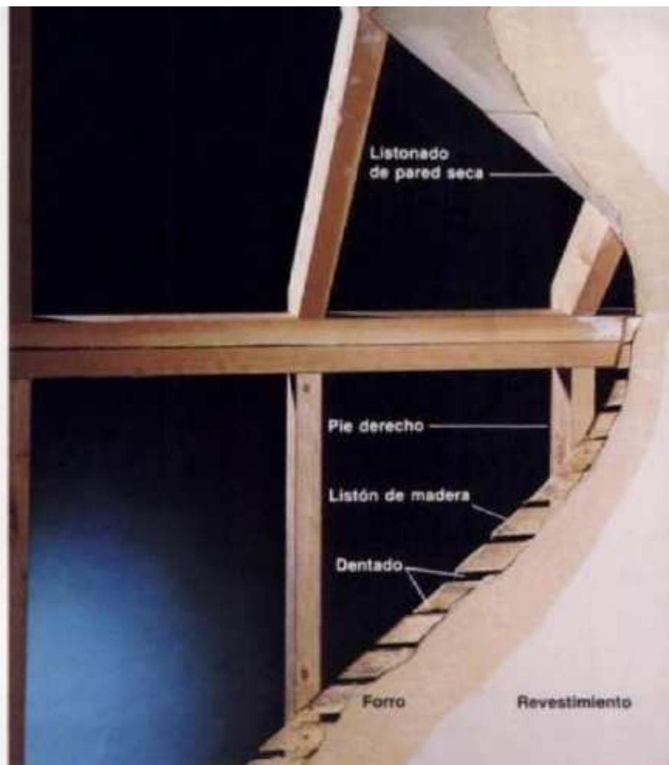
**Paredes de yeso prefabricadas**, conocidas también como muro seco, en la construcción de éstas se usan paneles de yeso fijados con clavos o tornillos directamente al bastidor. El espesor varía de  $\frac{1}{4}$ " a  $\frac{5}{8}$ ". Los pies derechos o vigas detrás de la pared de yeso por lo general se localizan a intervalos de 16" o 24", medidos de centro a centro. Se pueden usar una amplia variedad de dispositivos de sujeción.
