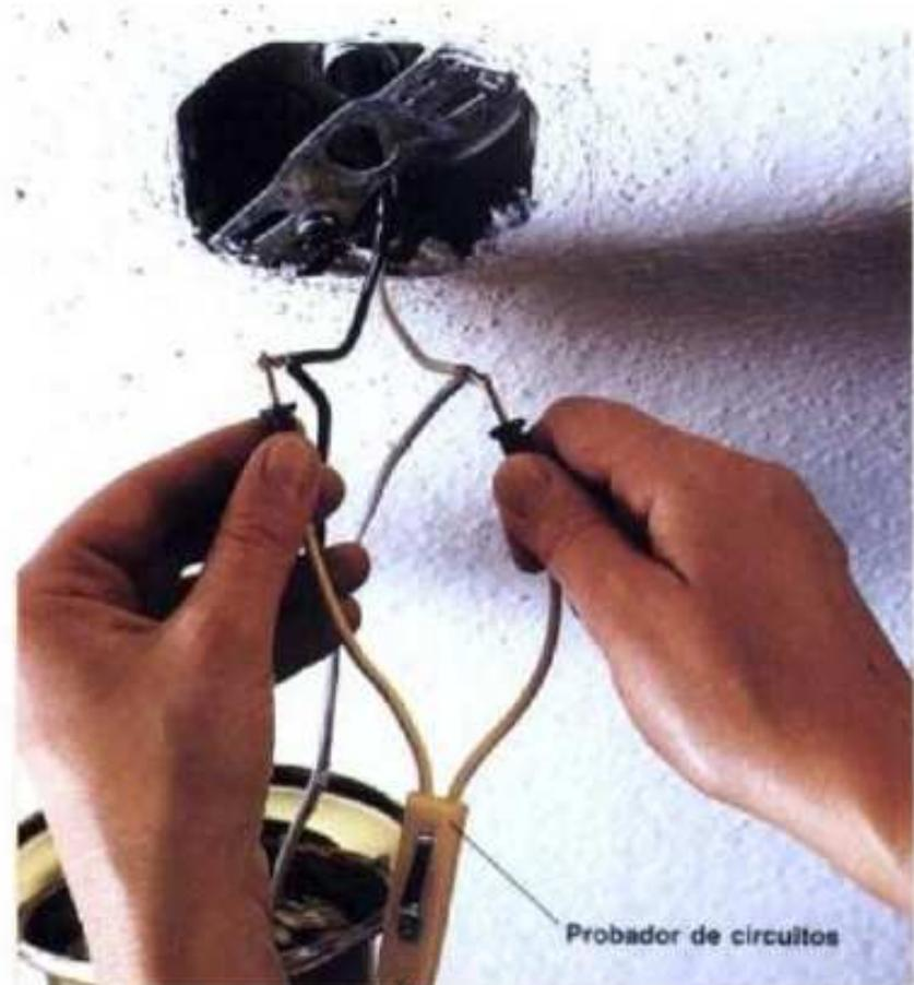
**2** Desenrosque los conectores; tenga cuidado de no tocar los alambres. Para probar si tienen corriente, toque con una punta del probador de circuitos el alambre negro desnudo. Con la otra punta de contacto toque el alambre blanco desnudo, después toque la caja metálica. Mueva lenta y rápidamente el interruptor y repita la prueba. Si el probador no se enciende en ningún caso, los alambres se pueden tocar sin peligro alguno.
