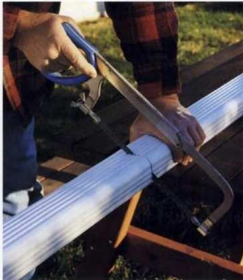
**2** Con una sierra para metales corte una sección de canal de descenso de longitud de 6 a 8 pies de longitud.
