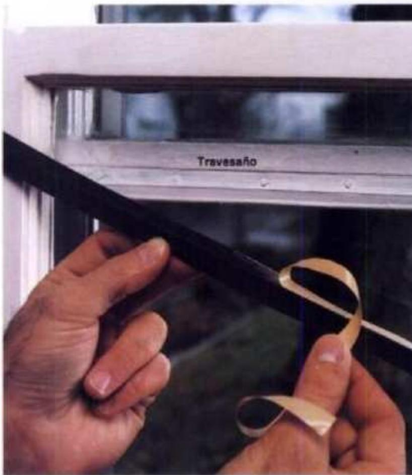
**5** Corte el gualdrín en V a la medida del travesaño de cierre de la ventana superior. Pliegue el gualdrín; después, desprenda el recubrimiento.
