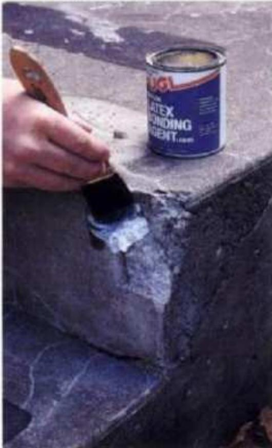
**1** Limpie el concreto despastillado con un cepillo metálico. Aplique líquido adhesivo de látex con una brocha en el área de resane.
