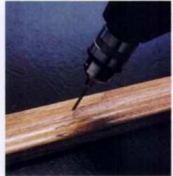
**Pretaladrar la madera** para evitar que se rajen. Usar un clavo sin cabeza como broca para perforar rápida y exactamente el orificio del calibre requerido.
