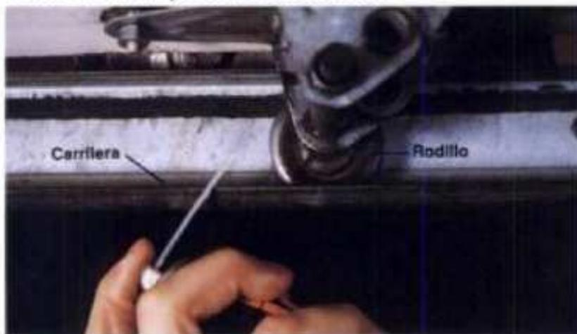
**1** Limpie los rodillos y las carrileras de la puerta con un trapo; después rocíelos con lubricante. Apriete los tornillos y tuercas flojos. **No** intente ajustar los resortes de acero; están bajo alta tensión y deben ser ajustados por un profesional.
