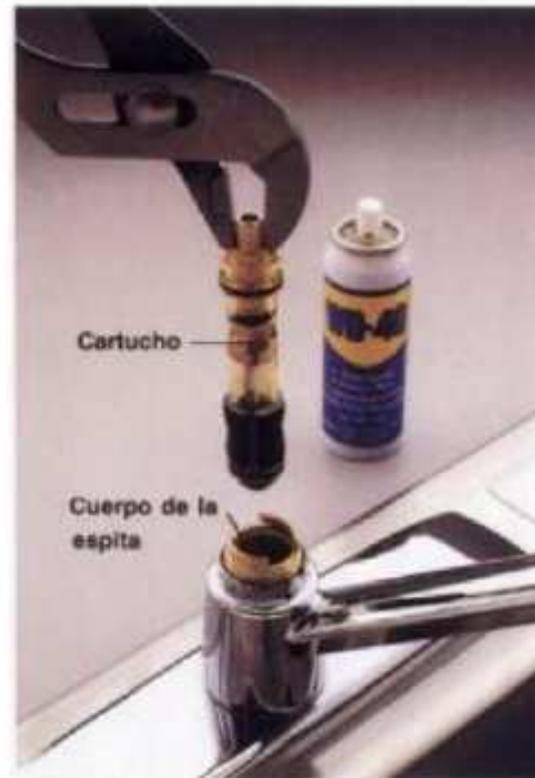
**Para quitar un cartucho apretado** se le sujeta por la parte superior del vástago con pinzas de ranura y se le alza con movimiento suave hacia adelante y hacia atrás. Se aplica aceite penetrante para facilitar la operación. Téngase cuidado de no doblar el cartucho ni dañar el cuerpo del grifo.
