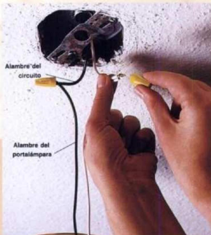
**5** Junte y tuerza los hilos metálicos de cobre del cable negro. Utilice un conector roscado para conectar al alambre negro del circuito. Haga lo mismo con los hilos del cable blanco. Después se conecta al alambre blanco del circuito.
