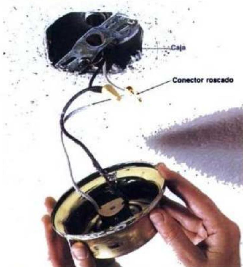
**1** Desconecte la corriente eléctrica hacia el arillo portafoco en el tablero principal de servicio (página 38). Afloje los tornillos de retención para quitar la base. Quite los tornillos de sujeción o gire ligeramente el arillo para zafarlo de los tornillos alojados. Jale con cuidado este accesorio para retirarlo de la caja de salida y tener a la vista los alambres.
