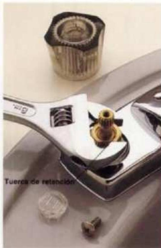
**2** Usar llave ajustable o pinzas para aflojar la tuerca de retención (o tuerca de empaque en grifos más antiguos). Quitar manualmente la tuerca de retención, después quitar el vástago del cuerpo del grifo.
