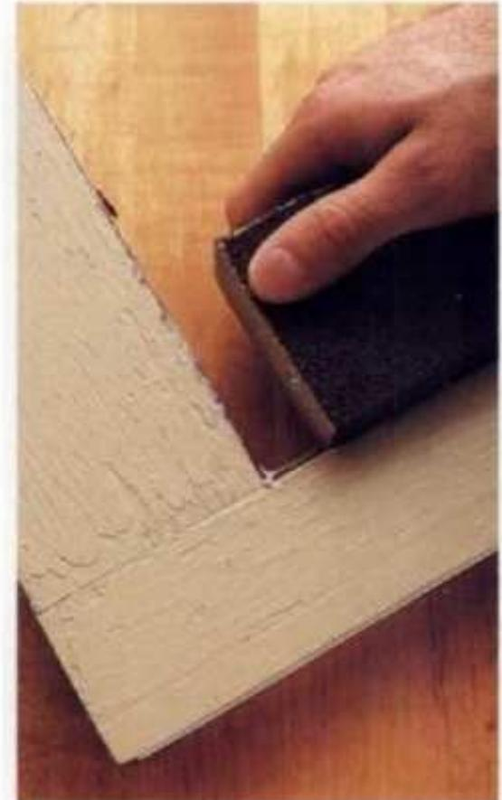
**3** Quite el vidrio quebrado y las puntas metálicas de vidriar; después lije las ranuras en forma de L para eliminar la pintura y masilla. Proteja la madera desnuda con una mano de sellador y espere hasta que se seque.
