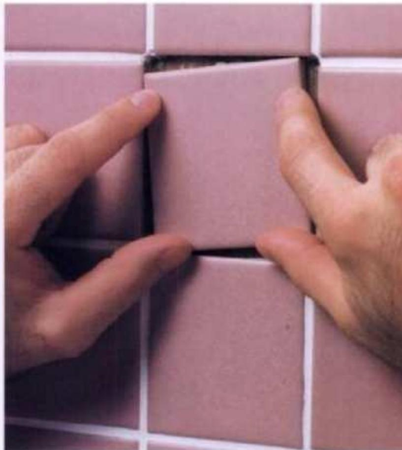
**2** Pruebe el ajuste de la nueva pieza de azulejo para verificar que quede al ras con las otras piezas. Extienda una capa de adhesivo sobre la parte de atrás del azulejo de repuesto. Coloque el azulejo en su lugar y gírelo ligeramente para que asiente en la pared. Use cinta de recubrir para que la pieza se sostenga en su lugar toda la noche.
