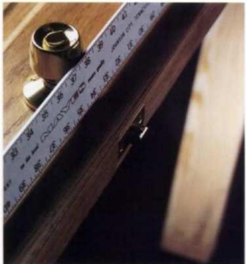
**Una puerta combada** por humedad o penetración de agua origina problemas con las cerraduras. Usar una regla recta para descubrir combadura. Ver la página siguiente para enderezar una puerta combada.
