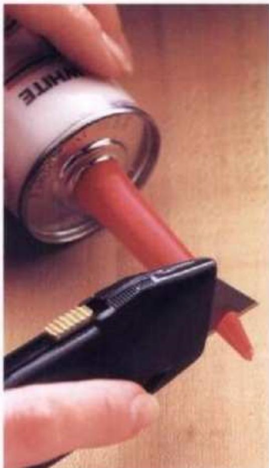
**1** Corte la punta del tubo de calafateo al tamaño deseado del reborde. Algunos tubos de calafateo tienen guías cortadoras en la punta.
