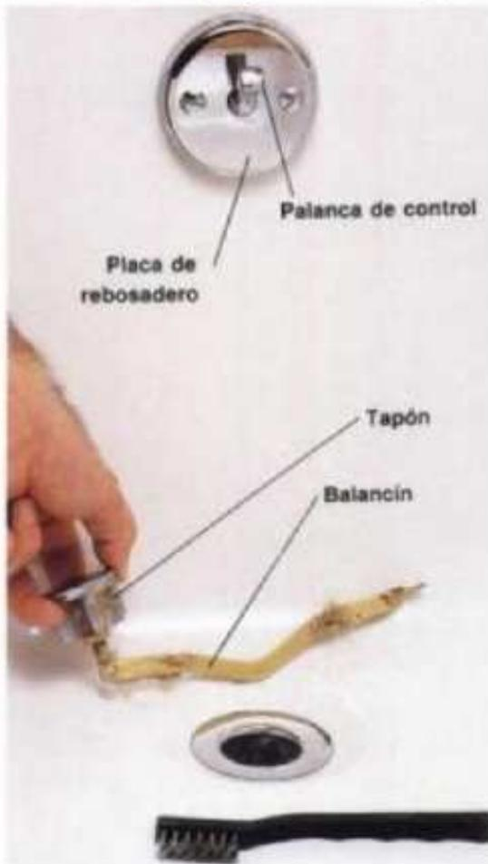
**1** Girar la palanca de control del tapón retráctil a la posición de abierta. Jalar el tapón hacia arriba y jalar con cuidado el brazo oscilante del desagüe. Limpiar los desechos del tapón. Quitar los tornillos de la tapa de derrame.
