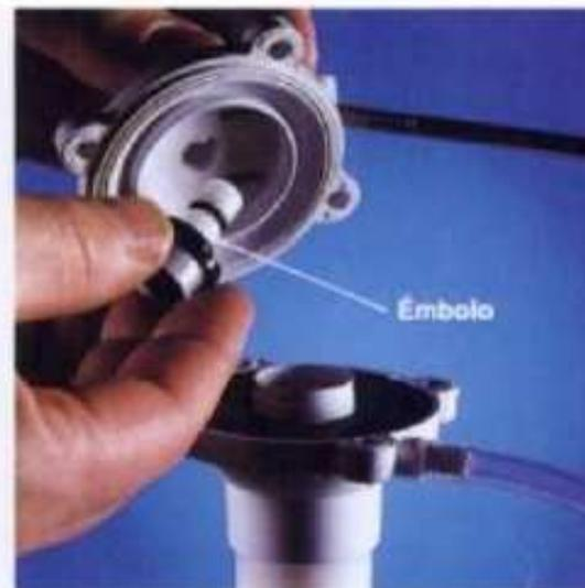
**3** Cambiar las piezas rígidas o rajadas. Si el mecanismo está demasiado desgastado, cambiar toda la válvula de admisión.
