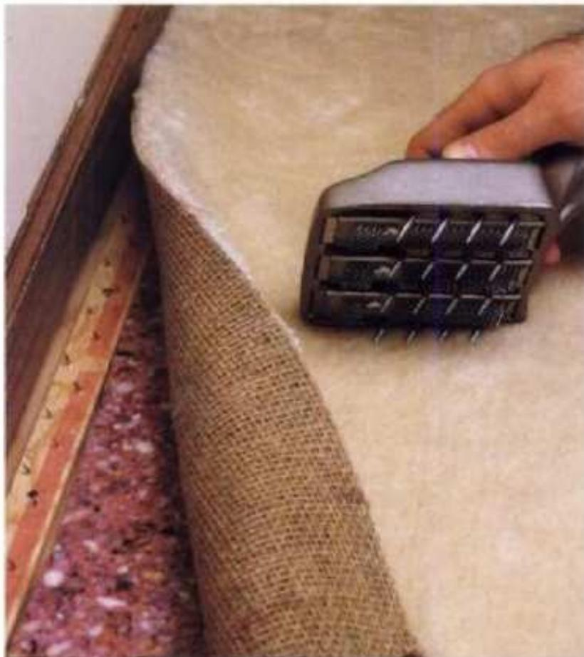
**1** Ajuste el cabezal del restirador para que las púas traspasen la alfombra. Empuje el cabezal del restirador hacia la pared como a 2 pulgadas de la orilla de la alfombra.
