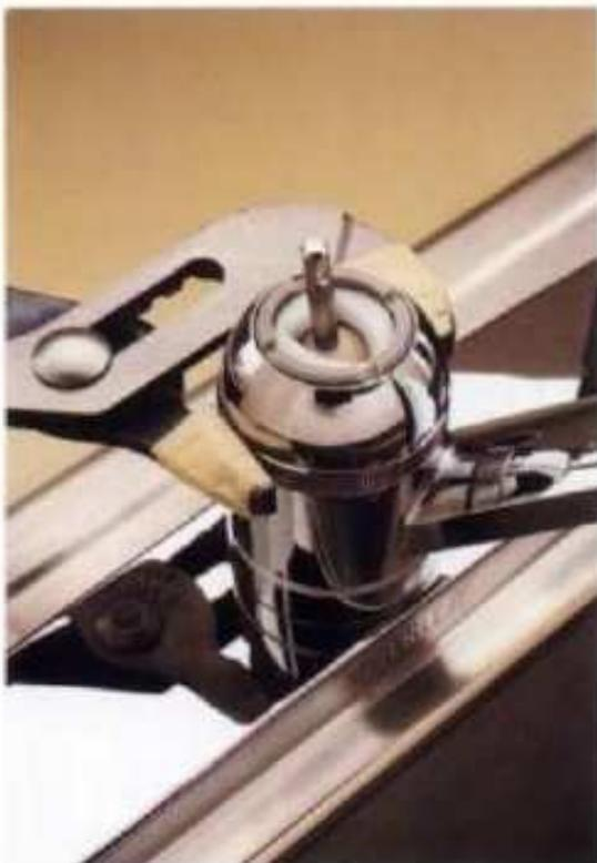
**No rayar el cromo,** revestir las mordazas de las pinzas o la llave con cinta de recubrir, para hacer la reparación. En los grifos de dos llaves reparar un lado en cada vez, y no confundir los vástagos para el agua caliente y el agua fría.
