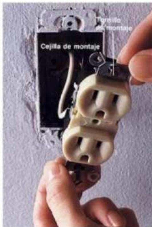
**2** Afloje los tornillos de montaje y sujete las aletas metálicas de montaje para sacar con cuidado el enchufe de la caja. Con unos marbetes pequeños hechos de cinta para recubrir se marca dónde se conecta cada alambre en el contacto.
