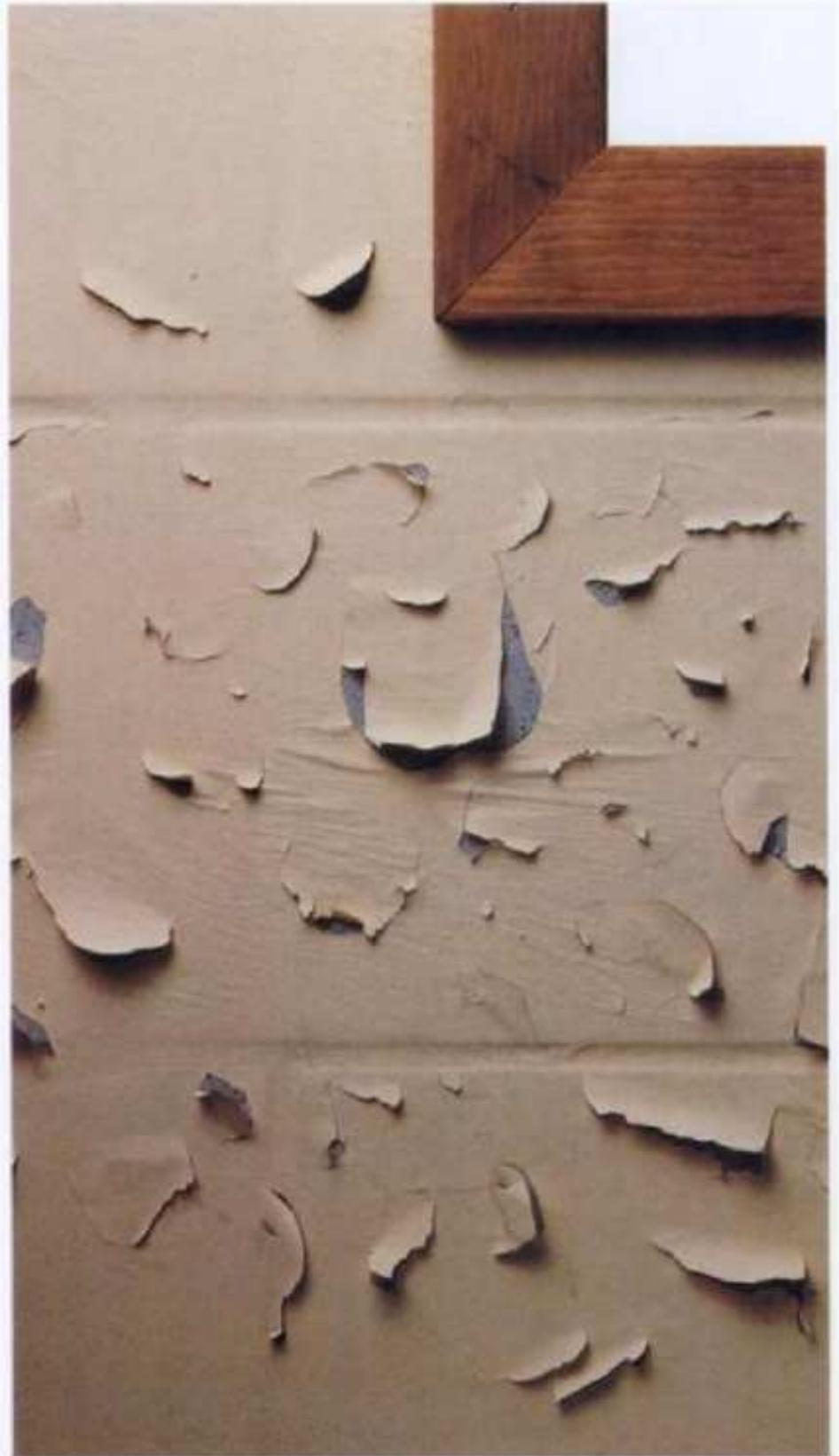
**La pintura desprendida** en las paredes de sótanos se debe a que éstas tienen humedad. Esto por lo general se origina por el agua que se filtra del exterior. Para corregir la falla, se necesita reparar los canales de descenso y los canalones (páginas 112, 114) y revisar el grado de inclinación del terreno alrededor de la cimentación (página 113).
