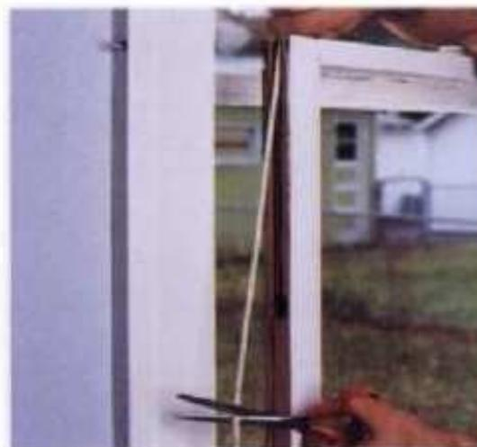
**8** Apoye la ventana inferior sobre el umbral. Sujete fuertemente el cordón contra el lado de la ventana, y corte un tramo suficiente para que quede 3 pulgadas más allá del agujero en el marco lateral de la ventana.
