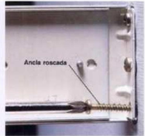
**4** Atornille el ancla de tornillo Grip-It® dentro del ancla de torsión o del yeso taladrado; instale los soportes metálicos cortineros y cuelgue las cortinas.
