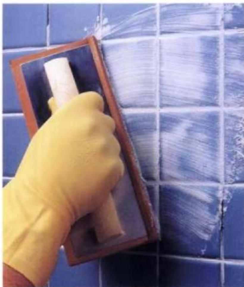
**3** Use una llana de hule espuma o una esponja para extender la lechada por toda la superficie. Aplique bien la lechada dentro de las juntas. Espere a que se solidifique ligeramente y quede firme; después elimine el sobrante con un trapo húmedo.
