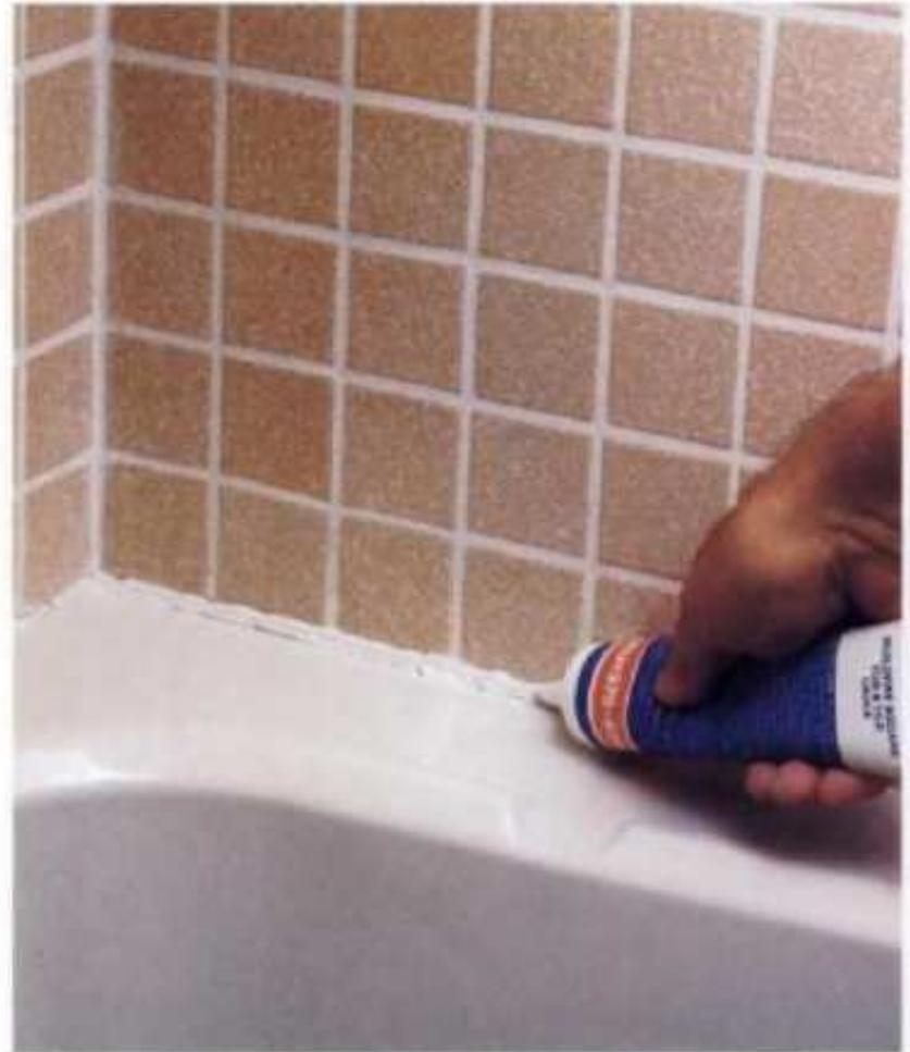
**2** Llène la bañera para que tenga el peso suficiente y se desplace hacia abajo de la línea de azulejos. Calafatee la junta con silicio o de látex de buena calidad para que no se vuelva quebradizo.
