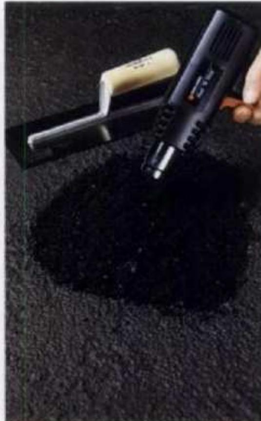
**2** Vierta el asfalto hacia adentro del agujero. El material se calienta con una pistola térmica; se empareja y alisa con una llana metálica.
