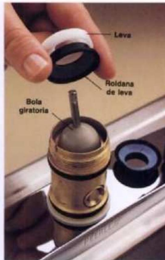
**3** Desenroscar la tapa con pinzas ajustables. (Cubrir las mordazas de las pinzas con cinta de plástico o con tela gruesa para no rayar la superficie de la tapa.) Alzar la leva, la roldana de leva y la bola giratoria.
