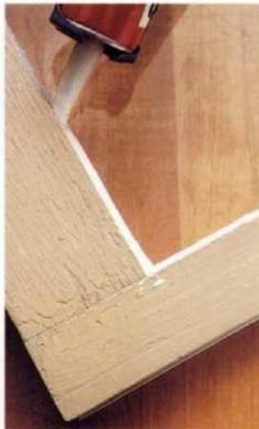
**5** Aplique compuesto de vidriar. La punta del tubo se pasa a lo largo del borde del vidrio al mismo tiempo que se oprime uniformemente el gatillo. Alise el mástique con el dedo o con un trapo húmedo.
