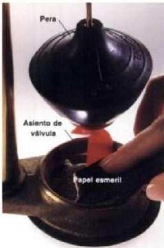
**1** Cerrar totalmente el suministro de agua (página 14) y baldear para vaciar el depósito. Alzar la bola del depósito o desenganchar la chapaleta. Restregar suavemente en el interior del asiento de válvula y esmerilar con papel de lija.
