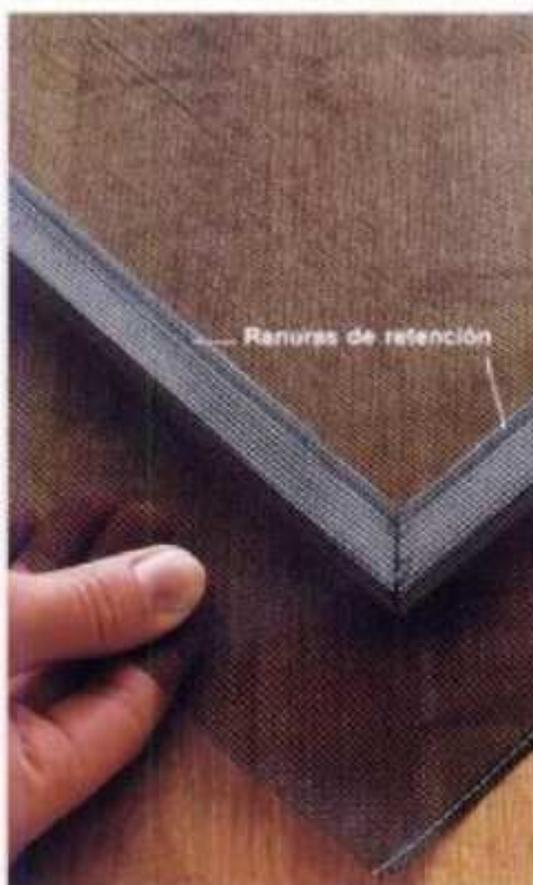
**2** Restire firmemente la nueva tela mosquitera por arriba del marco para recubrir las ranuras de retención.
