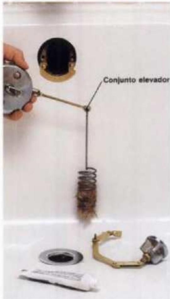
**2** Quitar del tubo de derrame la tapa y el conjunto elevador. Limpiar los desechos del conjunto elevador con cepillo duro. Quitar la corrosión con solución disolvente de cal o vinagre. Lubricar todas las partes con grasa a prueba de calor.
