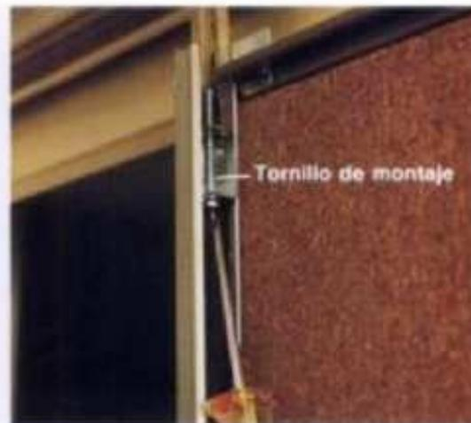
**3** Examine el hueco a lo largo del borde interior de la puerta para verificar que esté parejo. Para nivelar esta abertura, se gira el tornillo de montaje para alzar o bajar el borde.
