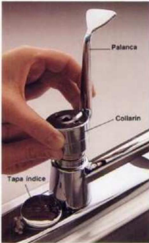
**1** Cerrar totalmente el suministro de agua (página 14). Con una palanca se quita la tapa índice que cubre el collarín y se desatornilla el tornillo de la manija de debajo. Alzar la palanca hasta arriba para soltar la palanca interior del borde de la tuerca de retención. Desprender la manija.
