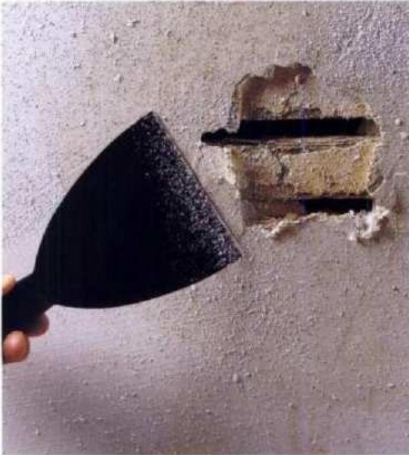
**1** Raspe todo el yeso suelto o desprendido para tener a la vista el yeso base firme o el listón. Verifique que el área dañada no sobrepase el área raspada.
