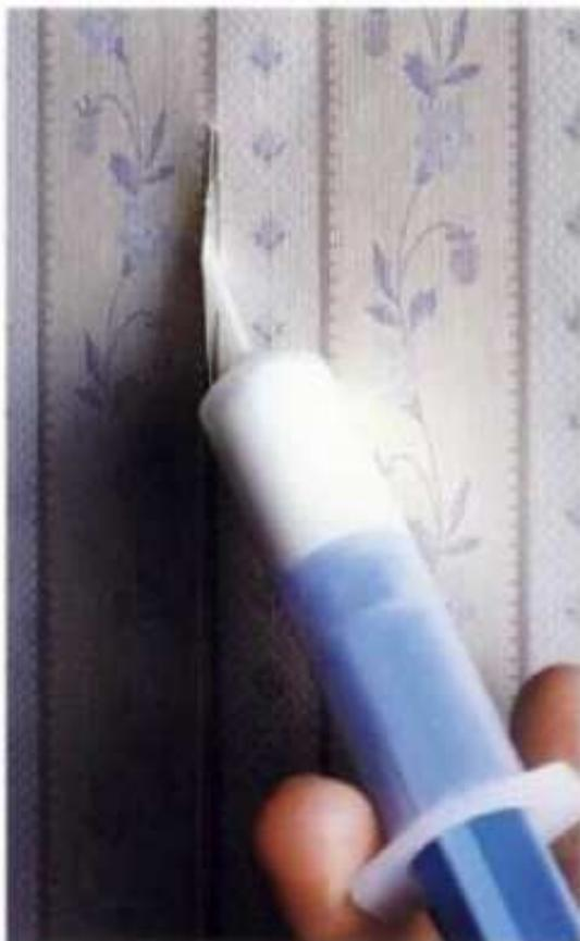
**2** Inserte la punta del aplicador por debajo del tapiz desprendido y aplique un poco de adhesivo en la pared.
