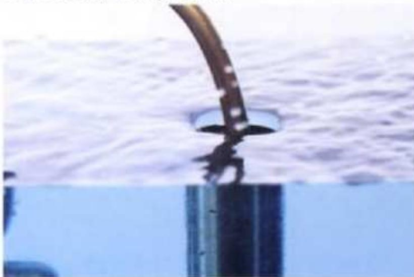
Quitar la tapa del depósito y examinar el interior del inodoro. Si el agua fluye hacia adentro del tubo de derrame, ajustar en ese caso el dispositivo del flotador (página 26). Si la corriente de agua continúa después del ajuste, reparar en ese caso la válvula de admisión (página 27).
