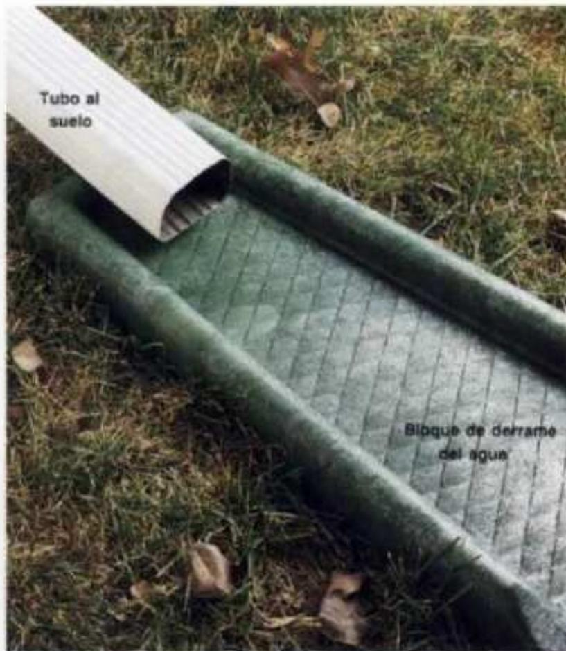
**4** Coloque un bloque de derrame en el extremo del canal para dispersar el agua por el espacio verde.
