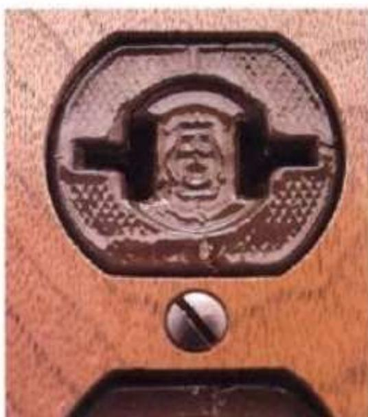
**Los enchufes de 2 ranuras** deben ser cambiados por contactos para clavija de tres puntas; asegúrese antes de que el enchufe se encuentre conectado a tierra (página 39). Si no hay conexión a tierra, llamar a un técnico electricista para que corrija esta deficiencia en la caja de salida.
