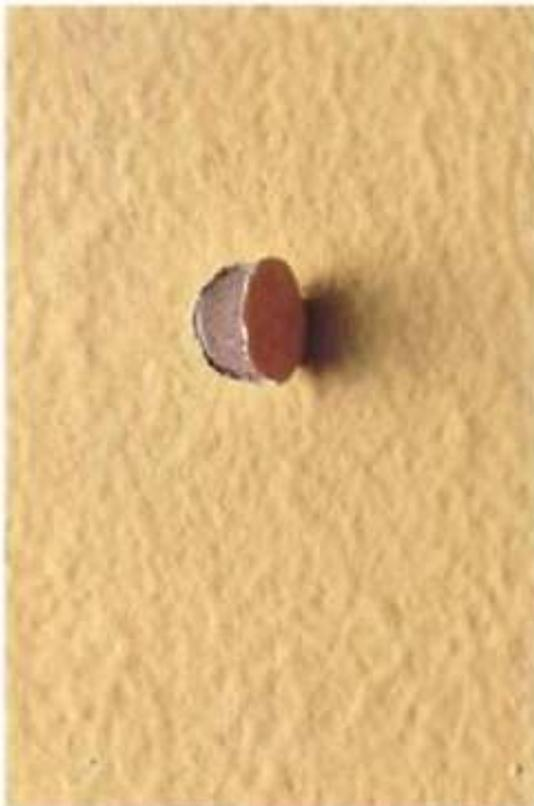
**Los clavos puestos en las paredes secas** se aflojan y se zafan si no están bien clavados o si la madera del bastidor no está seca. Utilice tornillos para hacer estas reparaciones; los vástagos roscados no se botan.
