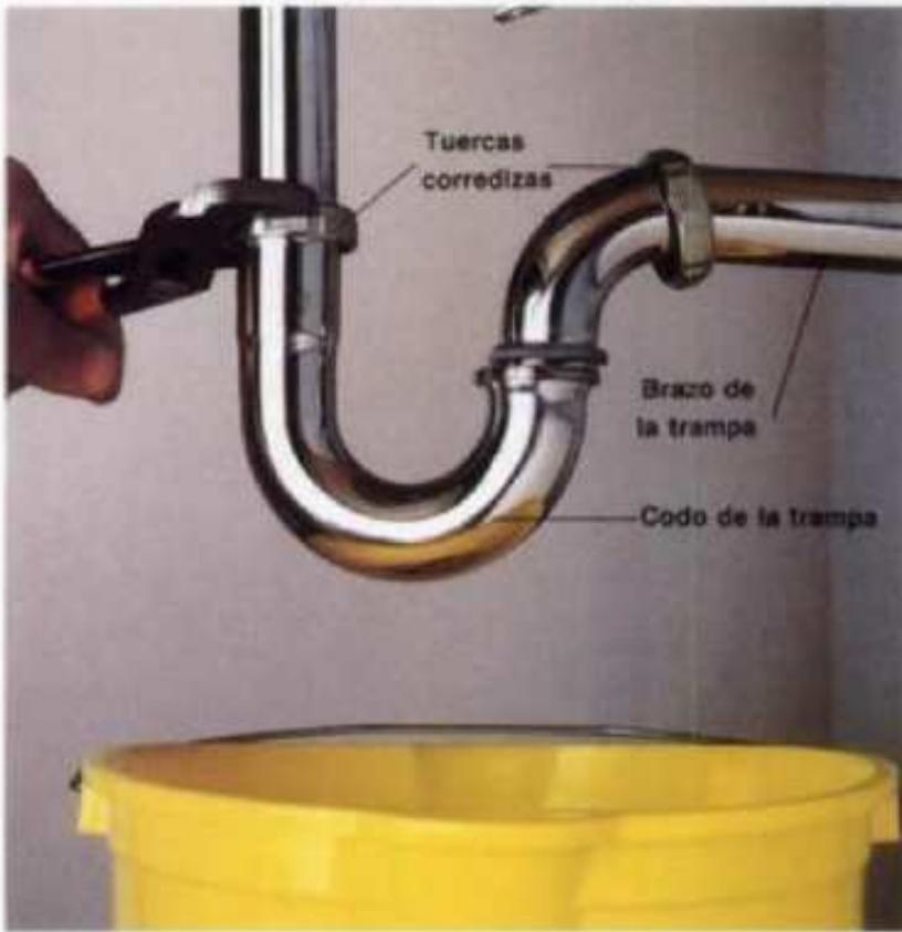
**1** Colocar la cubeta debajo de la trampa para recoger el agua y los desperdicios. Usar guantes de hule si se ha aplicado limpiador químico para desagües. Aflojar las tuercas corredizas del acodamiento de la trampa con pinzas ajustables; después quitar las tuercas a mano y apartarlas de las conexiones. Separar el acodamiento de la trampa.
