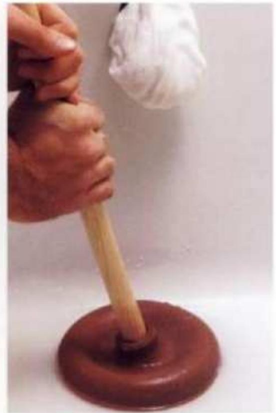
**En bañeras** con palanca de disparo o tapones retráctiles de desagües, quitar los tornillos de la tapa de derrame y jalar cuidadosamente el mecanismo elevador para sacarlo de la abertura de derrame. Quitar el tapón del mecanismo retráctil. Tapar la abertura de derrame con trapo mojado antes de bombear el desagüe.
