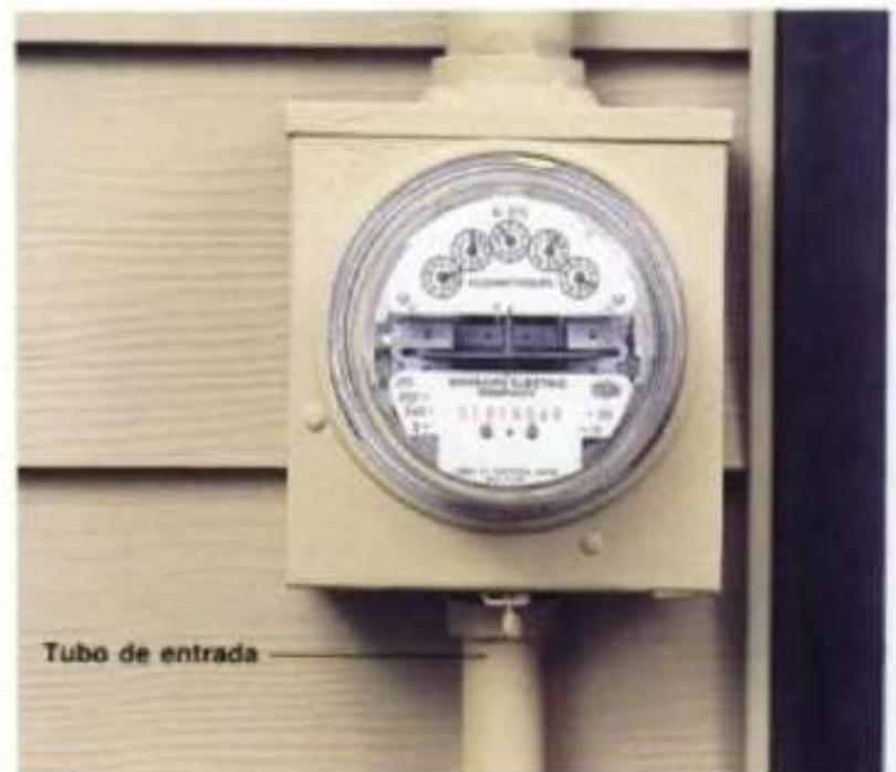
**1** Localice los cables de servicio en el exterior de la casa. Estos cables pasan por el medidor eléctrico, que por lo general está sobre la pared. Cerca del medidor, un tubo metálico conocido como entrada de servicio lleva el tendido de los cables por la pared y hacia adentro de la casa. Se localiza el tablero principal de servicio si se sigue la dirección que lleva el tubo de entrada de servicio por la pared y hacia el sótano o el cuarto de uso general.
