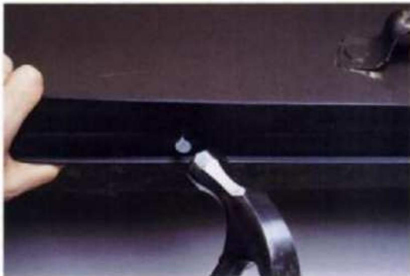
**2** Corte el nuevo gualdrín a la medida de la puerta. Clave la tira a la parte inferior de la puerta. Utilice clavos galvanizados resistentes a la corrosión.
