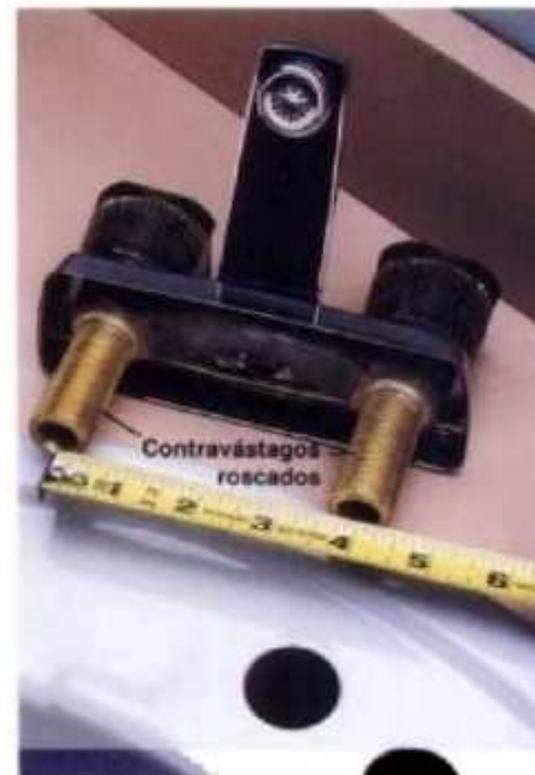
**Cambiar el grifo** si continúa con fuga. Los accesorios de repuesto se adquieren con instrucciones detalladas, pero será necesario conocer las medidas para hacer una compra acertada. Anotar la medida de centro a centro entre los dos extremos inferiores de los vástagos roscados, o llevar consigo el grifo usado al momento de comprar la refacción.
