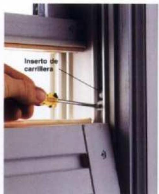
**Ajustar el tornillo** que se encuentra sobre el inserto de la carrillera. Girar el tornillo hasta nivelar correctamente la ventana.
