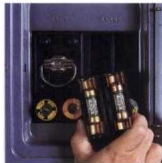
**Los fusibles de cartucho** protegen los circuitos de aparatos eléctricos mayores. Use solamente una mano para abrir el tablero y manejar los fusibles. Si el fusible está montado en bloque, se jala de la manija. Los fusibles montados en sujetadores tipo grapa se quitan con el extractor de fusibles.
