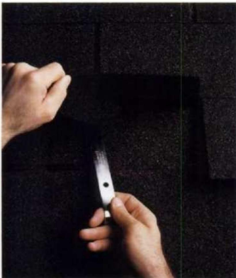
**1** Alce el borde de la teja dañada. Con una palanca delgada se quitan los clavos que sujetan la teja. Quite la teja dañada.
