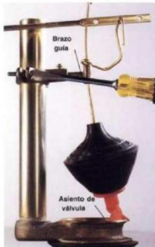
**2** Alinear la bola del depósito. Aflojar los tornillos que sujetan el brazo guía y poner el brazo directamente por arriba del asiento de válvula. Cambiar la chapaleta o la bola del depósito si están blandas o rajadas.
