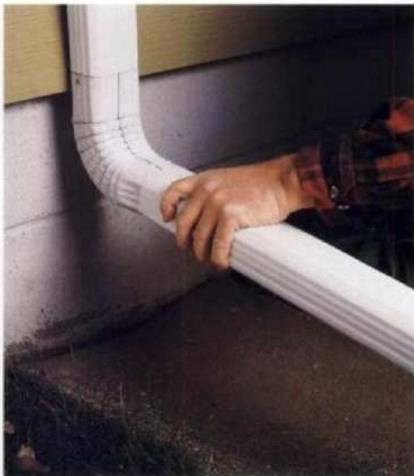
**3** Conecte al canal de descenso la sección cortada con un codado galvanizado.
