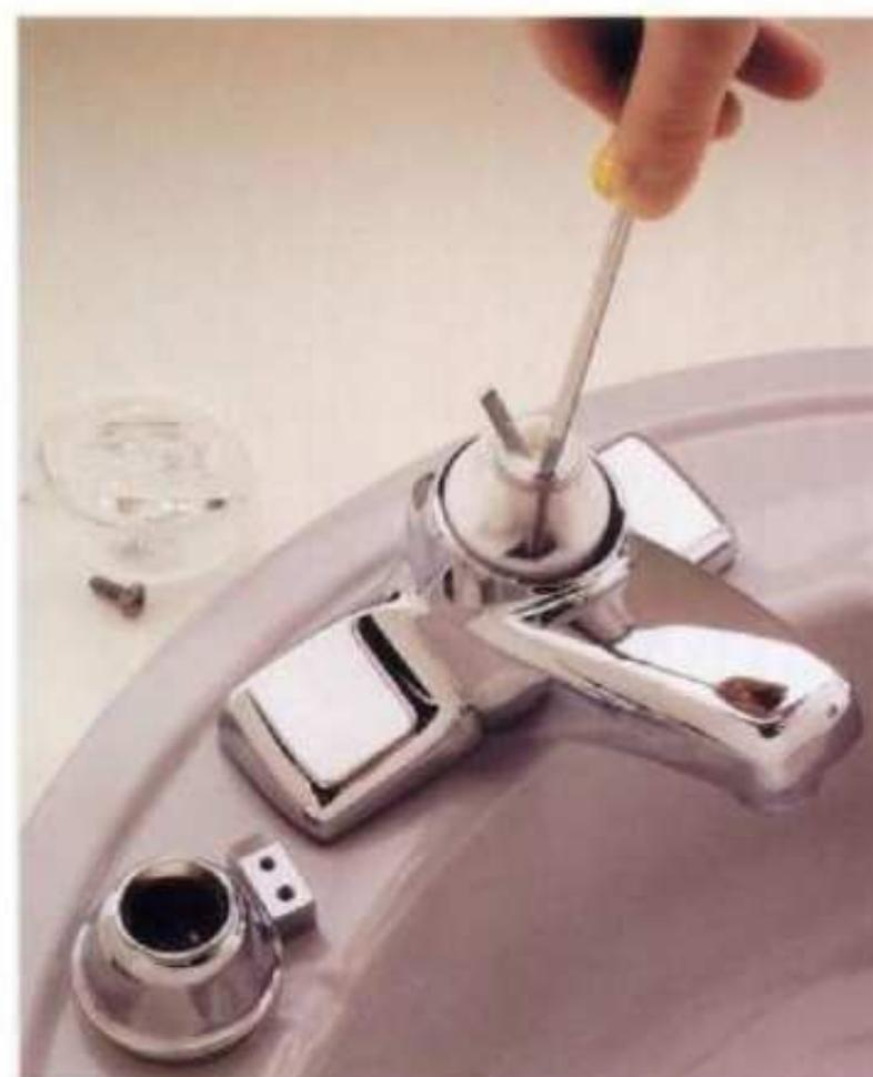
**4** Introducir el nuevo cartucho dentro del cuerpo del grifo y cambiar los tornillos de montaje. Montar y enroscar de nuevo la tapa cóncava. Colocar nuevamente el inserto de la manija, la manija y la tapa índice.
