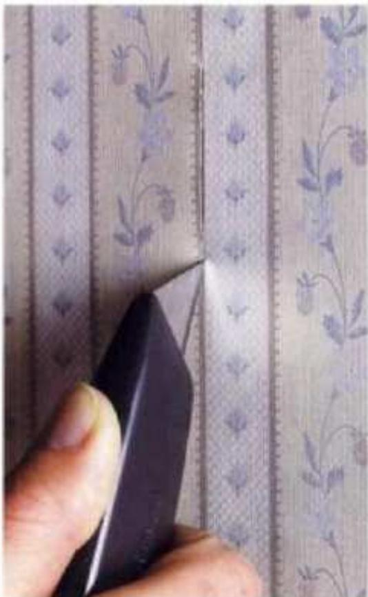
**1** Corte una hendidura en el borde de la parte levantada. Si el tapiz tiene diseño decorativo, corte a lo largo de una línea del dibujo para que el corte quede oculto.
