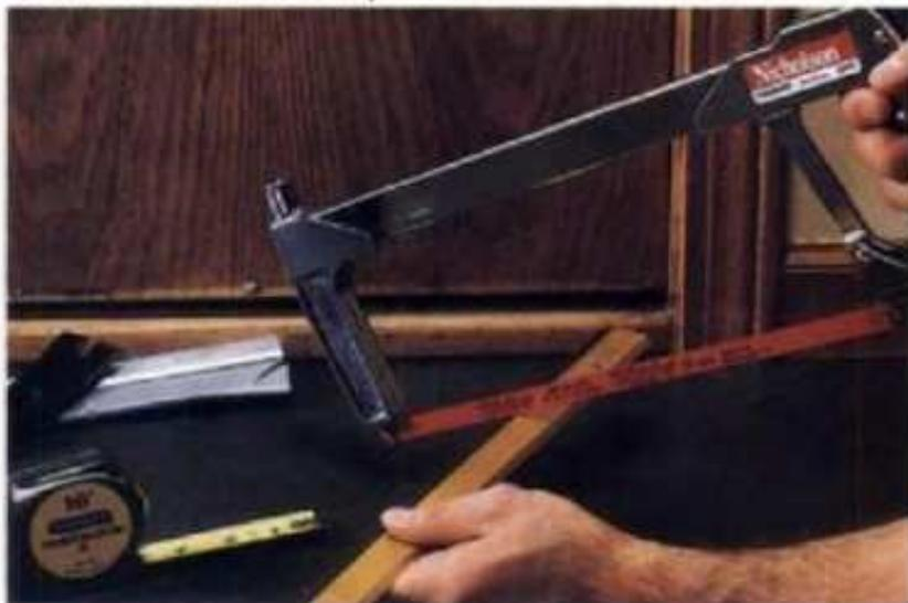
**1** Mida el ancho de la puerta. Corte con segueta una nueva tira de barredora de manera que quede  $\frac{1}{8}$  de pulgada más angosta que el ancho de la puerta.
