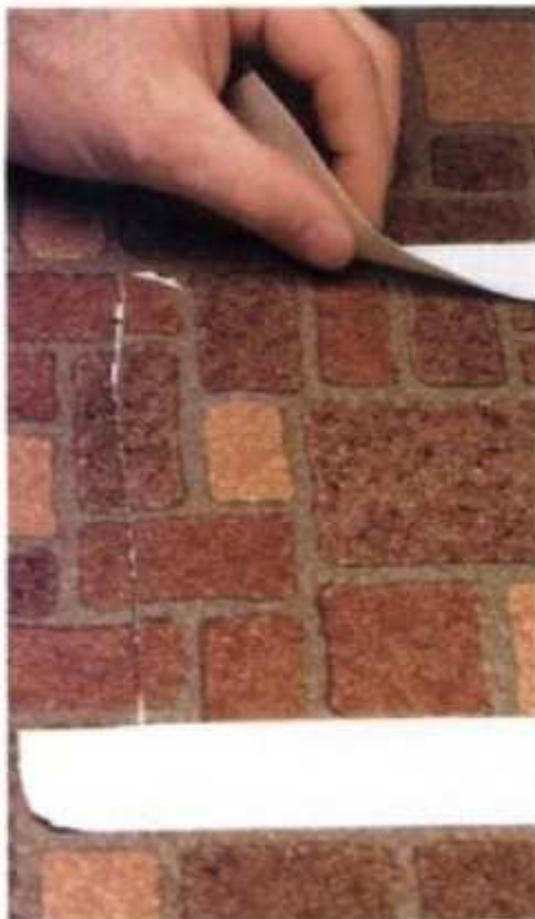
**1** Escoja un pedazo de vinilo igual al del piso en reparación. Coloque el fragmento de desecho sobre al área dañada y ajústelo hasta que el dibujo coincida. Pegue el pedazo de vinilo al piso con cinta adhesiva.
