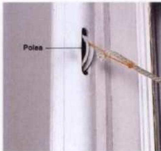
**5** Ate un tramo de cuerda a un clavo pequeño. El otro extremo de la cuerda se ata al cordón nuevo del marco de ventana. Pase el clavo por arriba de la polea y déjelo que caiga hacia adentro de la caja del contrapeso. Recupere el clavo y la cuerda por la caja abierta.
