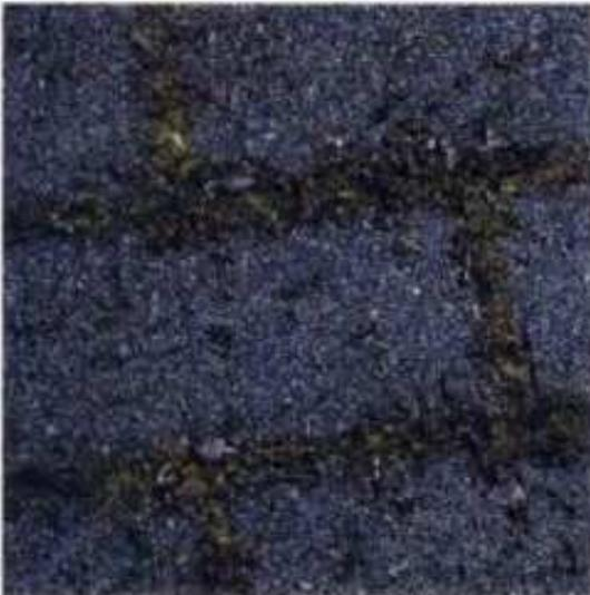
**El musgo o moho** de la cubierta del techo se forma por abundancia de sombra y por las ramas pequeñas y hojas de árboles que obstruyen el drenaje entre las tejas. El musgo o el moho deterioran los materiales del techado.
