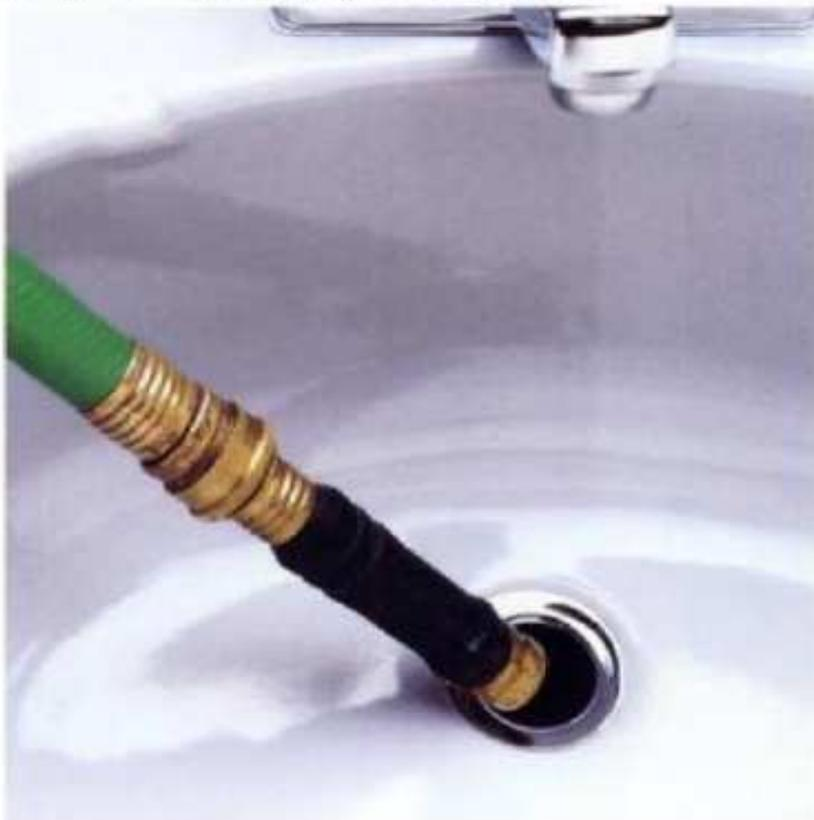
**Una boquilla de expansión** (bolsa de expulsión) es útil en obstrucciones locales pequeñas en desagües de fregaderos con tapones removibles. Fijar la boquilla a la manguera del jardín y conectar la manguera al grifo. Quitar el tapón. Insertar la manguera hacia adentro del desagüe. Cuando la manguera recibe agua al abrirse el grifo, la boquilla se expande para llenar el tubo del desagüe y luego lanza el agua en chorros para eliminar las obstrucciones.
