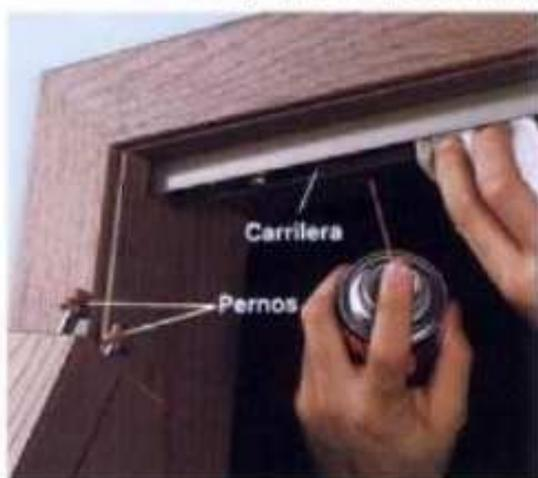
**1** Abra o desmonte las puertas para limpiar las carrileras con un trapo limpio. Aplicar un lubricante sin grasa a la carrilera y los rodillos o pernos.
