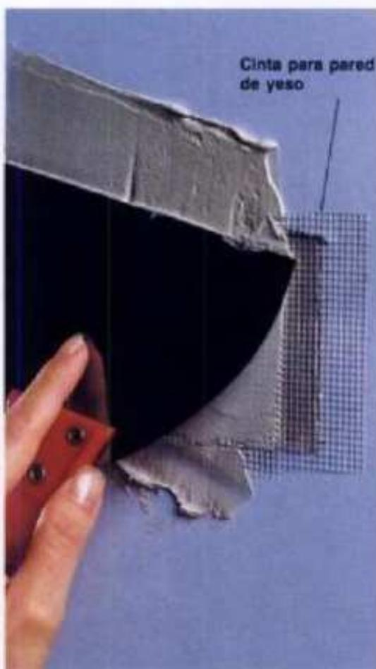
**5** Ponga tela de fibra de vidrio directamente a las costuras. Recubra la tela con un compuesto premezclado para pared de yeso; se aplica con una espátula para este material.
