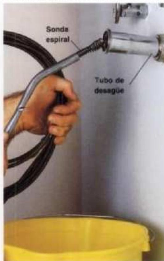
**2** Quitar la tuerca a mano y correrla lejos de la conexión. Quitar el brazo. Introducir el espiral de la barrena para desagües hacia adentro del tubo del desagüe hasta llegar a la obstrucción. Apretar el tornillo de manija para sujetar la manija de la barrena.
