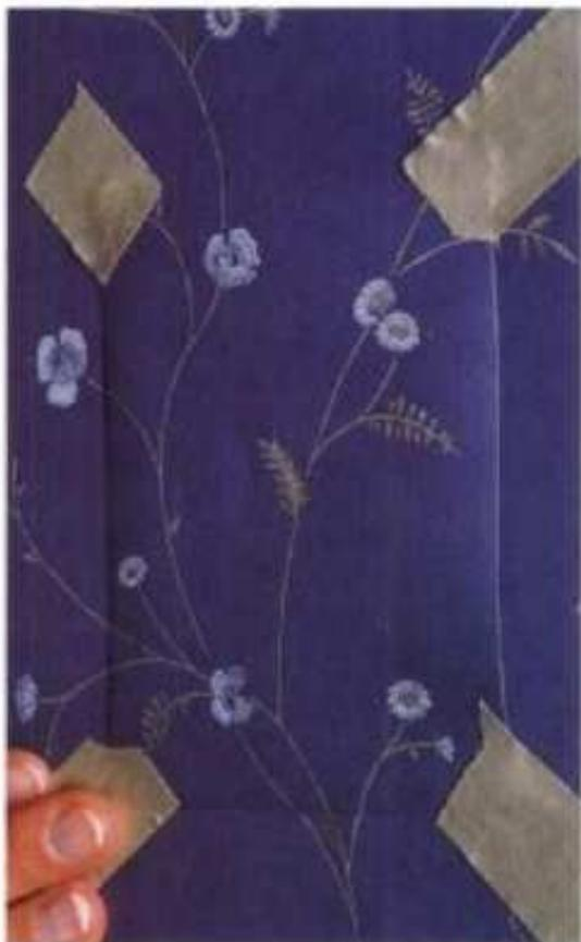
**1** Fije con cinta auto-adherible el pedazo de remiendo por arriba de la parte dañada, para alinear el dibujo con el tapiz que está puesto.
