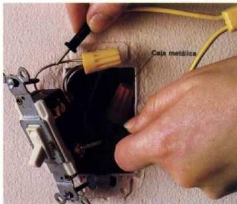
**2** Para probar si hay corriente eléctrica, se pone en contacto una punta del probador de circuitos con la terminal roscada conectada al cable negro. La otra punta se pone en el tornillo para tierra o en el alambre desnudo de cobre, o en contacto con la caja metálica. Repita la prueba con las demás terminales. Si el probador no enciende en ninguno de estos contactos, los alambres se pueden tocar sin peligro alguno.
