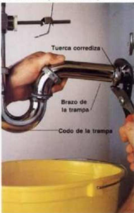
**1** Colocar la cubeta debajo del brazo y acodamiento de la trampa. Quitar el acodamiento (arriba). Usar pinzas de canal o llave para tubos para aflojar la tuerca corrediza que sujeta el brazo de la trampa al tubo de desagüe.
