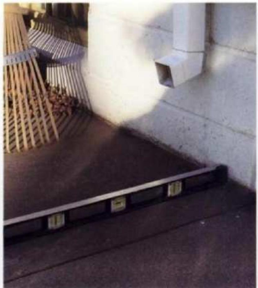
**Las losas de concreto** en las de aceras o patios deben tener declive a partir de la casa. Si la losa está nivelada, o guarda pendiente hacia la cimentación, se recomienda alzarla por el método de inyección de barro. Busque en el directorio telefónico bajo Contratistas de Concreto, para encontrar un contratista que ofrezca este servicio.
