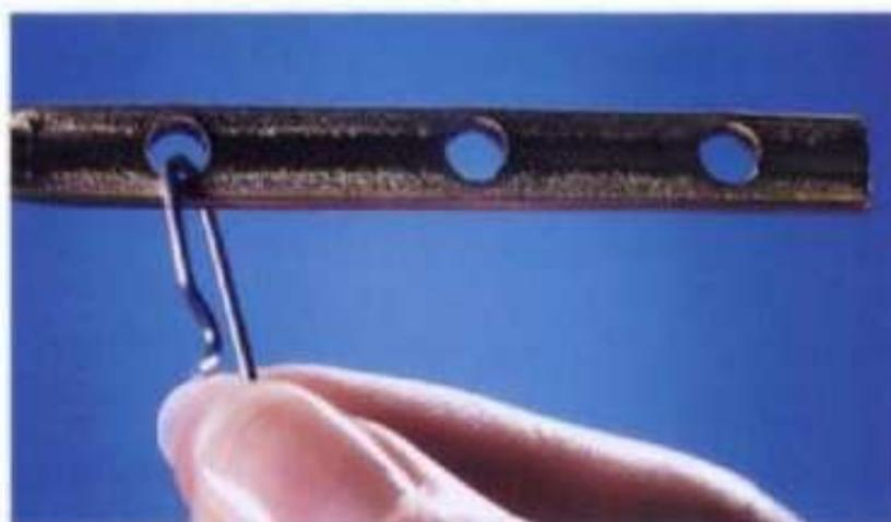
Si el baldeo del inodoro es demasiado lento, enderezar el alambre o la cadena de elevación o correr la cadena a un orificio distinto de la palanca de disparo. Probablemente sea necesaria una cadena más larga. Si el inodoro no baldea de ninguna manera o no funcionara a menos que se mantenga la manija oprimida hacia abajo, enganchar la cadena o el alambre elevadores en uno de los barrenos de la palanca de disparo que se encuentre más próximo a la manija.
