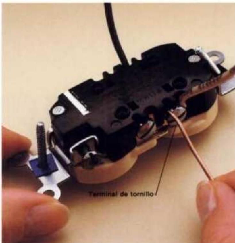
**Para hacer una conexión de terminal con tornillo** se sigue el método de quitar aproximadamente 2 pulgadas del forro. Después se engancha el cable en sentido de manecillas de reloj en la terminal roscada de manera que el forro aislante quede al ras del tornillo. Para lograr una conexión bien formada, se aprieta el tornillo firmemente y se dobla el alambre desnudo hacia adelante y hacia atrás hasta desprender el sobrante.
