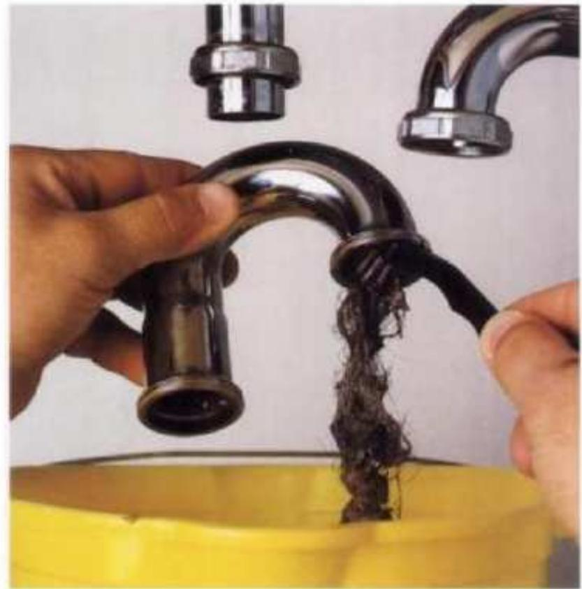
**2** Vaciar los desechos. Restregar con cepillo el interior del acodamiento. Cambiar el acodamiento si hay corrosión (página siguiente.) Ensamblar de nuevo la trampa; apretar las tuercas con llave de canal, pero no apretar demasiado. Probar el desagüe con agua. Si hay fuga en el desagüe, apretar las tuercas con otro cuarto de vuelta.
