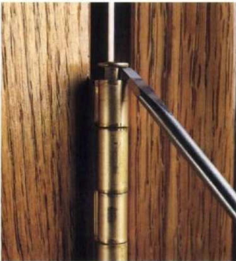
**1** Saque el perno de la bisagra inferior con desarmador y martillo. Con la ayuda de otra persona sostenga la puerta en su lugar. Saque el perno de la bisagra superior.
