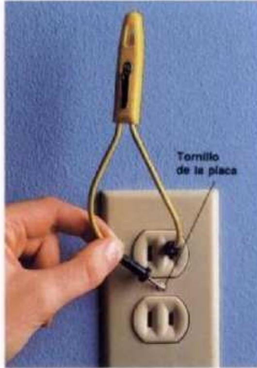
**Pruebe si hay conexión a tierra** mediante la inserción de una punta del probador neón de circuitos en una de las dos ranuras. Con la otra punta se toca el tornillo metálico de la tapa protectora. Repetir la prueba en la otra ranura. Si el probador se enciende, la caja de salida está conectada a tierra, y puede instalarse un nuevo enchufe para tres espigas (página 46).
