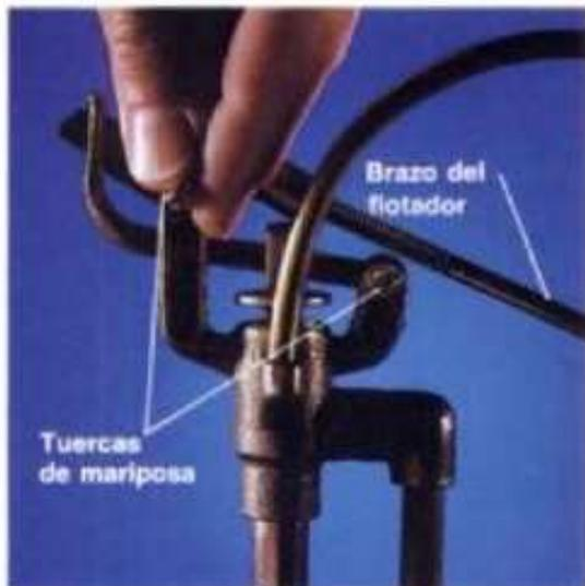
**1** Cerrar totalmente el suministro de agua (página 14) y baldear para vaciar el depósito. Quitar las tuercas de mariposa de la válvula de admisión de agua. Sacar el brazo del flotador.
