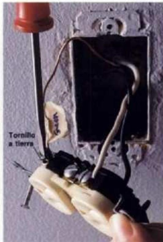
**5** Conecte el alambre desnudo de cobre o el cable aislado de color verde a la terminal roscada para tierra. Si la caja está provista de dos alambres para tierra, se conecta el cable verde al tornillo para tierra y después se conecta el cable flexible a ambos alambres mediante un conector roscado de torsión.
