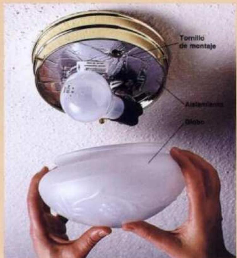
**6** Verifique todo el aislamiento del nuevo accesorio para ver que se encuentre en orden. Doble con cuidado los alambres hacia adentro, después coloque el anillo portafoco al ras con la caja de salida. Ponga los tornillos de montaje y apriételes. Colocar de nuevo el foco y el globo.
