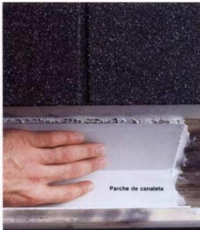
**2** Corte una sección del canalón para cubrir las áreas con herrumbre. Aplique mástique para techos para resanar el área; después, presione firmemente la sección reparada para que se asiente en su lugar.
