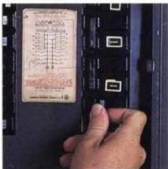
**Los interruptores automáticos de circuito** controlan la carga de corriente en los sistemas modernos. Identifique el interruptor automático que controle los alambres en los cuales se va a trabajar. Oprima el interruptor a la posición de OFF (desconectado). Pruebe los alambres con el probador de circuitos antes de comenzar el trabajo de reparación.
