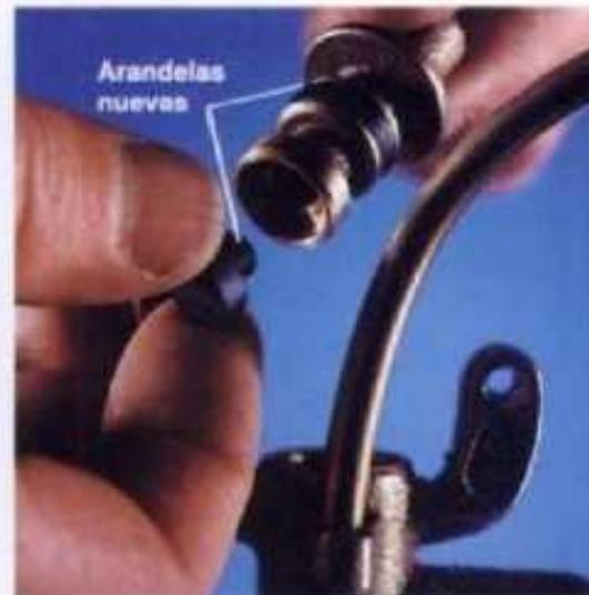
**3** Cambiar las roldanas. Limpiar el sedimento del interior de la válvula de admisión de agua y ensamblar de nuevo.
