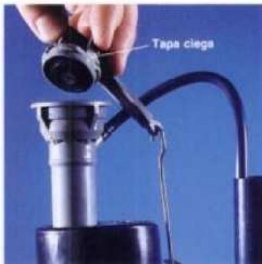
**2** Presionar hacia abajo sobre la caña y girar a la izquierda para quitar la tapa ciega. Examinar dentro de la válvula y limpiar los sedimentos.
