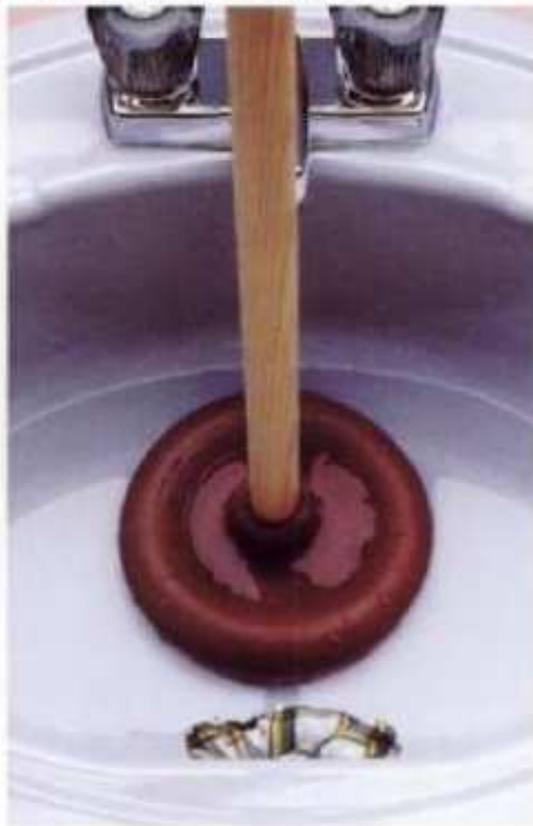
**2** Meter un trapo mojado en la abertura de derrame. Colocar la copa del destapador de émbolo por arriba del desagüe; vaciar suficiente agua para cubrir la copa. Mover varias veces el destapador hacia abajo y hacia arriba para impulsar el agua por el desagüe; manténgase la copa sellada por arriba del desagüe.
