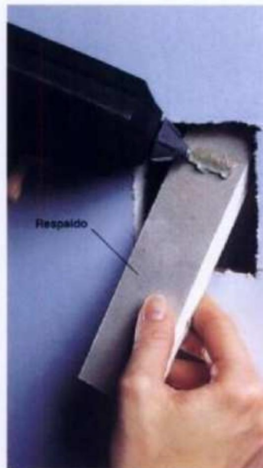
**3** Corte una tira que sirva de respaldo al remiendo. Fije la tira de respaldo dentro de la abertura con pegamento rápido o de aplicación con pistola.
