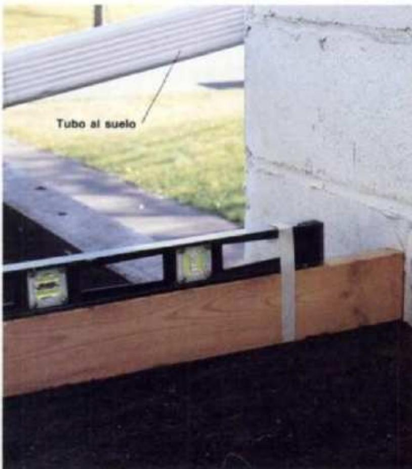
**3** Para obtener una pendiente apropiada, el extremo exterior del tablón debe estar cuando menos a 6 pulgadas por arriba del terreno cuando el tablón está nivelado. Añadir un tramo de canal para descargar el agua a cuando menos a 6 u 8 pies desde la cimentación (página 115). Plante césped hasta la cimentación para ayudar a drenar el agua.
