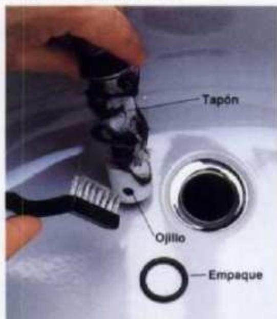
**2** Limpiar los desechos del tapón. Con una palanca quitar cualquier empaque desgastado e instalar su refacción. Regresar el tapón al desagüe. Si el tapón tiene ojillo, asegurarse que quede alineado con la varilla de pivote. Insertar la varilla de pivote abajo del lavamanos y apretar la tuerca de retención.
