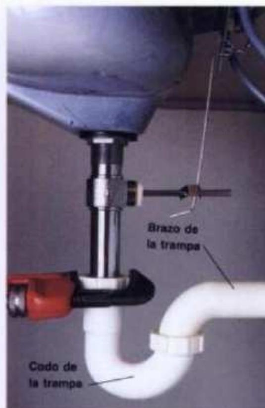
**3** Cambiar la posición del brazo de la trampa en la pared para alinearlos con el extremo corto del acodamiento de la trampa. Apretar todas las tuercas con pinzas ajustables o llave para tubos, pero no apretar demasiado. Probar el desagüe con agua. Si hay fuga en el desagüe, apretar las tuercas corredizas con otro cuarto de vuelta.
