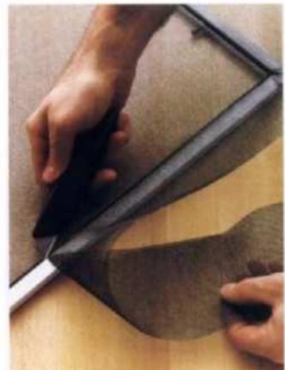
**Consejo para reparar tela metálica mosquitera:** Para facilitar su manejo, la tela metálica se corta más grande que la abertura, y se recorta hasta después de colocar las baguetas.
