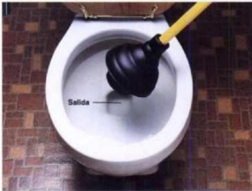
Colocar la copa del destapador manual de émbolo por arriba de la abertura de la salida. (El destapador manual de copa bridada trabaja mejor en inodoros.) Vaciar suficiente agua hacia adentro de la taza para cubrir la copa de caucho. Bombear rápidamente hacia abajo y hacia arriba. Vaciar una cubeta de agua adentro de la taza. Si el agua se pasa, baldear el inodoro varias veces para deslavar los desechos por el desagüe.
