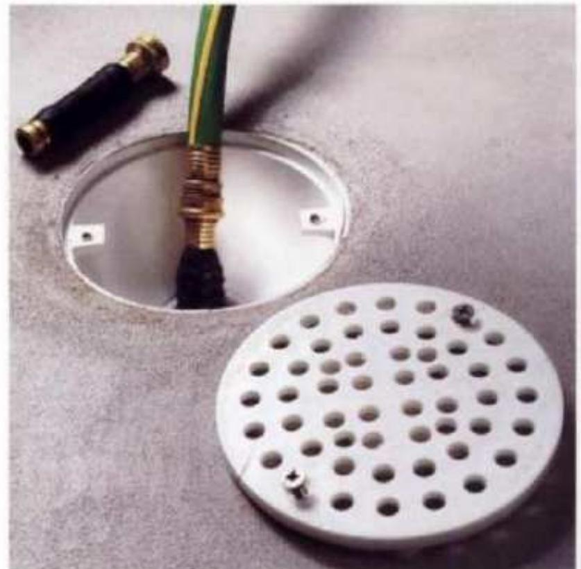
**Un desagüe de piso o de baño de regadera** también se destapa con boquilla de expansión. Después de terminados estos trabajos con la boquilla, cerrar la válvula de paso del agua y esperar que la boquilla se vacíe antes de quitarla.
