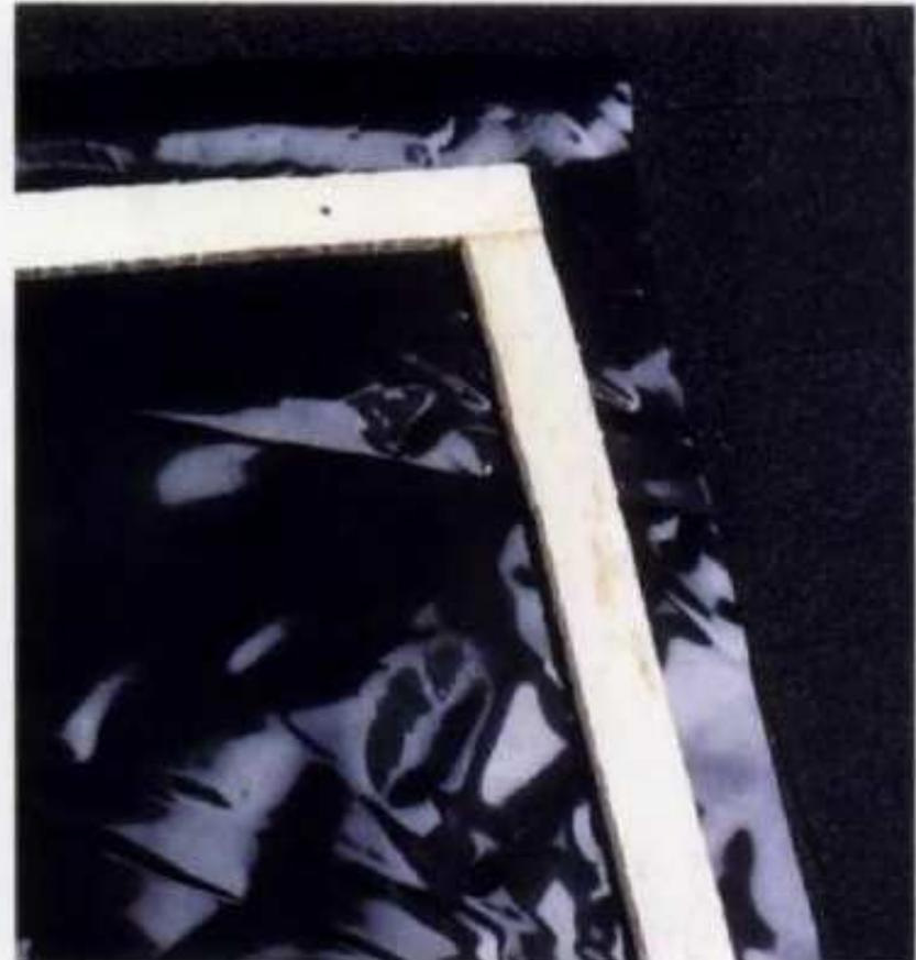
Una cubierta de plástico o una lona impermeable sirven como protección de emergencia en el techo después de una tormenta destructora. Las orillas del plástico se sujetan con tiras de listón clavadas hasta que se pueda reparar el techo. Los agujeros se resanan con mástique después de quitar los clavos.
