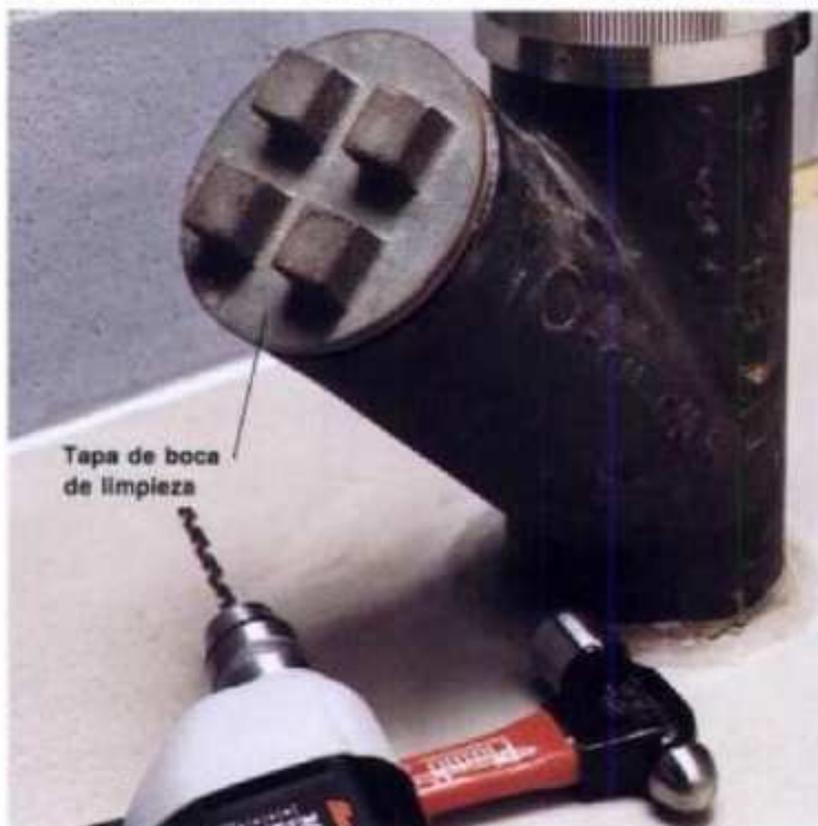
**1** Desenroscar el tapón principal de limpieza con una llave para tubos. Cuando el tapón está corroído, taladrar agujeros en el tapón y romperlo en fragmentos con el martillo de bola. Instalar un nuevo tapón después de limpiar el desagüe.
