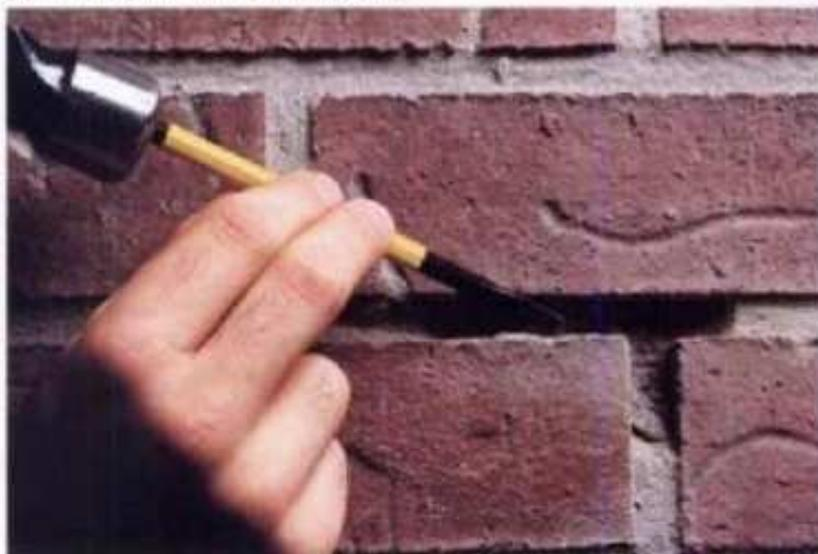
**1** Desmenuce el mortero suelto con un cincel de albañil y un martillo de bola. Las aberturas se limpian con un cepillo metálico o con una aspiradora portátil.
