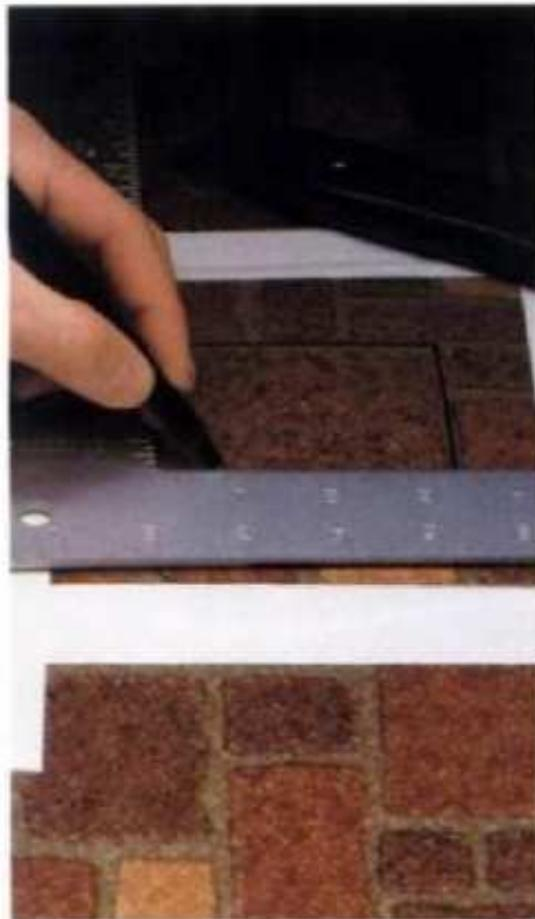
**2** Utilice una escuadra de carpintero para delinear la reparación. Trace a lo largo de las líneas del dibujo para ocultar las uniones. Con una cuchilla corte las dos capas de vinilo. El vinilo dañado se desprende con una espátula.
