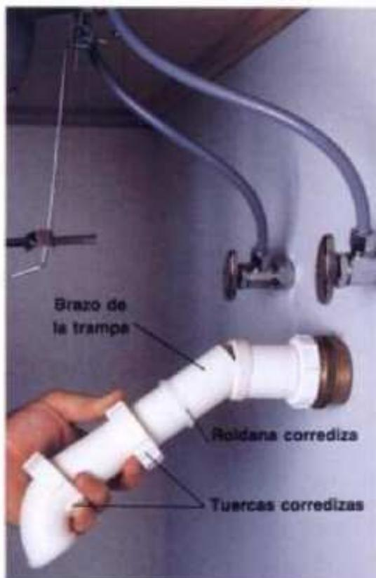
**1** Deslizar los accesorios por sobre el brazo en el siguiente orden: tuerca corrediza (la cuerda primero), otra tuerca corrediza (la cuerda al último), y la roldana corrediza (el lado ahusado al último). Empujar el brazo de la trampa aproximadamente 1 1/2 pulgadas hacia adentro del tubo del desagüe. Deslizar la roldana por sobre la abertura del desagüe y apretar la tuerca corrediza arriba de la misma a mano.
