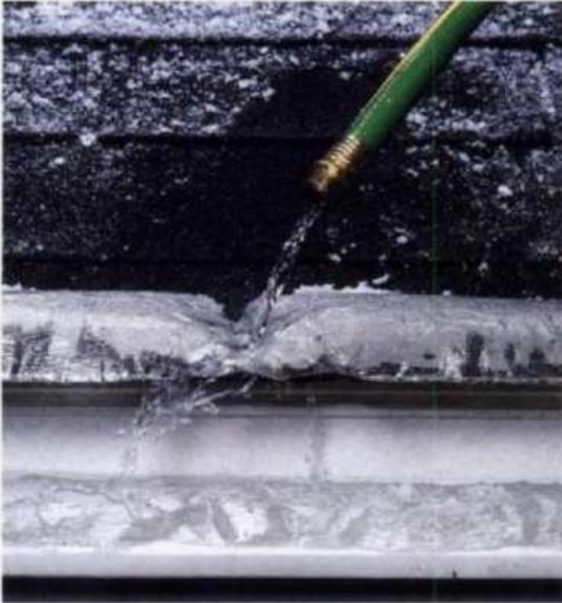
Para evitar mayor acumulación de hielo se abre un canal con agua caliente. Esto permite drenar el agua del techo antes de que se congele. También se puede llamar a un especialista para que deshaga las represas de hielo con un equipo de vapor.
