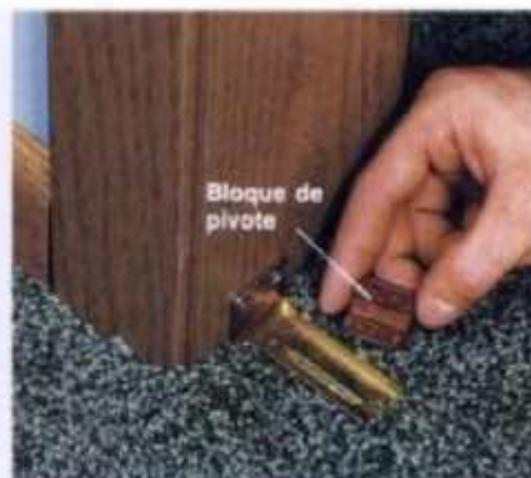
**Los bloques ajustables de pivote** también se localizan en la parte inferior de algunos modelos de puertas. Ajuste el bloque de pivote hasta que la separación entre la puerta y el marco sea pareja.
