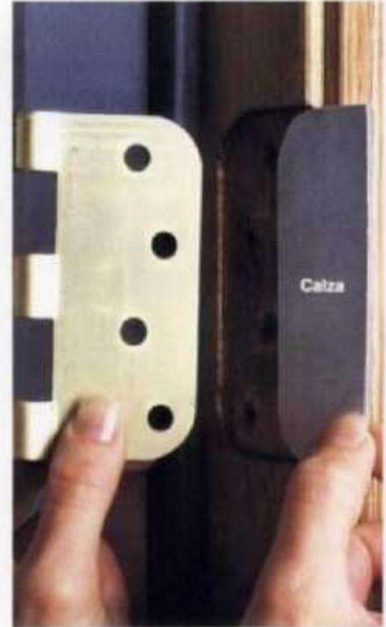
**3** Eleve la posición del pestillo por medio de una calza delgada de cartón puesta detrás de la bisagra inferior. Para bajar el pestillo, calce por detrás la bisagra superior.
