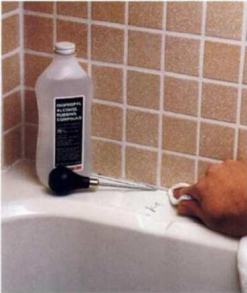
**1** Raspe y elimine la vieja lechada de cemento o el calafateo viejo con una lezna o con un abrelatas. La capa jabonosa de la junta se quita con alcohol y un trapo limpio.
