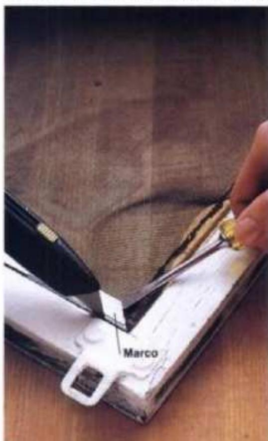
**1** Levante el marco de la tela metálica con un cincel o desarmador. Si el marco está sellado con pintura, use una cuchilla para cortar la película de pintura y soltar el marco.
