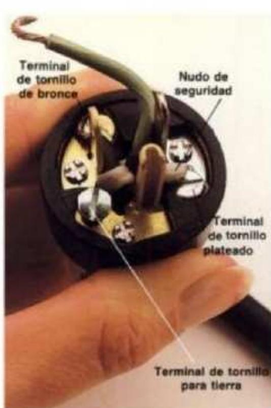
**2** Haga lazo o nudo asegurador en los cables negro y blanco (página 40). Usar pinzas de punta delgada para enganchar la punta de cobre del cable negro en sentido de manecillas de reloj alrededor del tornillo de bronce y la punta del cable blanco alrededor del tornillo plateado. En la clavija de 3 puntas, conectar el tercer alambre al tornillo para tierra.
