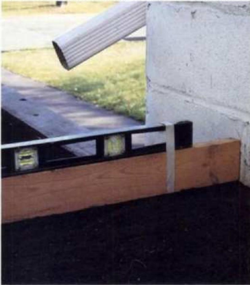
**1** Fije un nivel de carpintero con cinta de pegar a un tablón recto de 2 x 4 y 8 pies de longitud y verifique el grado de inclinación del terreno alrededor de la cimentación de la casa. Si el terreno alrededor de la cimentación no tiene pendiente, el agua estancada puede filtrarse hacia adentro del sótano.
