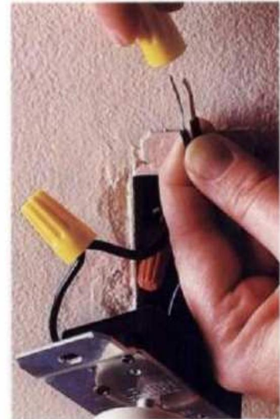
**El interruptor con reductor de luz se instala según el mismo procedimiento. Debe tener el mismo número de alambres o terminales que el interruptor viejo. En el caso que tenga tres terminales, el alambre rojo del reductor se conecta al alambre negro del circuito. Si el reductor tiene alambre verde para tierra, debe conectarse al alambre para tierra del circuito o a la caja metálica de salida.**
