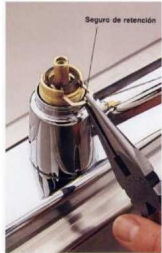
**3** Con una palanca se levanta el seguro de retención de la parte superior del cartucho y se quita con unas pinzas de punta.
