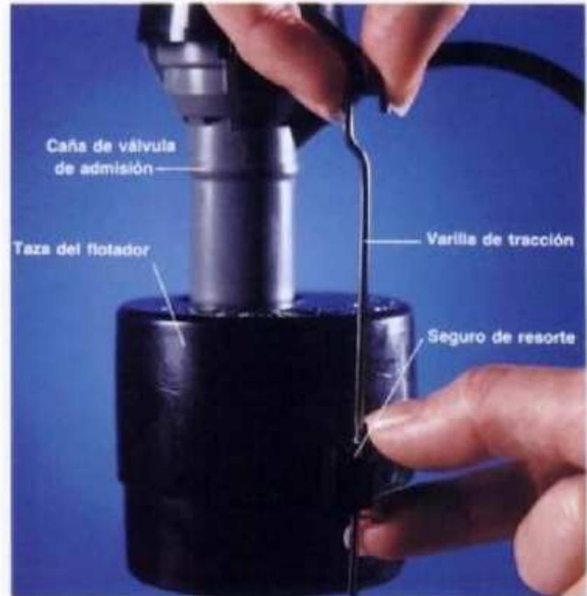
**Inodoros con flotadores de copa.** Apretar con los dedos el seguro de resorte fijado a la varilla de tracción y ajustar la posición de la copa sobre la caña de la válvula de admisión de agua. Ajustar la copa hacia abajo para bajar el nivel del agua del depósito.
