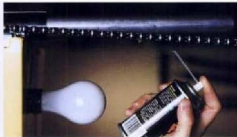
**2** Limpie y lubrique la cadena impulsora y la carrilera de la puerta automática. Lea las instrucciones del fabricante sobre las indicaciones adicionales de mantenimiento.
