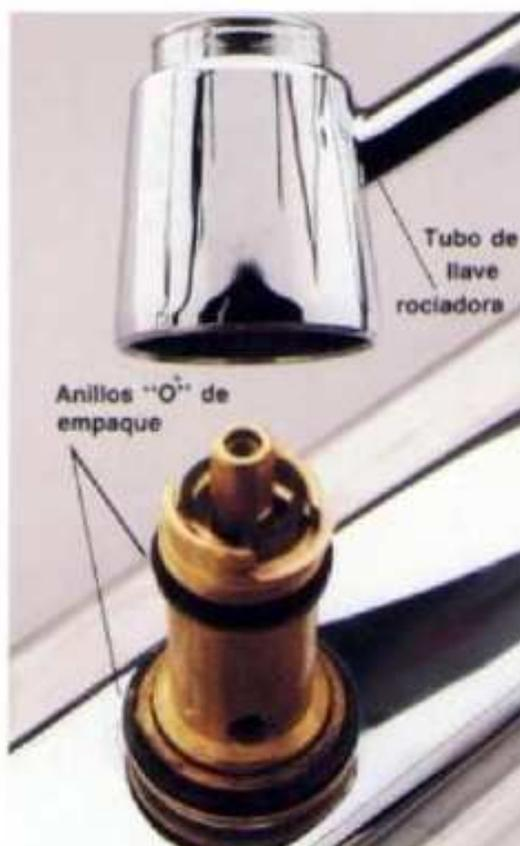
**5** Quitar el grifo con un movimiento vertical y de torsión. Cortar con navaja los anillos "O" usados. Untar grasa a prueba de calor en los nuevos anillos "O" antes de instalarlos. Colocar nuevamente el grifo y la tuerca de retención.
