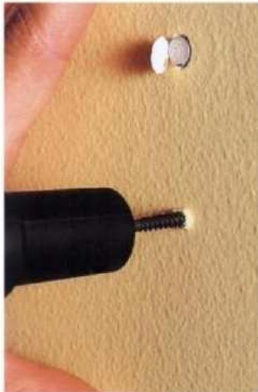
**1** Presione con fuerza la pared seca contra el pie derecho o la viga. Introduzca un tornillo a dos pulgadas aproximadamente del clavo botado. La cabeza del tornillo debe quedar ligeramente en receso.
