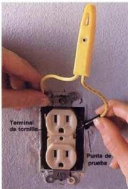
**1** Desconecte la corriente que llega a la caja del contacto en el tablero principal de servicio (página 38). Quite la tapa protectora. Para probar que no hay corriente, se ponen con cuidado las puntas del probador de circuitos en las terminales superiores a los lados del receptáculo. La prueba se repite en los tornillos inferiores. Si el probador no enciende, se pueden tocar los cables sin peligro alguno.
