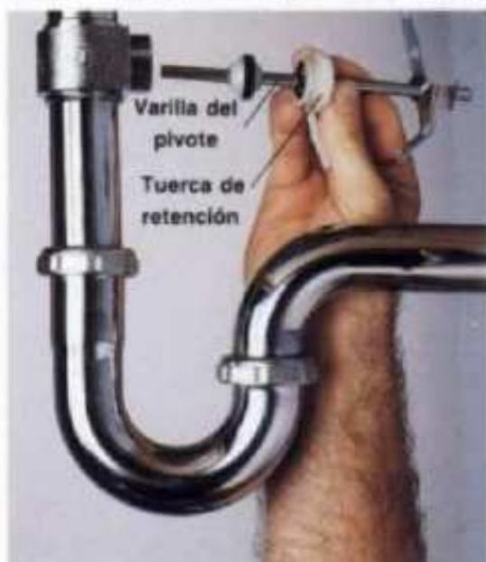
**1** Alzar el tapón a la posición de abierto. Desenroscar la tuerca de retención abajo del lavamanos, después jalar la varilla de pivote hacia afuera del cuerpo del desagüe para soltar el tapón. Quitar el tapón con movimiento giratorio contrario a manecillas de reloj y separarlo.
