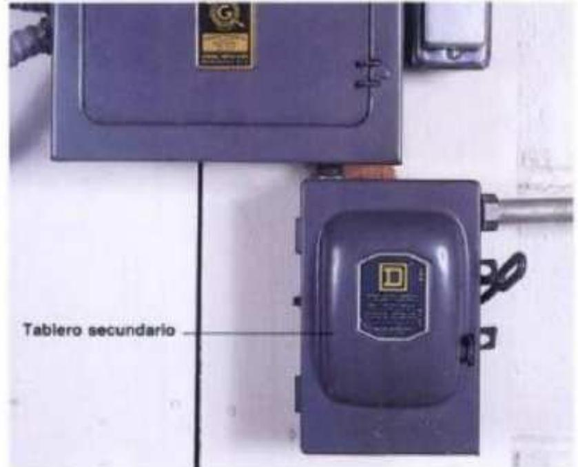
**El tablero secundario** está por lo regular junto al tablero principal de servicio, se alimenta directamente del tablero principal para proporcionar energía a los circuitos de los aparatos eléctricos, a la cochera o a cualquier construcción exterior. Si se desconecta el fusible o interruptor en el tablero principal de servicio se desconecta también la energía en el tablero secundario.
