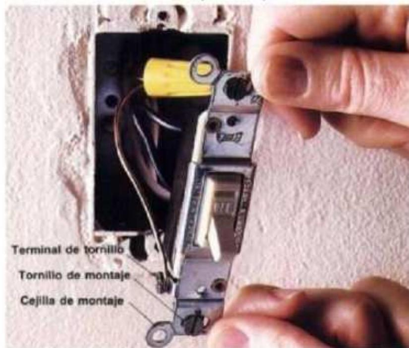
**1** Desconecte la corriente eléctrica hacia el interruptor en el tablero principal (página 38). Quite la tapa protectora. Afloje los tornillos de montaje y sujete las aletas metálicas de montaje para jalar con cuidado el interruptor y sacarlo de la caja. No toque los alambres desnudos ni las terminales roscadas.
