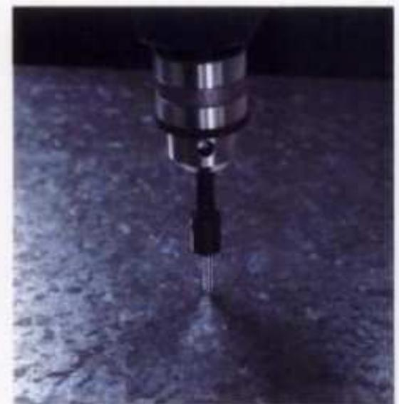
Meter los tornillos autorroscantes para lámina con atornillador eléctrico o con taladro eléctrico provisto de un dado hexagonal.
