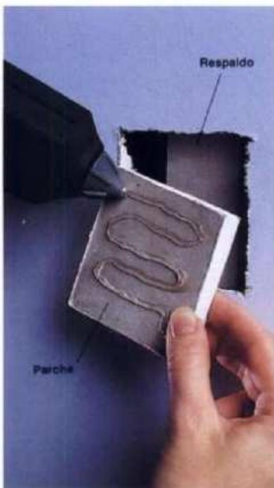
**4** Corte una pieza de pared seca a la medida de la abertura. El remiendo debe ser del mismo espesor de la pared. Aplique pegamento caliente en la parte de atrás del remiendo y presiónelo contra el respaldo hasta que el pegamento se solidifique.
