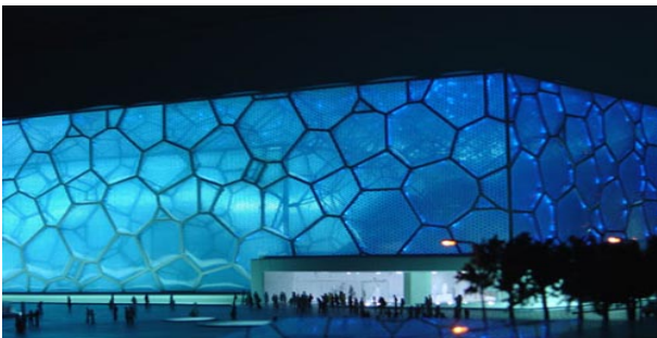
Figura No 74 Estadio "Cubo de Agua"
