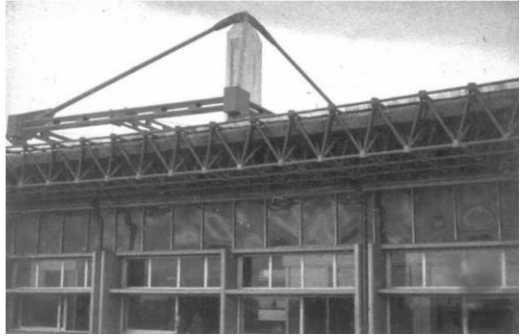
Estación Terminal de Ómnibus, Córdoba.
