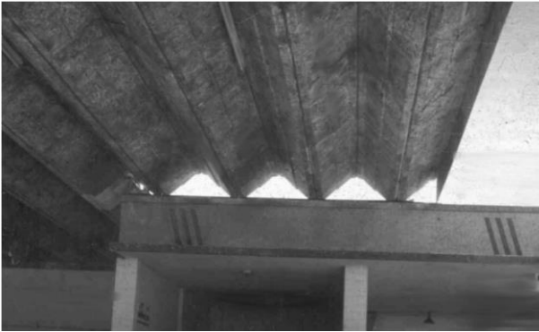
Plegado de cubierta en homigón armado.
