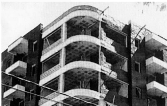
Losa cruzada alivianada con encofrado perdido.
