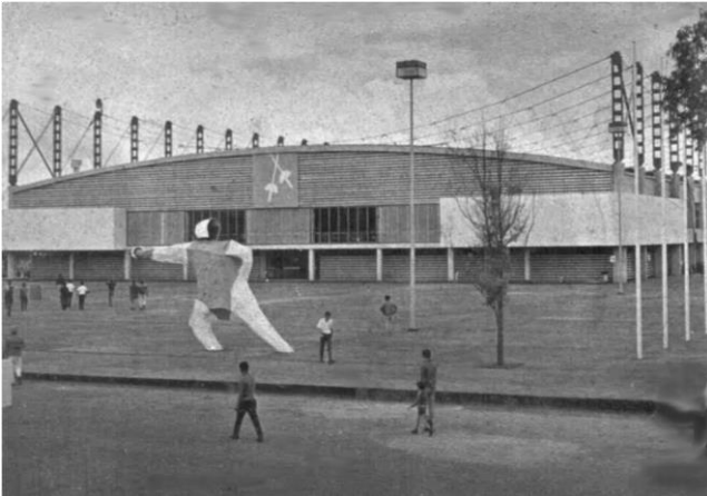
Estadio Olímpico de México. Cercha Jawerth con la cubierta ubicada sobre los cables de estabilización.
