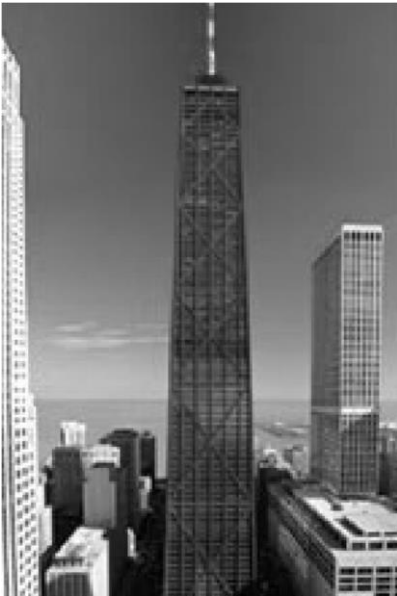
John Hancock Center (Chicago) El reticulado en cruz que abarca varios niveles le da rigidez al conjunto y resiste las cargas horizontales de viento.
