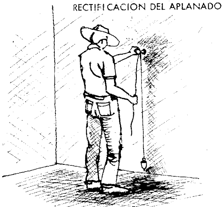
Rectificación del aplanado a plomo.
