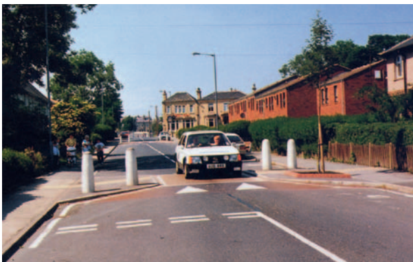
Figura 2.6.2e La efectividad (y seguridad vial) de un lomo trapezoidal mejora si se combina con otras medidas, como el angostamiento a un solo carril, como muestra el ejemplo.
