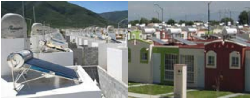
Imagen 1. Imagen 2. Tecnología adosada a las azoteas de las viviendas de interés social en México
