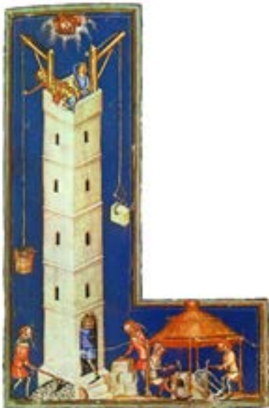
Figura 5. Dibujo alemán de la baja Edad Media (1370 d. C.) que representa la edificación de la Torre de Babel. Maestro de Weltenchronik, Pergamino. Bayerische Staatsbibliothek, Munich.
