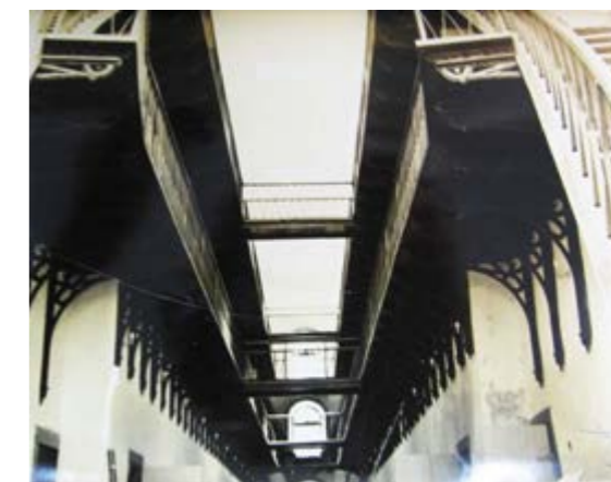
Figura 04 Visão Interna da antiga Casa de Detenção do Recife. Fonte: da autora
