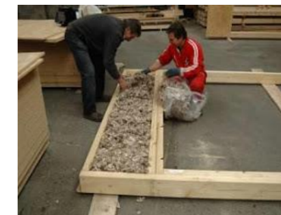
Fig. N° 10 Paneles interiores de la vivienda pasiva
