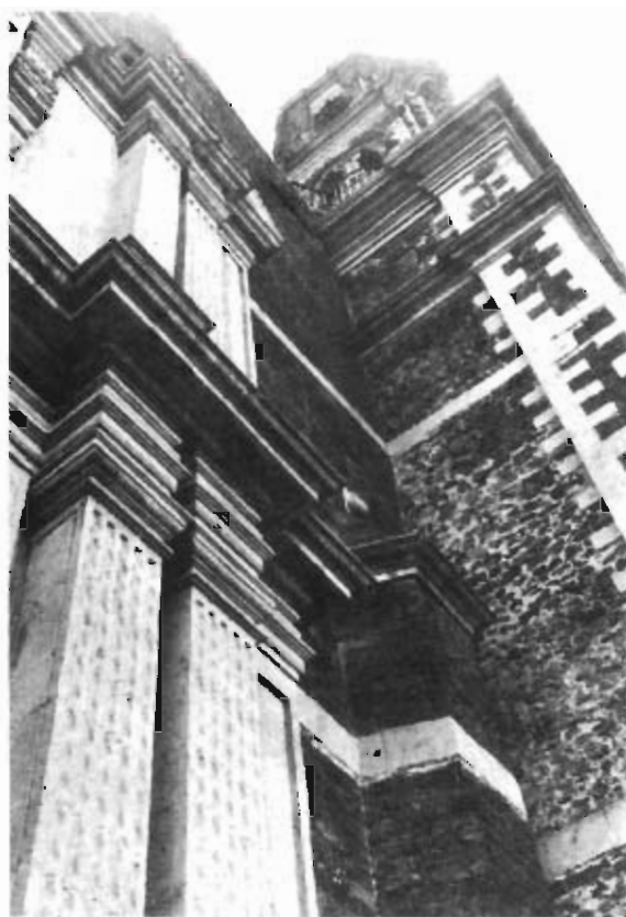
Torre de Santa Catarina que contiene magnífica escalera de Chiluca
