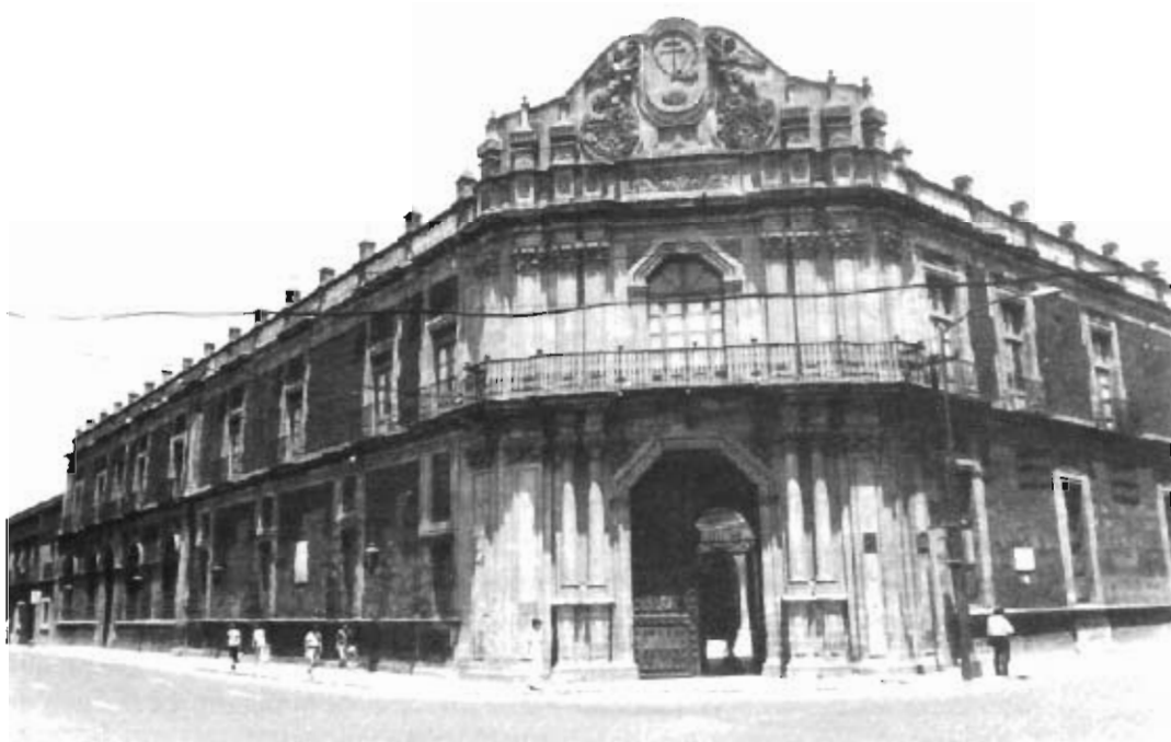
Edificio de la ex-Inquisición ya restaurado
