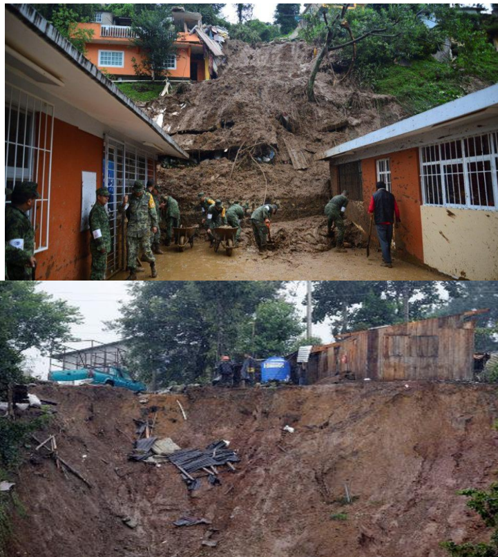
Imágenes 6 y 7. Desplazamiento de talud en Huauchinango, Pue., por las intensas lluvias tras el paso del fenómeno meteorológico Earl (Agosto 2016) fuente: http://www.diariocambio.com.mx/2016/zoon-politikon/item/20091-fotos-y-videos-del-desastre-en-huauchinango#ixzz4aQIHfjsN
