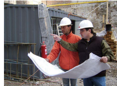
Imagen 15. Supervisión de obra. Obtenido de: http://www.arqhys.com Enero 2017
