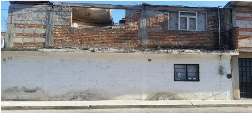
Foto 3. Col. Villa olímpica, Cautlancingo Puebla. (2017). Construcción de vivienda con combinación de materiales, cubierta de láminas en primer nivel, observamos los medidores que los abastecen de energía eléctrica. Fuente: Abigail Torres P. Conjuntos habitacionales:
