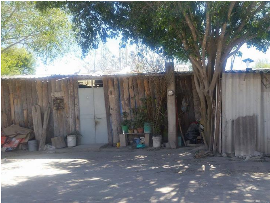
Foto 10. Asunción, Santa María Coapan, Tehuacán. Pue (2017). Vivienda con ocupación provisional, construida con tablas y láminas de asbesto. Fuente: Abigail Torres P.
