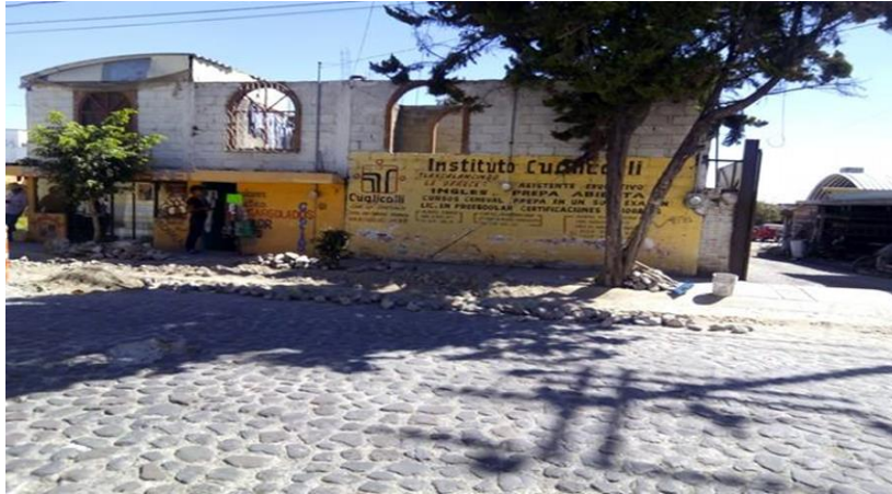
Foto 2. San Bernardino Tlaxcalancingo, san Andrés Cholula. (2017) Vivienda en proceso de expansión, para el albergue de familiares e hijos. Fuente: Abigail Torres P.
