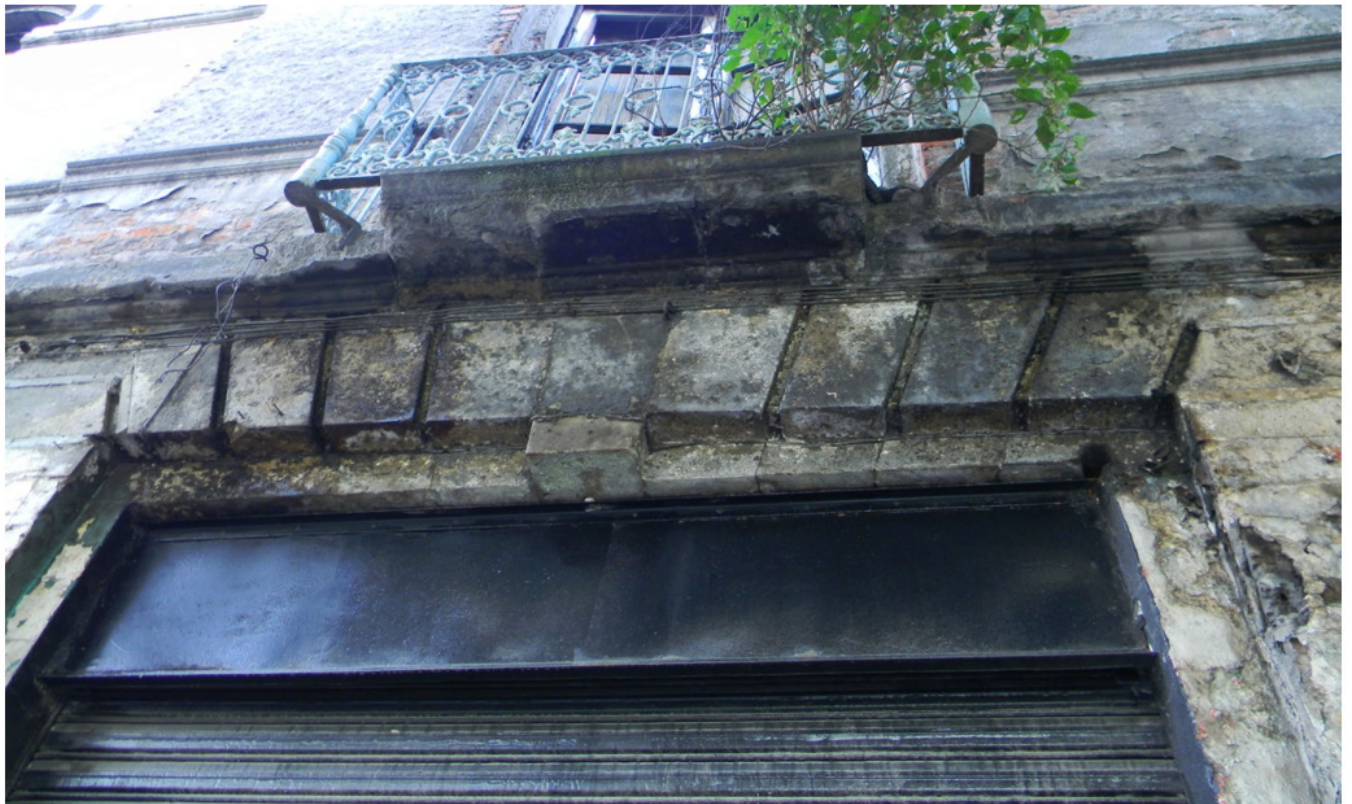
Fig. 12. Detalle de platbanda en módulos de cantera de Chiluca en dintel de vano de acceso. Foto Fdo. Ortiz.
