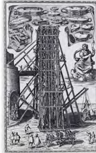
Fig. 1.8.3. Armadura para el traslado del obelisco vaticano (en D. Fontana: Della trasportazione dell'obelisco vaticano, lám. 12, Roma 1590).
