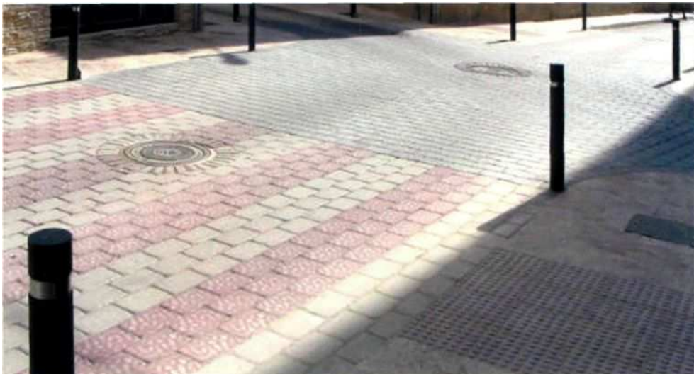
Plataforma única de tráfico mixto (Campo de Criptana, Ciudad Real). Se aprecia la colocación de banda de pavimento contrastado en la zona de tránsito peatonal y a eje con el paso de peatones.
