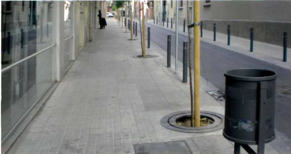
Plataforma única de tráfico mixto (Barcelona). Se ha utilizado pavimento diferenciado entre las bandas de tráfico peatonal y rodado así como para la banda de mobiliario.
