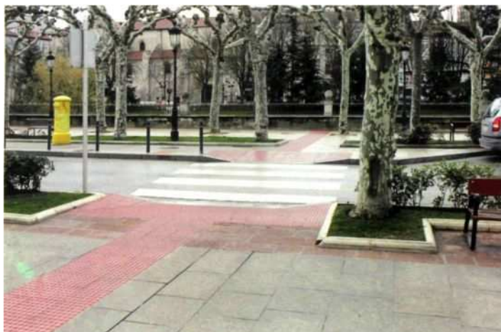
Cruce peatonal con vados de tres rampas en los extremos (Burgos).
