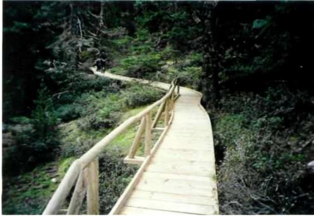
Pasarela de Madera en el Parque Nacional de Aigüestortes i Estany De Sant Maurici (Lérida).
