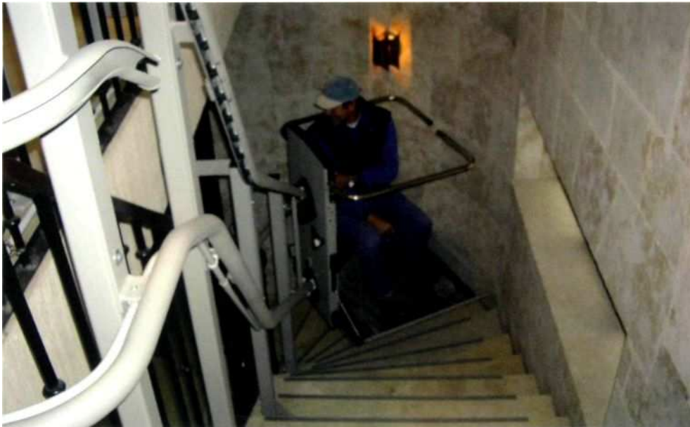
Plataforma salvaescaleras adaptada al desarrollo circular de la escalera, dotada de trasportín para mejorar las prestaciones.
