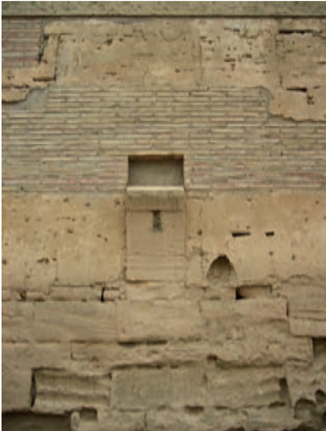
Monasterio de Sijena, detalle de la intervención sobre el muro exterior de la nave norte del claustro
