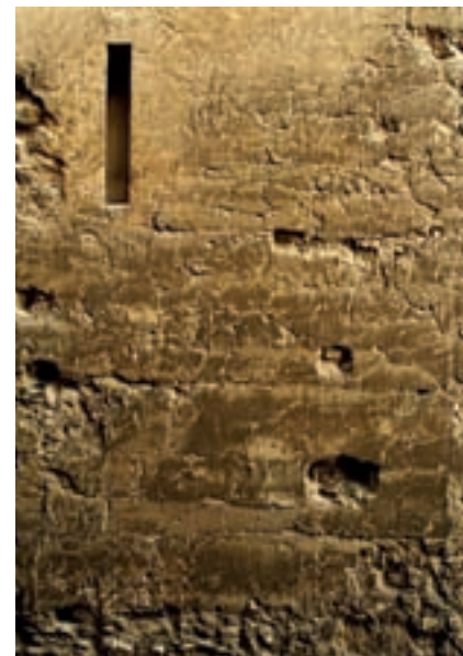
Monasterio de Sijena, torre del Trovador, detalle de la piel del tapial calicostrado original
