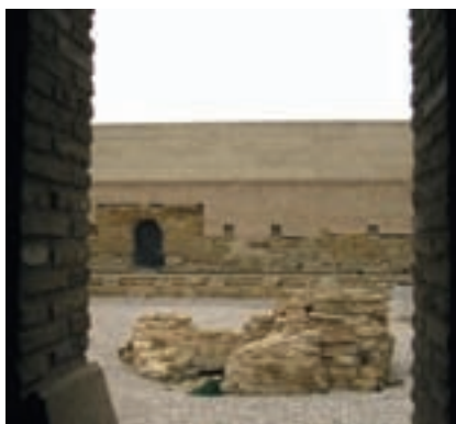
Monasterio de Sijena, vista del fondo oeste de la nave norte después de la intervención, con el cierre realizado con un nuevo tapial de hormigón
