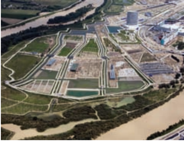
Parque del Agua Luis Buñuel, Zaragoza, 2008
