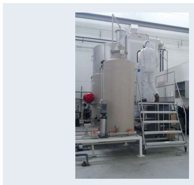
Figura 8.4. Cámara de acero inoxidable de 13 m 3 diseñada para la realización de estudios de exposición y dispersión de nanomateriales con sistema de autolimpieza dual integrado.
