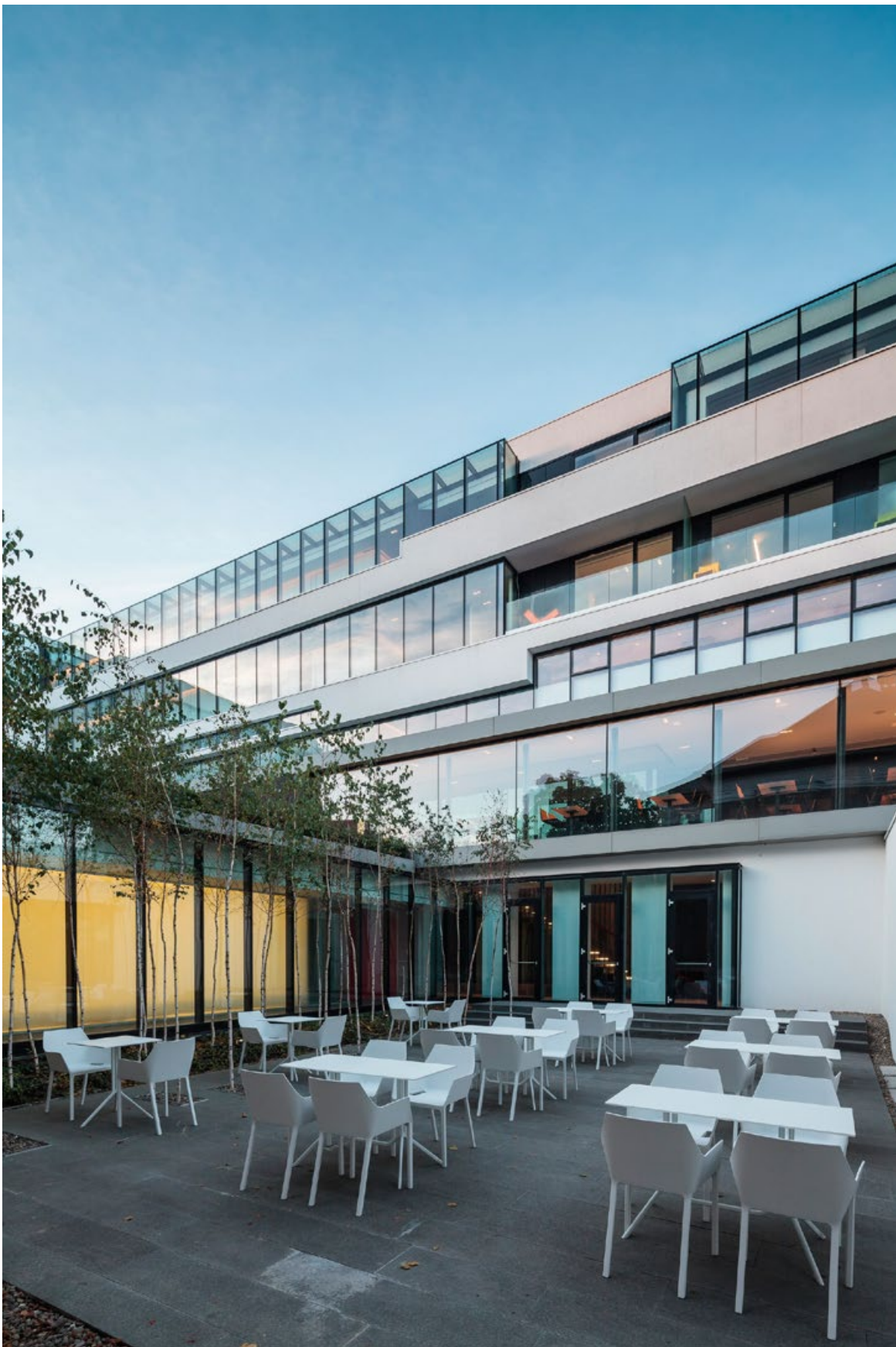
el patio hace de bisagar entre la nueva edificación y el antiguo palacio.
