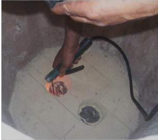
Momento en que se perfora la lamina
