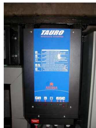
Figura 7. Convertidor de corriente directa a corriente alterna.
