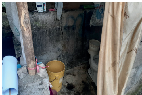
Imagen 14. Cuarto de inodoro adaptado sin tapa
