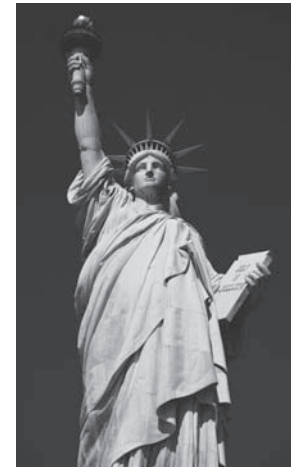
FIGURA 4-25 Reconocible la pátina verde del cobre oxidado en la Estatua de la Libertad
