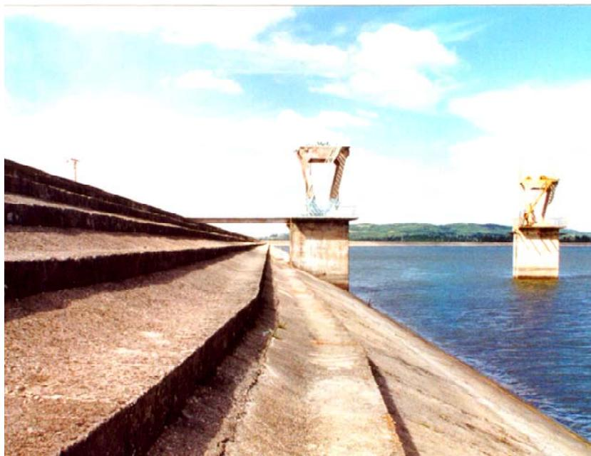
Figura A.6 — Presa Mampostón, Prov. Mayabeque. Revestimiento escalonado de hormigón en el tramo superior del talud, con inclinación  $m=2,25$ .  $H_{presa}=37,00$  m;  $L_{presa}=3,34$  km
