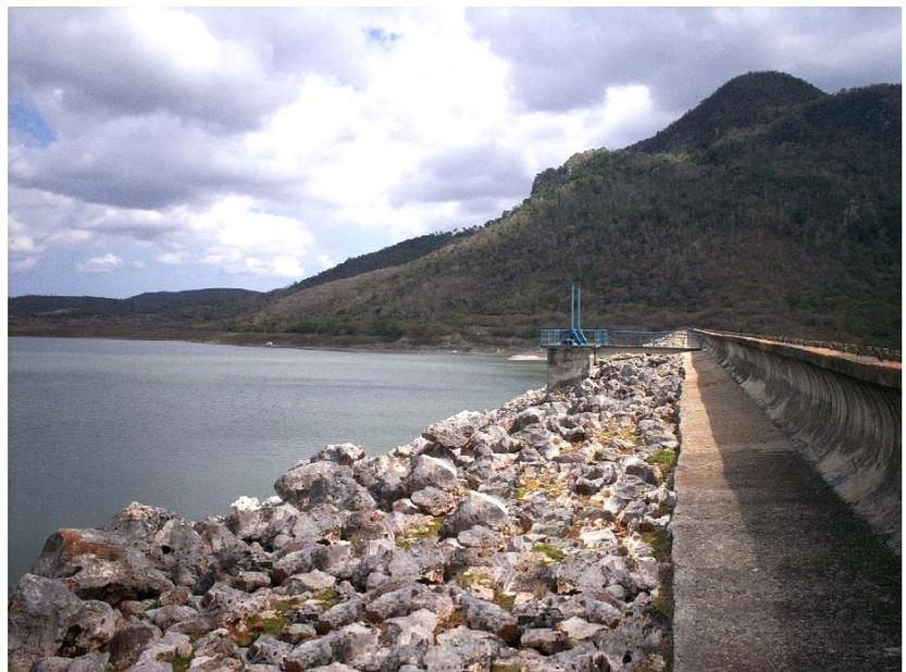
Figura A.12 (izquierda) — Presa Pinillos, Prov. Mayabeque. Revestimiento con enrocamiento de talud con  $m=2,75$ . Corona con parapeto recto con voladizo.  $H_{presa}=20$  m;  $L_{presa}=1,02$  km
