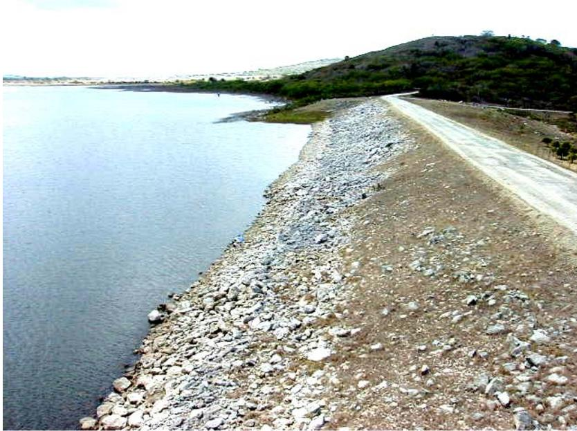
Figura A.7 — Presa Hidráulica Cubana, Prov. Camagüey. Revestimiento con piedras de talud con  $m=3$ . Corona sin parapeto.  $H_{presa}=23,00$  m;  $L_{presa}=0,53$  km
