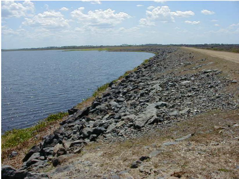
Figura A.9 — Presa La Jía, Prov. Camagüey. Revestimiento con rajón de talud con  $m=3$ . Corona sin parapeto.  $H_{presa}=14,50$  m;  $L_{presa}=2,81$  km
