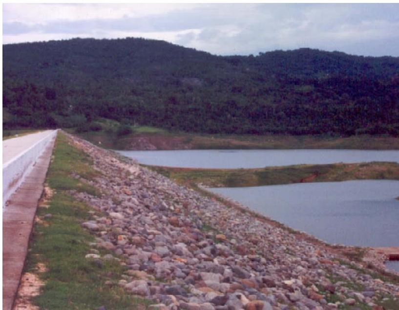
Figura A.8 — Presa Corojo, Prov. Granma. Revestimiento con piedras y rajón de talud con  $m=2,25$ . Corona con parapeto recto.  $H_{presa}=39,60$  m;  $L_{presa}=1,20$  km
