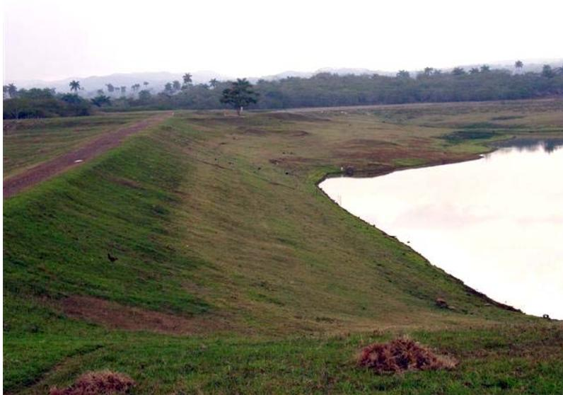
Figura A.5 — Presa Capitán Tomás, Prov. Pinar del Río. Revestimiento con vegetación de talud con  $m=2,5$ . Corona sin parapeto.  $H_{presa}=15,50$  m;  $L_{presa}=0,42$  km
