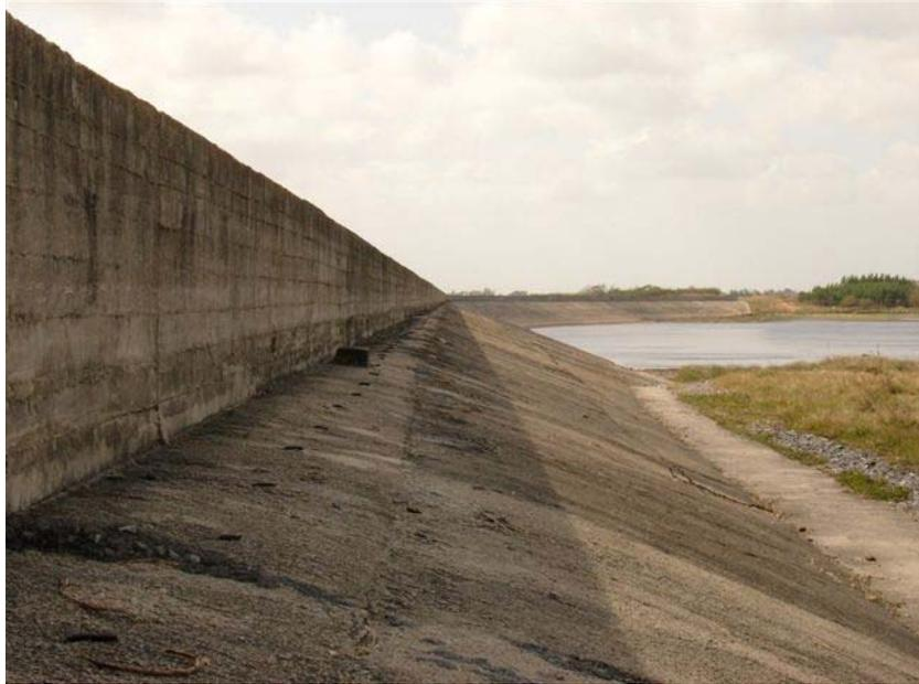
Figura A.3 — Presa Guamá, Prov. Pinar del Río. Revestimiento con hormigón fundido *in situ* de talud con  $m=3$ . Corona con parapeto recto.  $H_{presa}=29,00$  m;  $L_{presa}=2,35$  km
