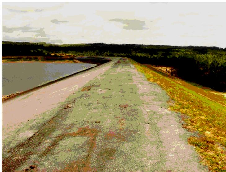
**Figura A.2 — Presa El Mulo, Prov. Pinar del Río. Revestimiento con asfalto sobre enrocamiento de talud con  $m=3$ . Corona sin parapeto.  $H_{pres}= 29,00$  m;  $L_{presa}= 0,65$  km**
