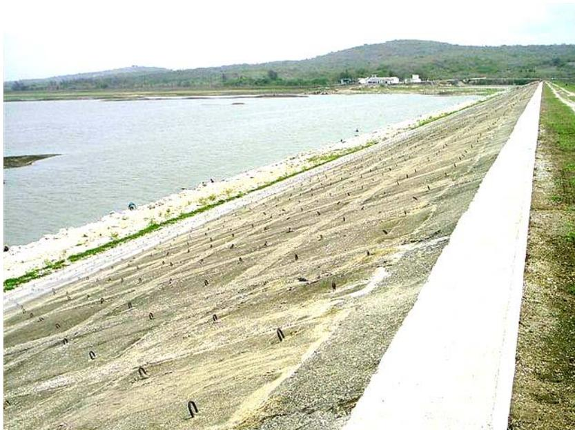
Figura A.4 — Presa Alacranes, Prov. Villa Clara. Revestimiento con losas prefabricadas de hormigón de talud con  $m=2,5$ . Corona sin parapeto.  $H_{presa}=24,50$  m,  $L_{presa}=1,6$  km
