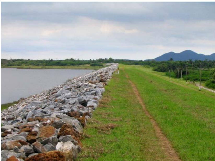
Figura A.10 — Presa La Fe, Mun. Isla de la Juventud. Revestimiento con enrocamiento de talud con  $m=3$ . Corona sin parapeto.  $H_{presa}=22,13$  m;  $L_{presa}=2,22$  km
