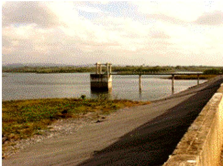
**Figura A.1 — Presa El Rancho, Prov. Pinar del Río. Revestimiento con asfalto de talud con  $m=2,5$ . Corona con parapeto recto.  $H_{presa}=30,30$  m;  $L_{presa}=0,59$  km**
