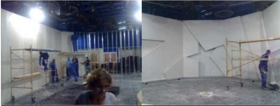
Construcción del Aforo
