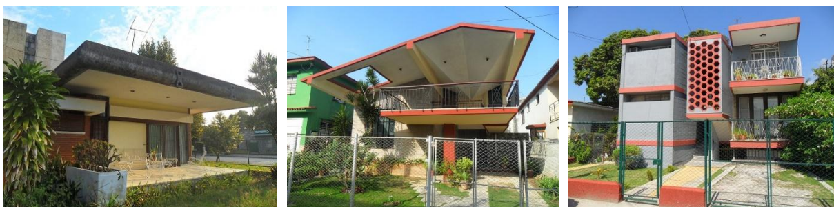
Figuras 3a, 3b y 3c: Casas diseñadas por los arquitectos Armando Gutiérrez para Santa Catalina (izquierda), Olga Echezarreta para Alturas de Palatino (centro), y Enrique Gutiérrez para Casino Deportivo (derecha). Fuente: Autores, 2016
