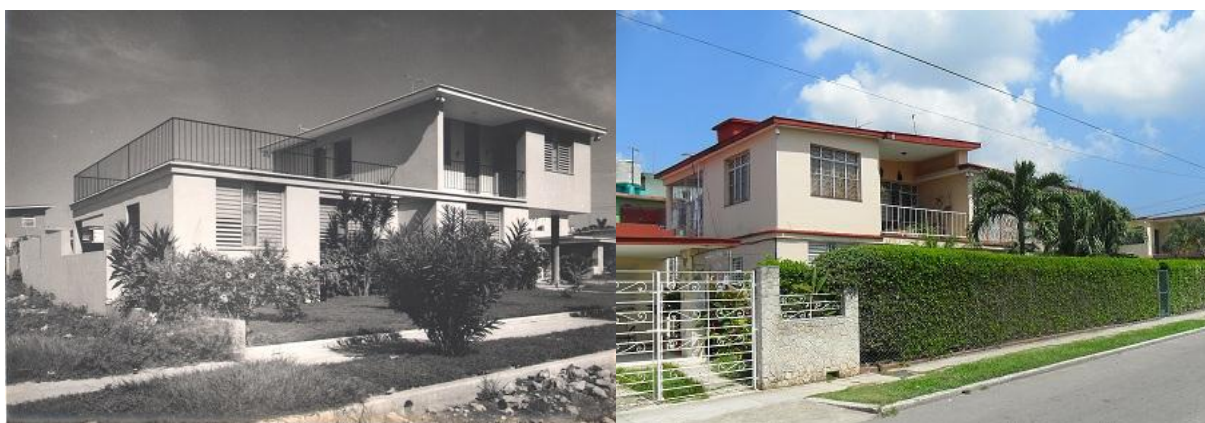
Figuras 8 y 9: Casa proyectada por el arquitecto Frank Mustelier en el Casino Deportivo. Izquierda: Obra original, 1955. Fuente: Archivo personal de Frank Mustelier, cedida por Florencia Peñate. Derecha: Imagen actual. Fuente: Autores, 2016.
