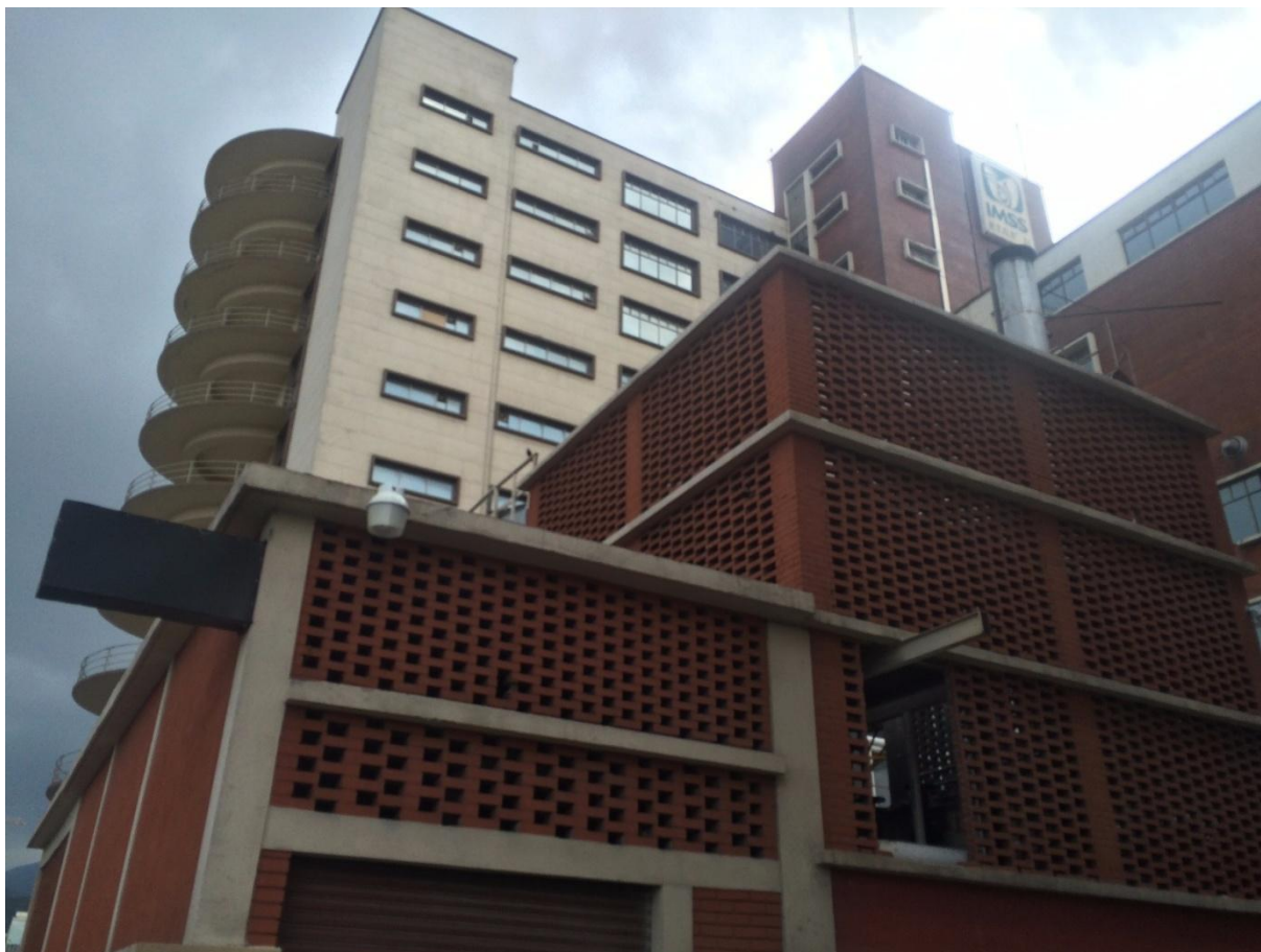
Fotografía 7. Celosía de arcilla en Hospital del IMSS.
