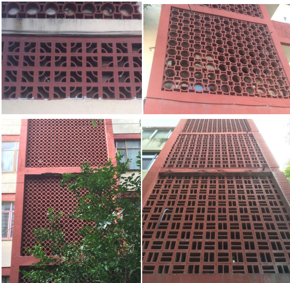
Fotografía 1, 2, 3 y 4. Celosías de concreto en Condominios Constitución, Monterrey, Nuevo León, México.
