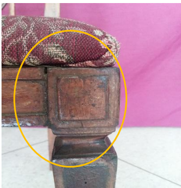
Fig. 28. Ensamble continuo que garantiza transmisión de diferentes esfuerzos (compresión y flexión).
