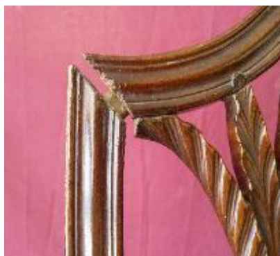
Fig. 36. Ensamble desplazado.
