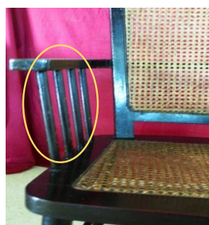
Fig. 32. Ensamblés de compresión. Funcionan como uniones articuladas.
