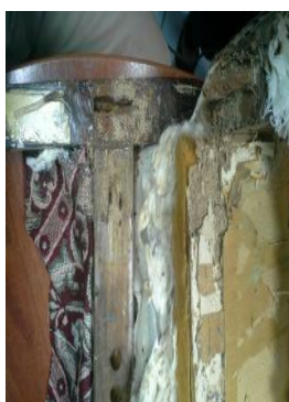
Fig. 41. Deterioros del tablero de fondo por la presencia de termitas de madera seca.
